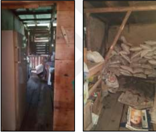
Resim 4.45. Karaşar Mahallesi 156/ 7 ve 293/ 4 geleneksel konut ahır
