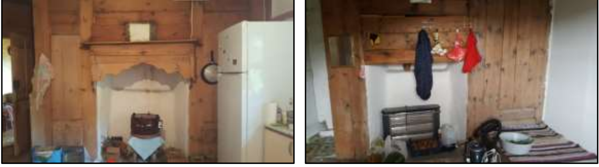
Resim 4.51. Karaşar Mahallesi 156 / 9 ve 156 / 7 geleneksel konut ocak
