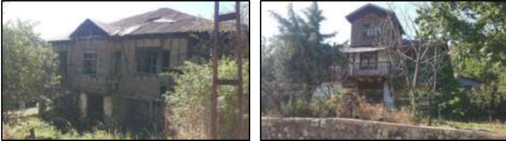
Resim 4.59. Karaşar Mahallesi 50 ve 227 envanter nolu ev çıkma
