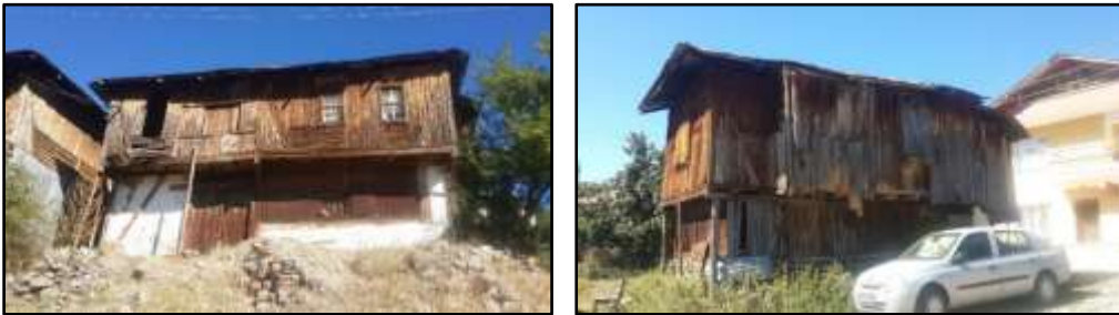
Resim 4.60. Karaşar Mahallesi 97 ve 142 envanter nolu ev çıkma
