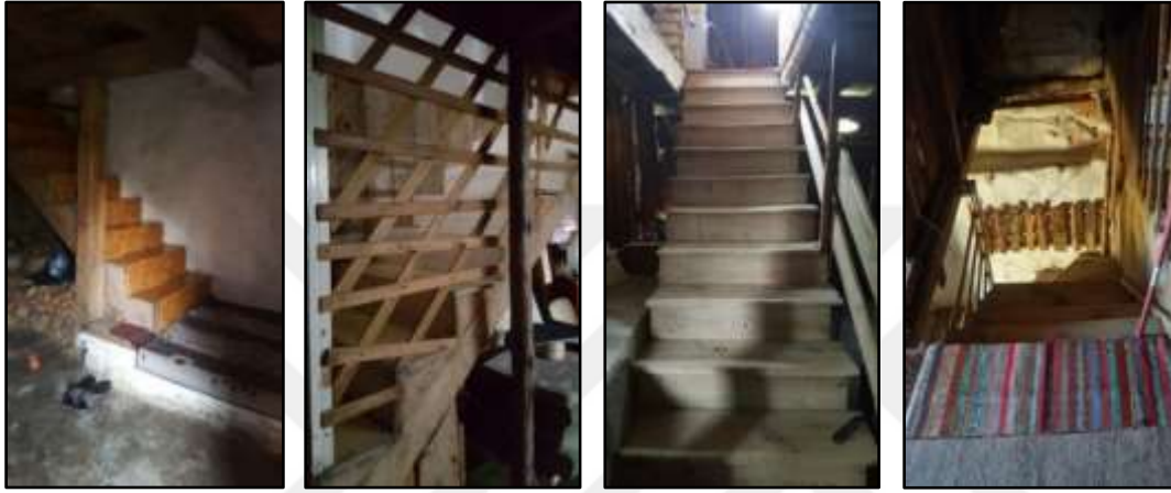
Resim 4.46. Karaşar Mahallesi 156 /7, 156 /9,157/2 ve 293/4 geleneksel konut merdiven
