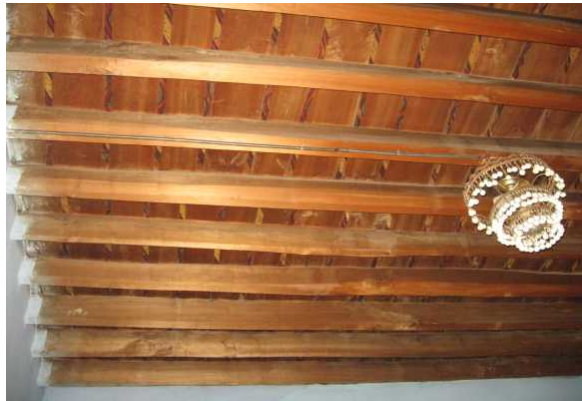
Resim 3.32. Dikdörtgen ahşap kirişle ile oluşturulmuş tavan örneği -katalog no: 20
