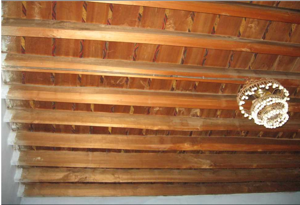
Resim 3.11. Dikdörtgen ahşap kirişle ile oluşturulmuş tavan örneği -katalog no: 20
