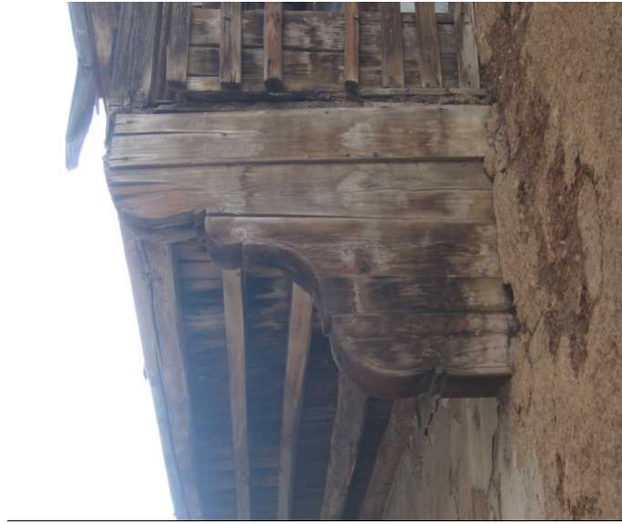
Resim 3.33. ıkmalarda kiriş işlevi gören ahşabın altına eklenen oymalı ahşap örneđi-katalog no: 19
