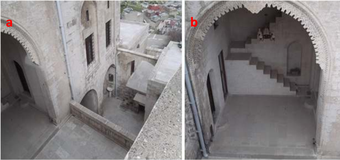
Şekil 6.3. Avlu ve eyvan taş döşeme
