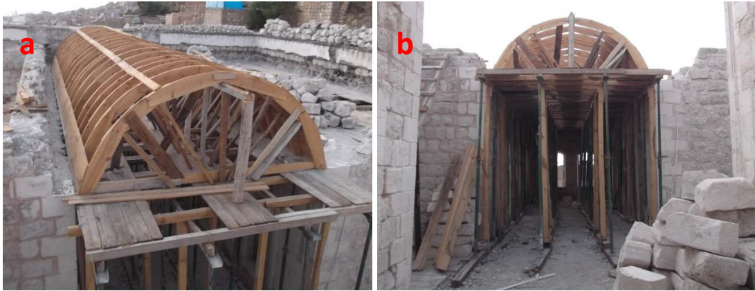
Şekil 6.31. Günümüzde yapılan tonoz kalıplarından örnekler
