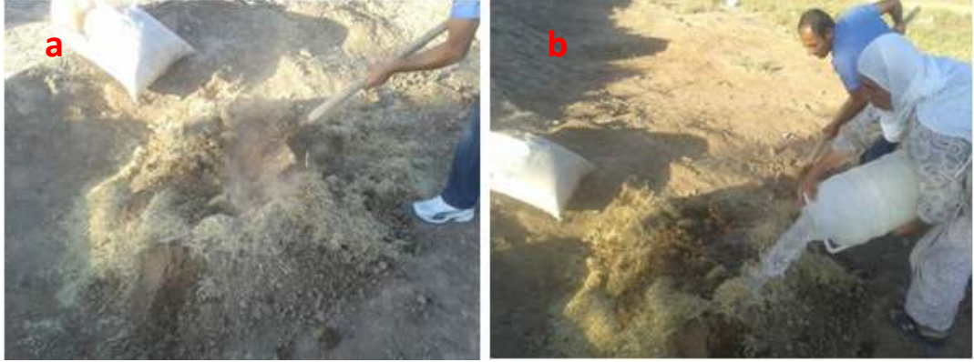
Şekil 5.3. Kerpiç harcının hazırlanışı
