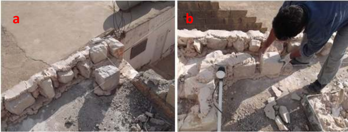
Şekil 6.65. İp Dolabının yatayına duvar örgüsünde kullanılması
