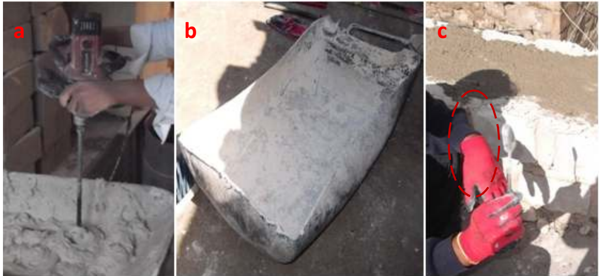
Şekil 6.71. Mikser; harç karıştırıcı (a), harç teknesi (b), derz kaşığı (c)
