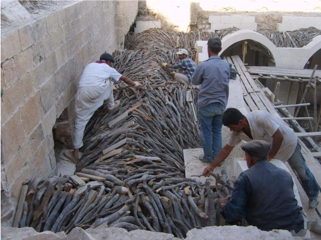
Şekil 6.25. Tonoz Kalıplarının Kurulması (Dalkılıç ve Halifeoğlu, 2010)
