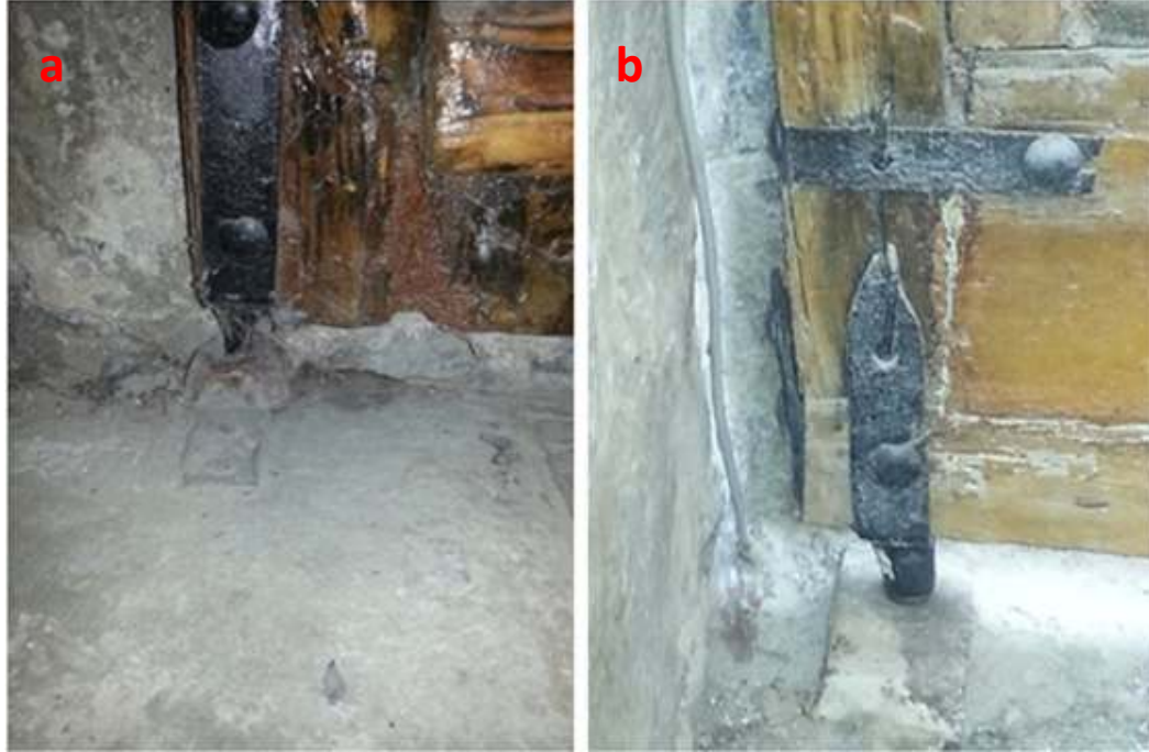
Şekil 6.42. Kapı yapım detayı-alt
