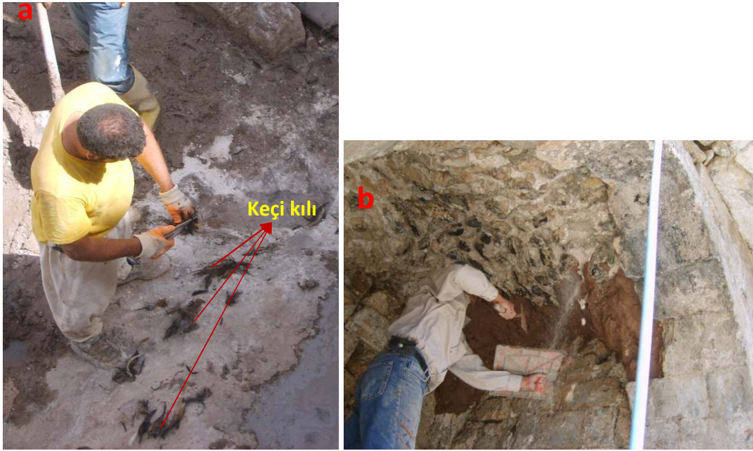
Şekil 5.32. Kaba sıvanın hazırlanması ve uygulanması (Dalkılıç ve Halifeoğlu, 2010)
