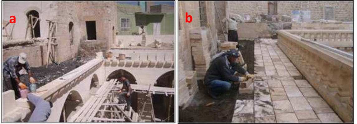
Şekil 6.28. Teras kenarına silme, taş korkulukların (a) ve teras döşemesinin yapımı (b)
