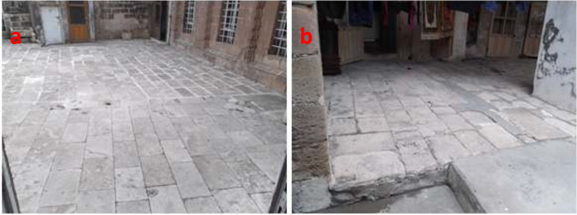
Şekil 6.2. Avlu taş döşeme
