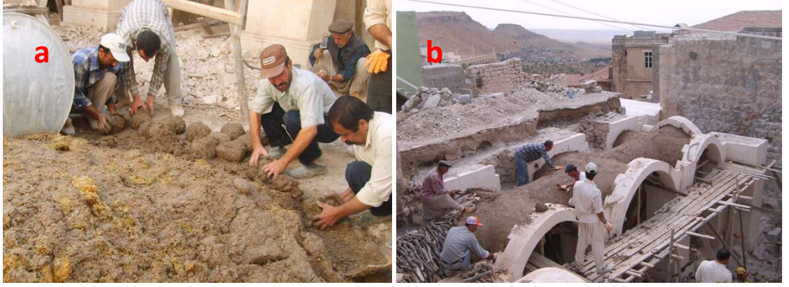
Şekil 6.26. Çamur harcının hazırlanması (a) ve meşe dalları üzerine serilerek (b) tonozun oluşturulması
