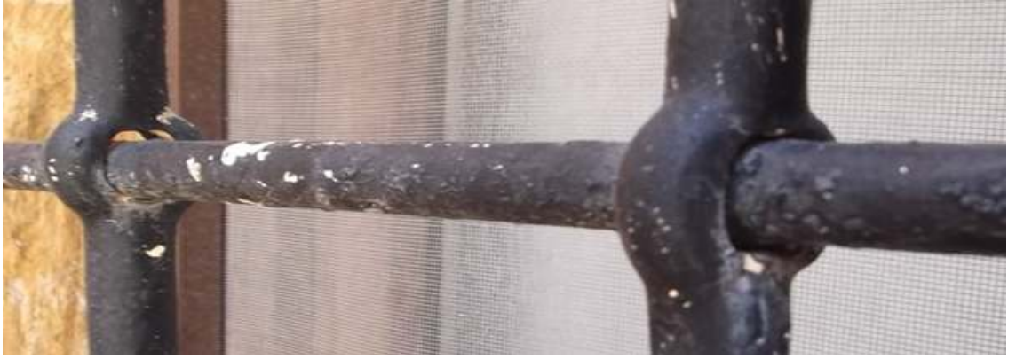
Şekil 5.17. Pencere şebekesinde açılan demir delikleri
