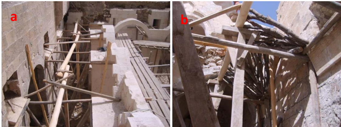
Şekil 6.23. Revak Tonoz Kalıplarının Çatkısının Hazırlanması (Dalkılıç ve Halifeoğlu 2010)
