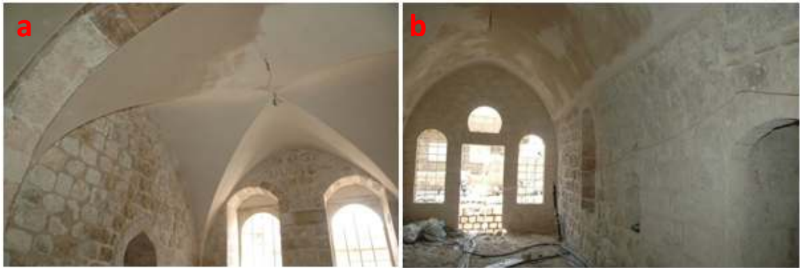
Şekil 5.33. Tonoz çeşitlerinin duvar birleşim noktalarına kadar sıvanması
