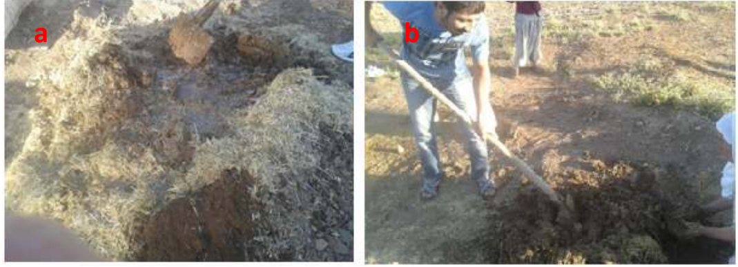
Şekil 5.4. Harcın kürekle karıştırılması(a) ve elle yoğrulması (b)
