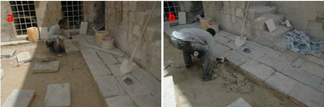
Şekil 6.4. Avlu taş döşeme yapımı
