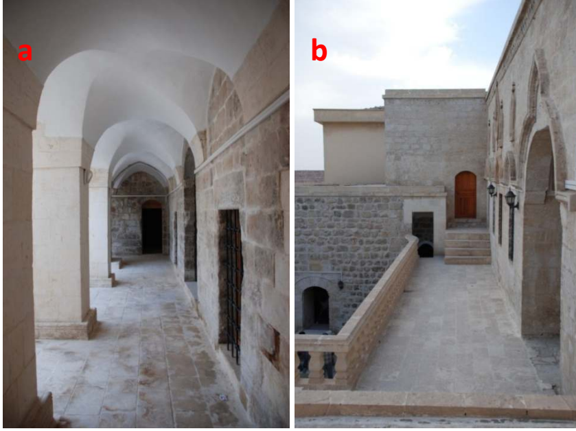
Şekil 6.29. Tonozun ve üstündeki teras döşemesinin bitmiş durumu (Dalkılıç ve Halifeoğlu 2010)
