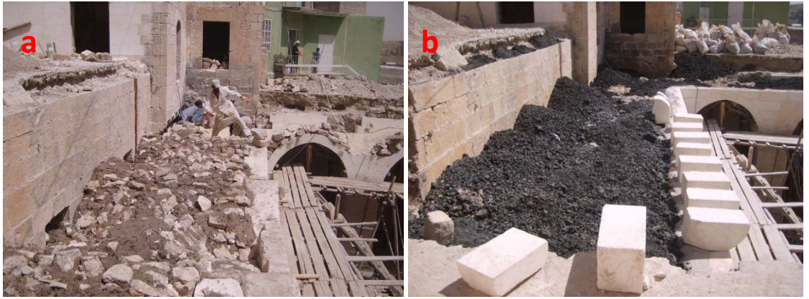
Şekil 6.27. Çamur harç üzerine moloz taşların kılıcına yerleştirilmesi (a) ve cürufun doldurulması (b)
