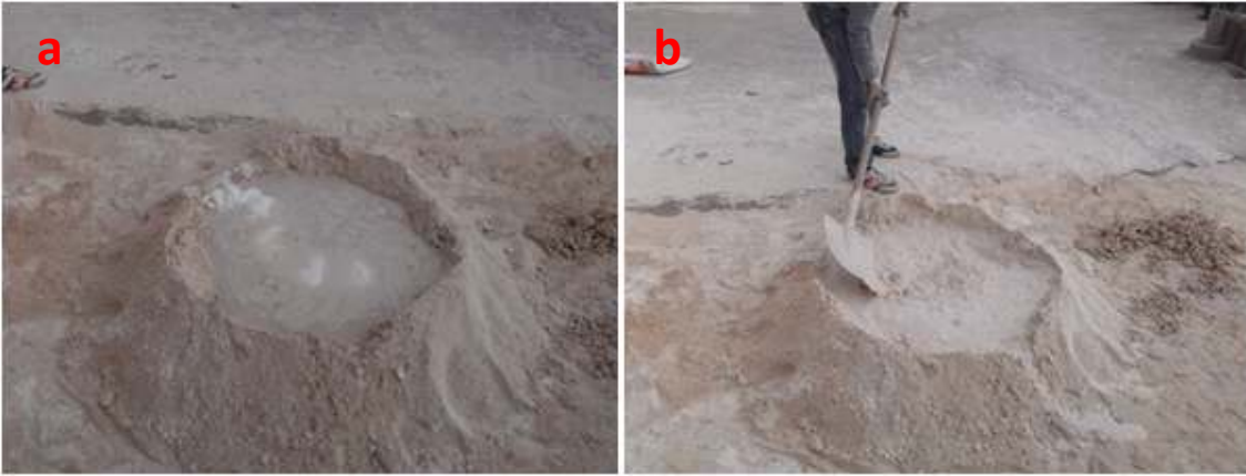
Şekil 5.31. Taş tozu (ınkara-nıkkara), kaymak kireç ve sudan oluşan harç
