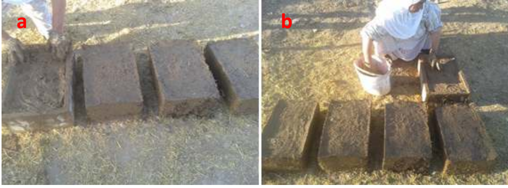
Şekil 5.7. Kalıp yüzeyinin elle sıvazlanması
