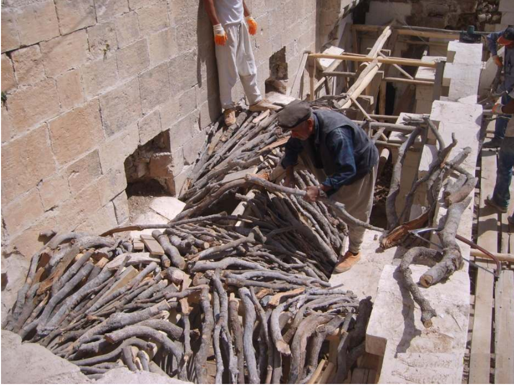
Şekil 6.24. Revak Tonoz Kalıplarının Kurulması (Dalkılıç ve Halifeoğlu, 2010)
