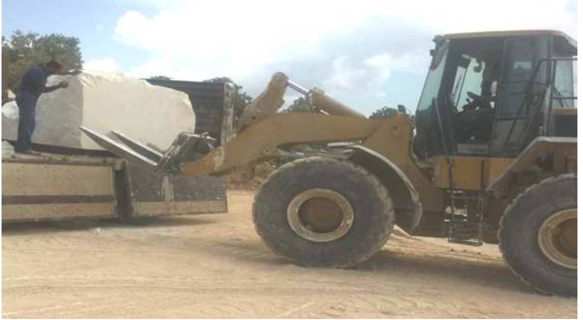
Şekil 7.29. Ekskavatör ile blok taşların kamyonu bindirilip işlenmek üzere atölyeye taşınması
