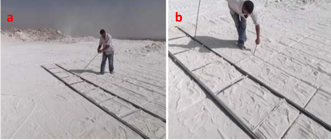
Şekil 7.30. Metal rayların kurulması
