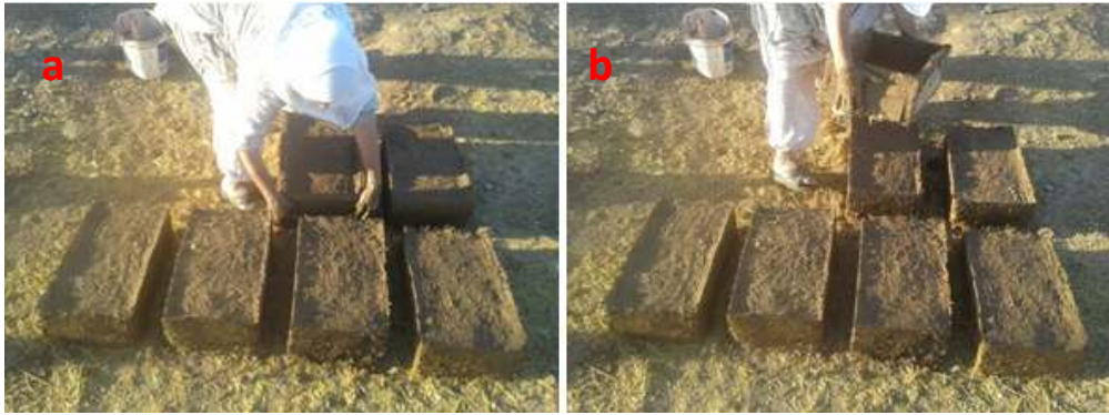
Şekil 5.8. Kalıbın çıkarılması
