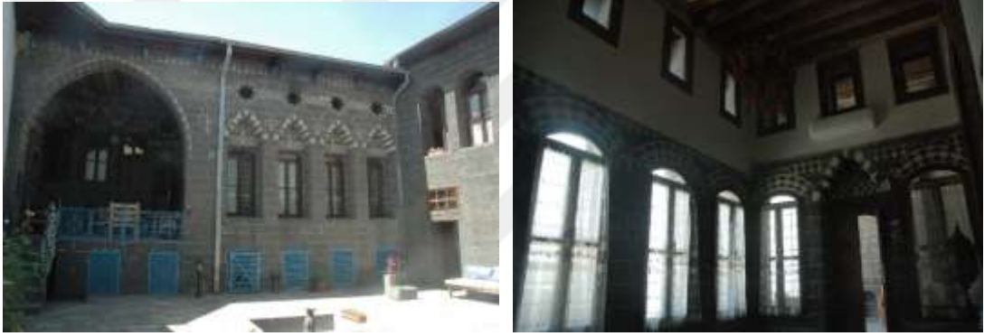
Şekil 2. 43 Diyarbakır geleneksel evleri ,Cevat paşa mah. Kozluk sokak
