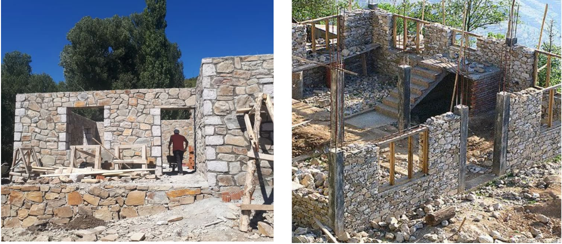
Şekil 15. Taş yığma yapı sisteminin genel görünümü
