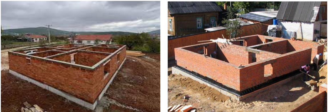
Şekil 16. Tuğla yığma yapı sisteminin genel görünümü
