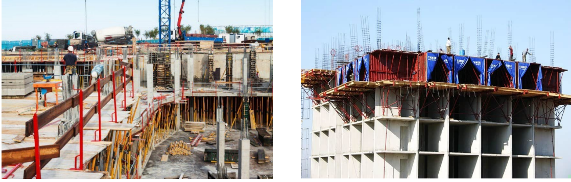
Şekil 9. Betonarme yapı sisteminin genel görünümü
