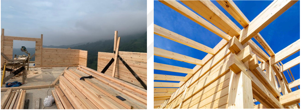
Şekil 11. Ahşap yığma yapı sisteminin genel görünümü
