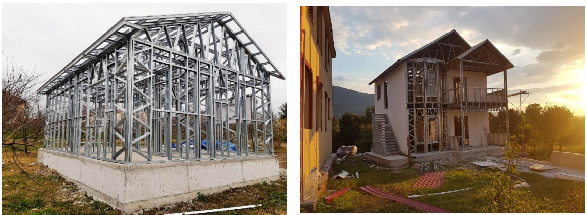
Şekil 19. Hafif çelik prefabrike yapı sisteminin genel görünümü
