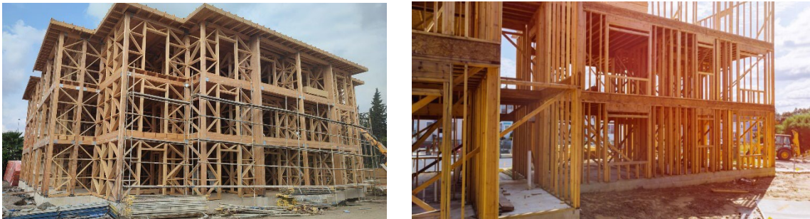
Şekil 13. Payandalı ahşap yapı sisteminin genel görünümü
