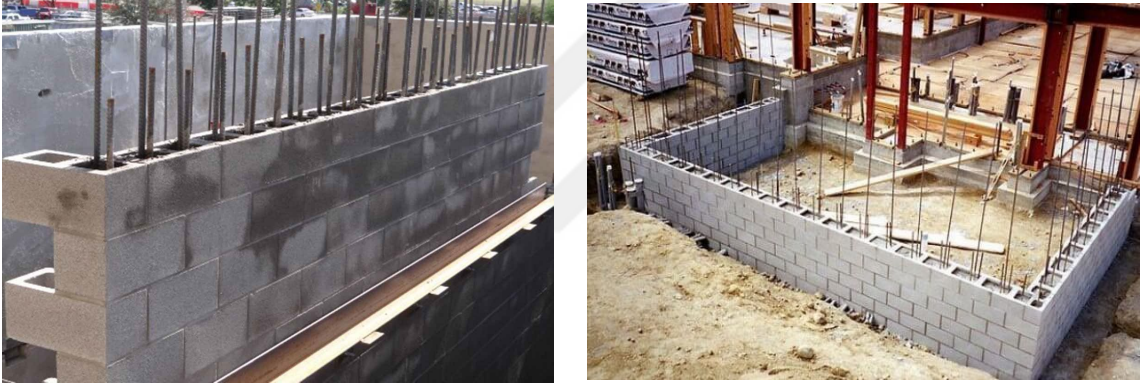
Şekil 17. Donatılı tuğla yığma yapı sisteminin genel görünümü
