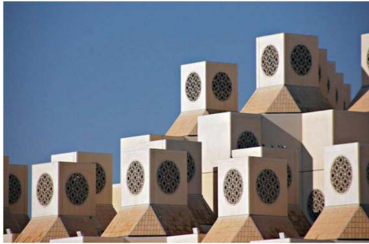
Şekil 1.26. Katar Üniversitesi'nde uygulanan rüzgar kuleleri [82].
