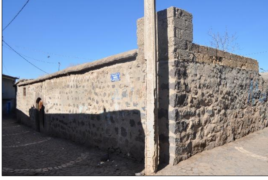
Şekil 4.102. Sokak cephesi (Hatipoğlu 2016)
