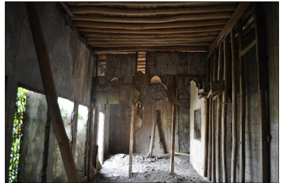
Şekil 4.69. Yukarı katta neredeyse çökmüş olan oda (Hatipoğlu 2016)
