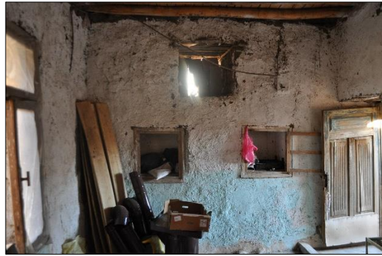
Şekil 4.113. Nişler ve tepe penceresi (Hatipoğlu 2016)
