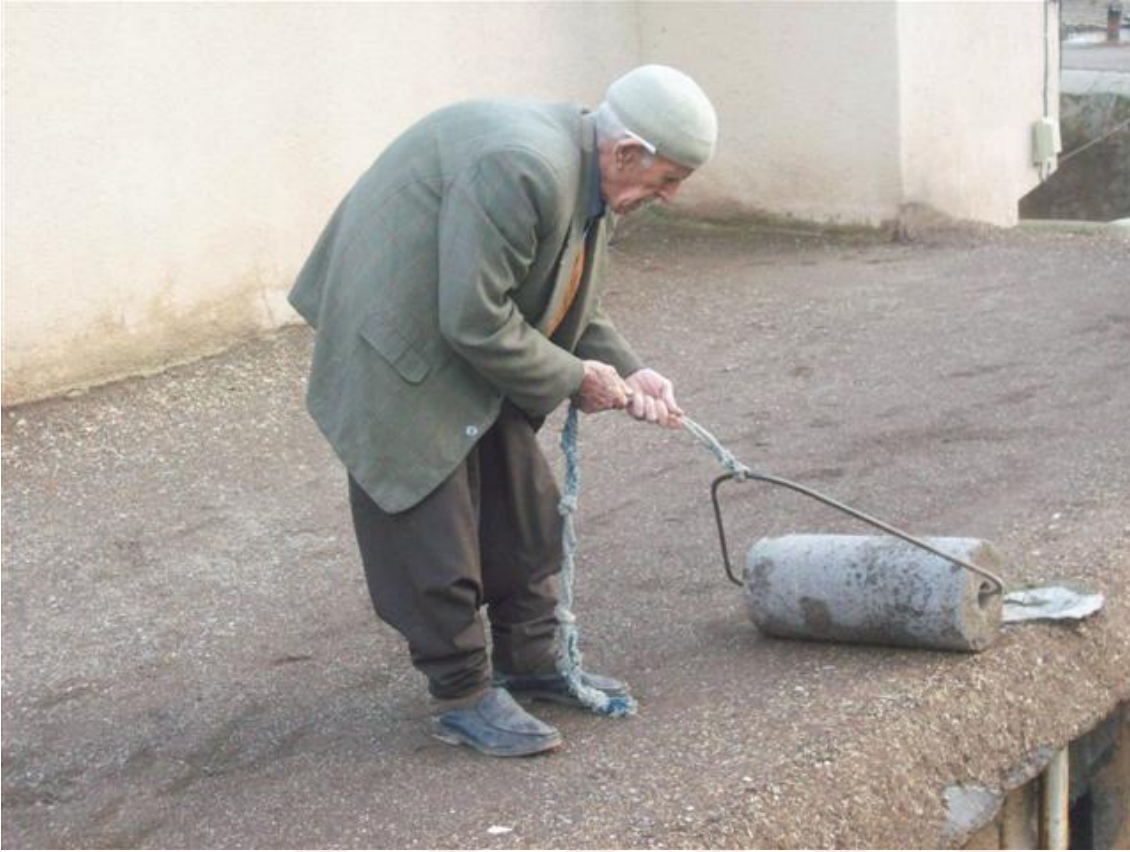
Çizelge 4.29. Geleneksel Siverek Evlerinde damlardaki toprağı sıkıştırmak için kullanılan loğ (URL-11)
