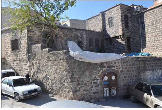
Şekil 4.114. Sokak cephesi ve sokak kapısı
