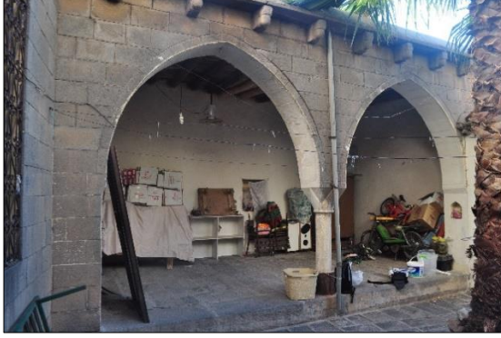
Şekil 4.89. Avlunun güneyinde bulunan eyvan (Hatipoğlu 2016)
