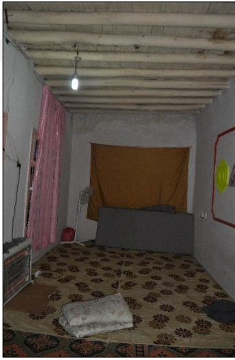
Şekil 4.79.Ahşap kiriş tavanlı oda(Hatipoğlu 2016)
