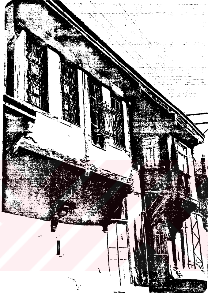
Fotoğraf 10. Payanda veya kiriş başlıkları ahşap kaplama ile profillendirilmiş çıkma (Kar. 1-1).
