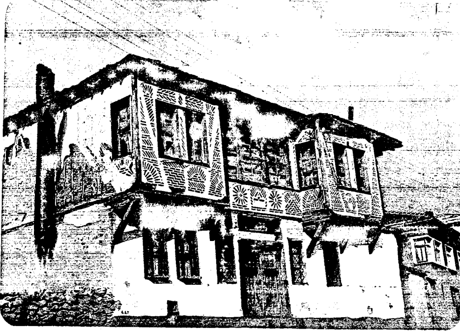
Fotoğraf 8. Payandaları duvar içindeki hatıllara veya dikmelere oturmuş çıkma (Yen. 1-1).
