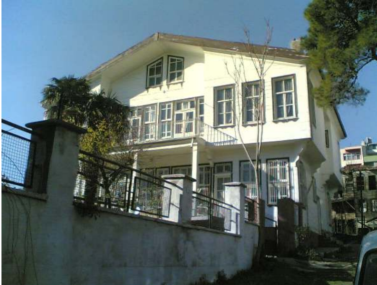
Resim 3.34. On bir numaralı evin arka cephesi [Gümüş, 2006]
