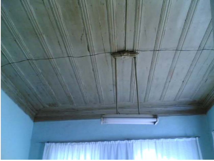
Resim 2.20. Birçok evde kullanılan düz tavan [Gümüő, 2006]
