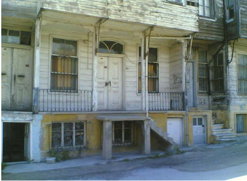
Resim 2.4. Birinci kattaki sokak kapılarına göre zemin kattaki kapıların yükseklik durumları [Gümüş, 2006]
