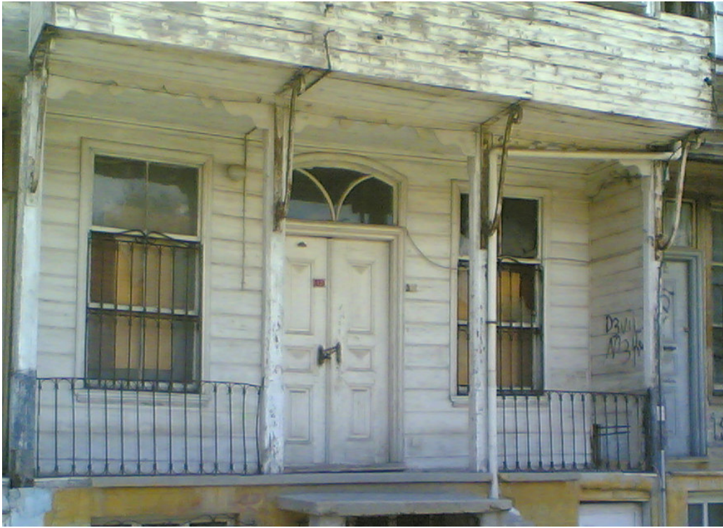
Resim 2.11. Cumbaların ahşap sütunlarla desteklenmesi [Gümüş, 2006]
