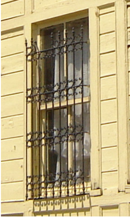
Resim 2.6. Düz demir çubuklardan yapılan parmaklıklar [Gümüş, 2006]
