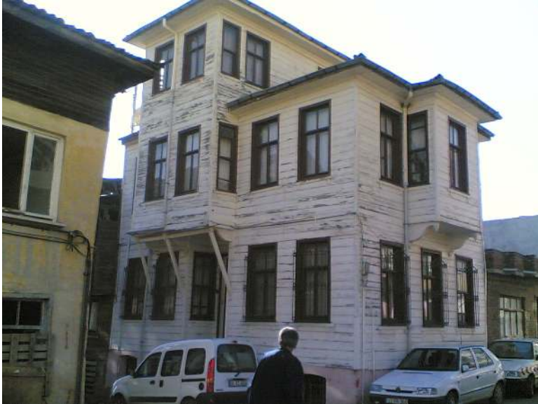
Resim 3.50. On yedi numaralı evin ön ve yan cephesi [Gümüş, 2006]
