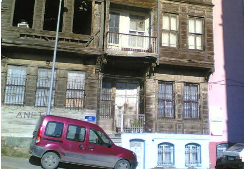
Resim 3.53. Yirmi numaralı evin ön cephesi [Gümüş, 2006]
