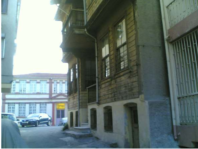
Resim 2.17. Zemin katın diğer katlara göre yüksekliği ve pencere üstlerinin eğimli yapılmasına bir örnek [Gümüş, 2006]
