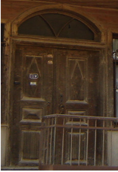
Resim 2.3. Sofayı aydınlatmak için kapı üzerine yapılmış pencere örneği [Gümüş, 2006]
