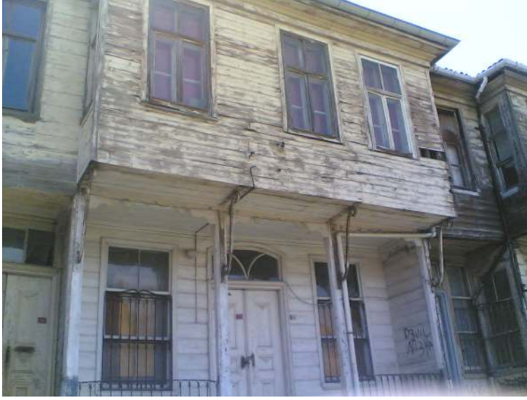
Resim 3.17. Beş numaralı evin ön cephesi [Gümüş, 2006]
