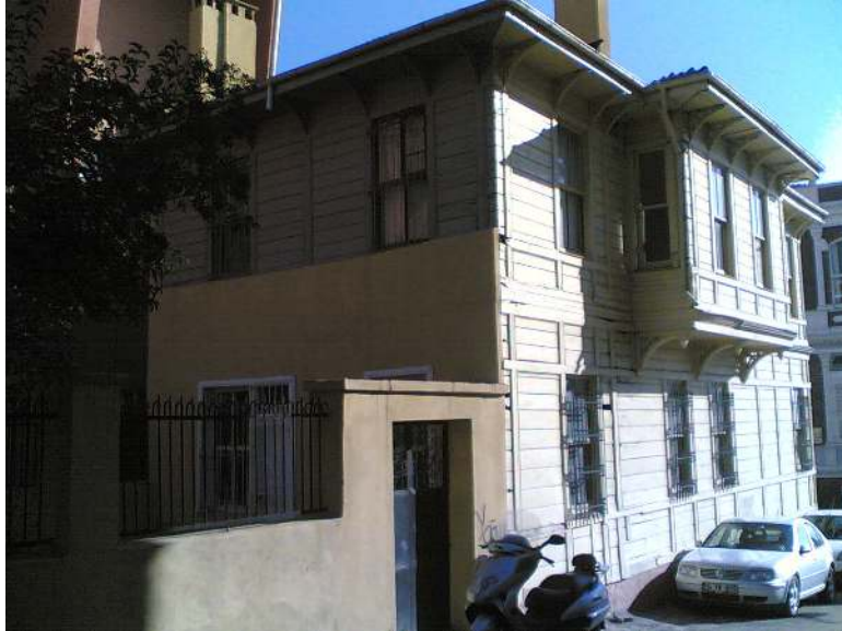
Resim 3.40. On iki numaralı evin arka cephesi [Gümüş, 2006]
