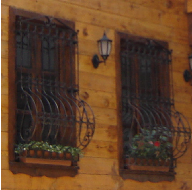
Resim 2.7. Dışa bombeli biçimde yapılan cumba parmaklıkları [Gümüş, 2006]
