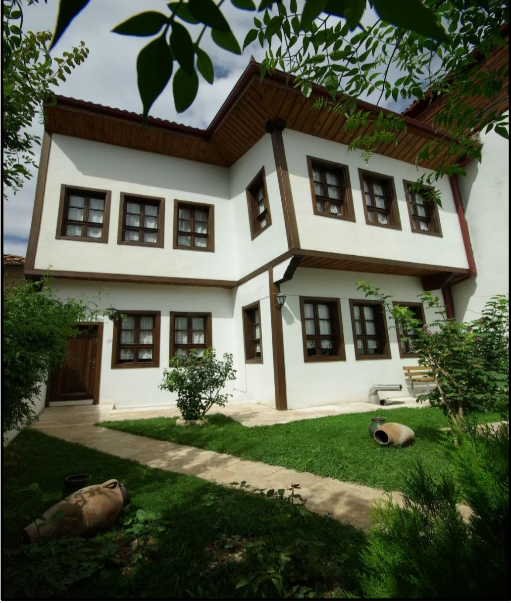
Resim- 10 Bahe ve arka cephe.
