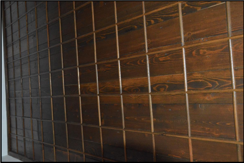
Resim- 44 Üst kat (102 numaralı oda) çitekâri tavan.
