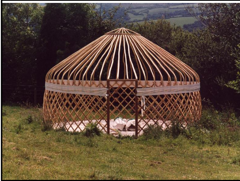
Fotoğraf- 6 Çatı ve Duvar İskeleti Görünümü
