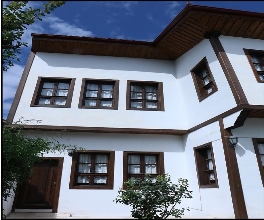
Resim- 9 Restorasyon sonrası arka cephe.
