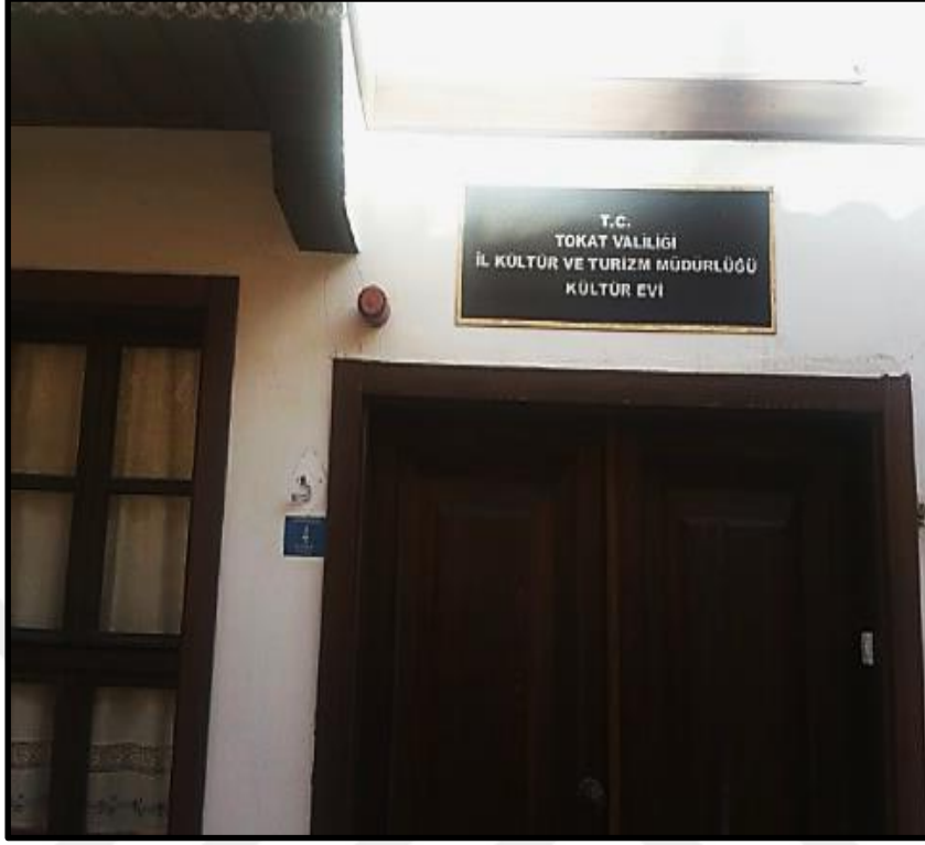
Resim- 6 Restorasyon sonrası kapı girişi.
