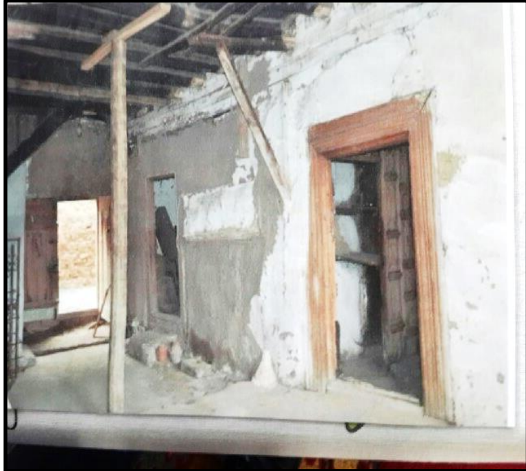
Fotoğraf- 15 Restorasyon Öncesi Giriş Kat
