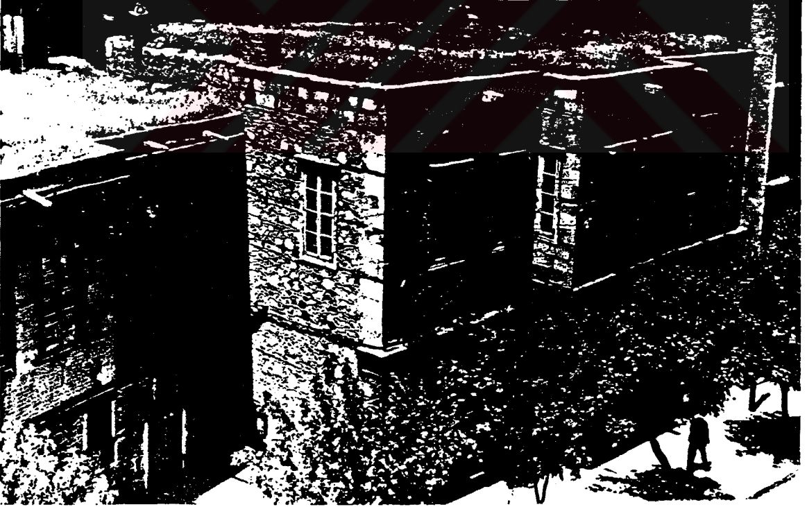
Şekil 3-9. Ahşap hatıllı taş kullanımı Erzurum[12, s.38]
