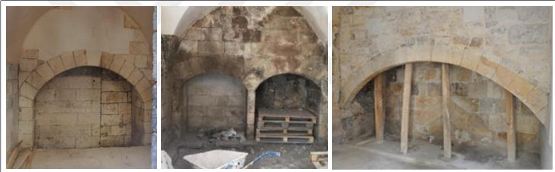
Şekil 5.45. Ocaklarda kullanılan kemerler
