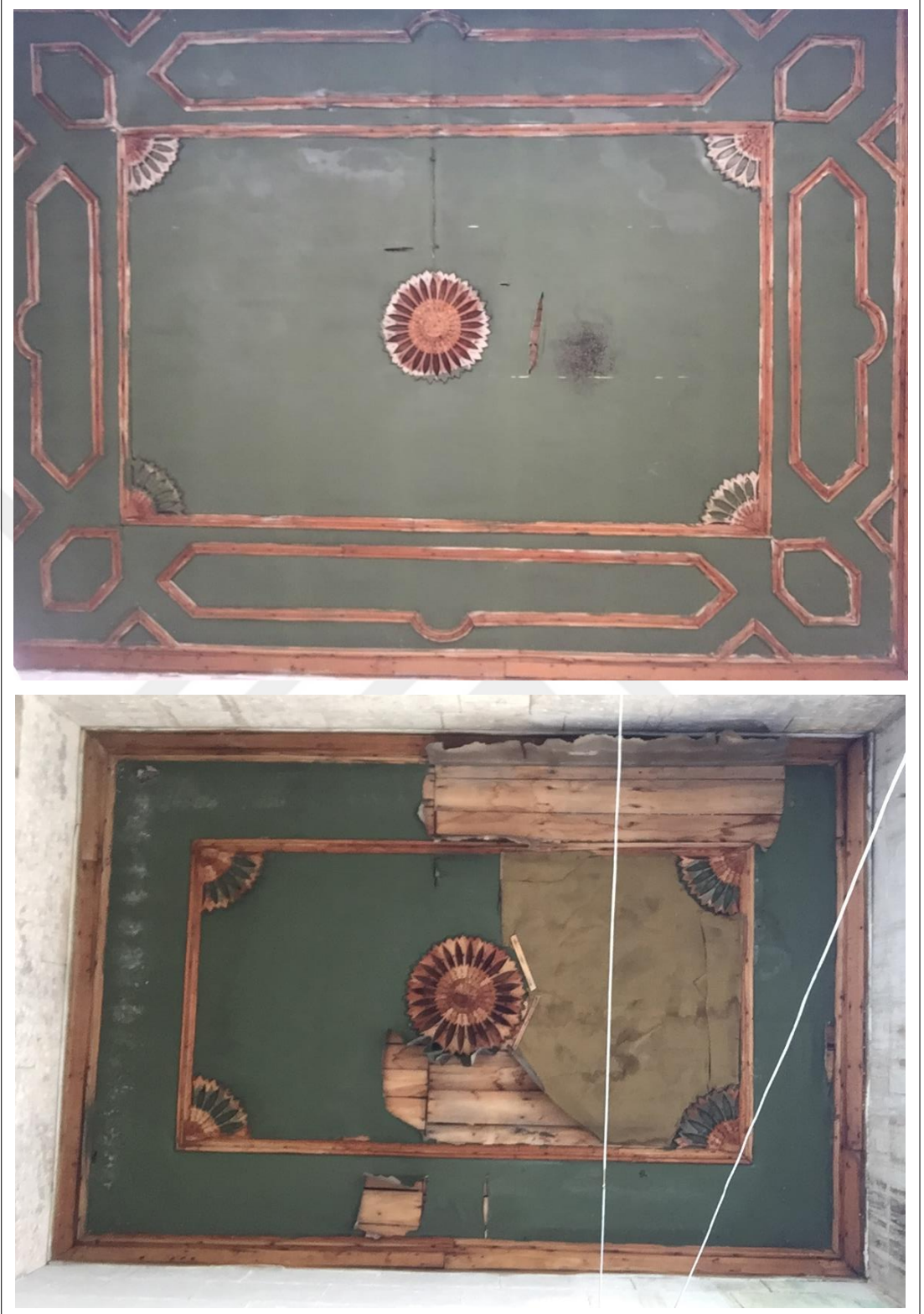
Şekil 5.73. Düz ahşap kaplama tavanların üzerinin kumaş gerilerek kaplandığı, üzerine çıtalarla ve ajur tekniği ile çeşitli süslemelerin yapıldığı tavanlar
