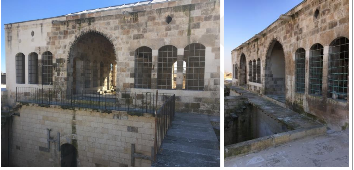
Şekil 5.84. Geleneksel Urfa evinde bir gezenek örneği
