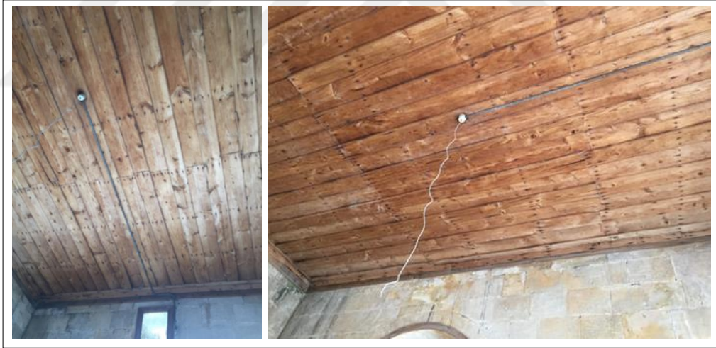
Şekil 5.69. Frezelenmiş ahşapların altlı üstlü çakılmasıyla yapılan düz ahşap kaplama tavan
