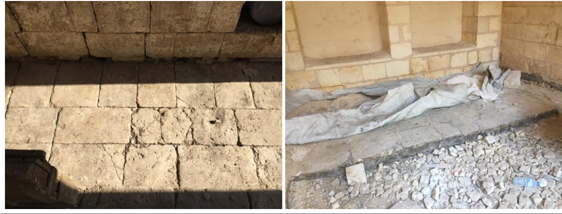
Şekil 5.55. Taş döşenmiş oda döşemesi
