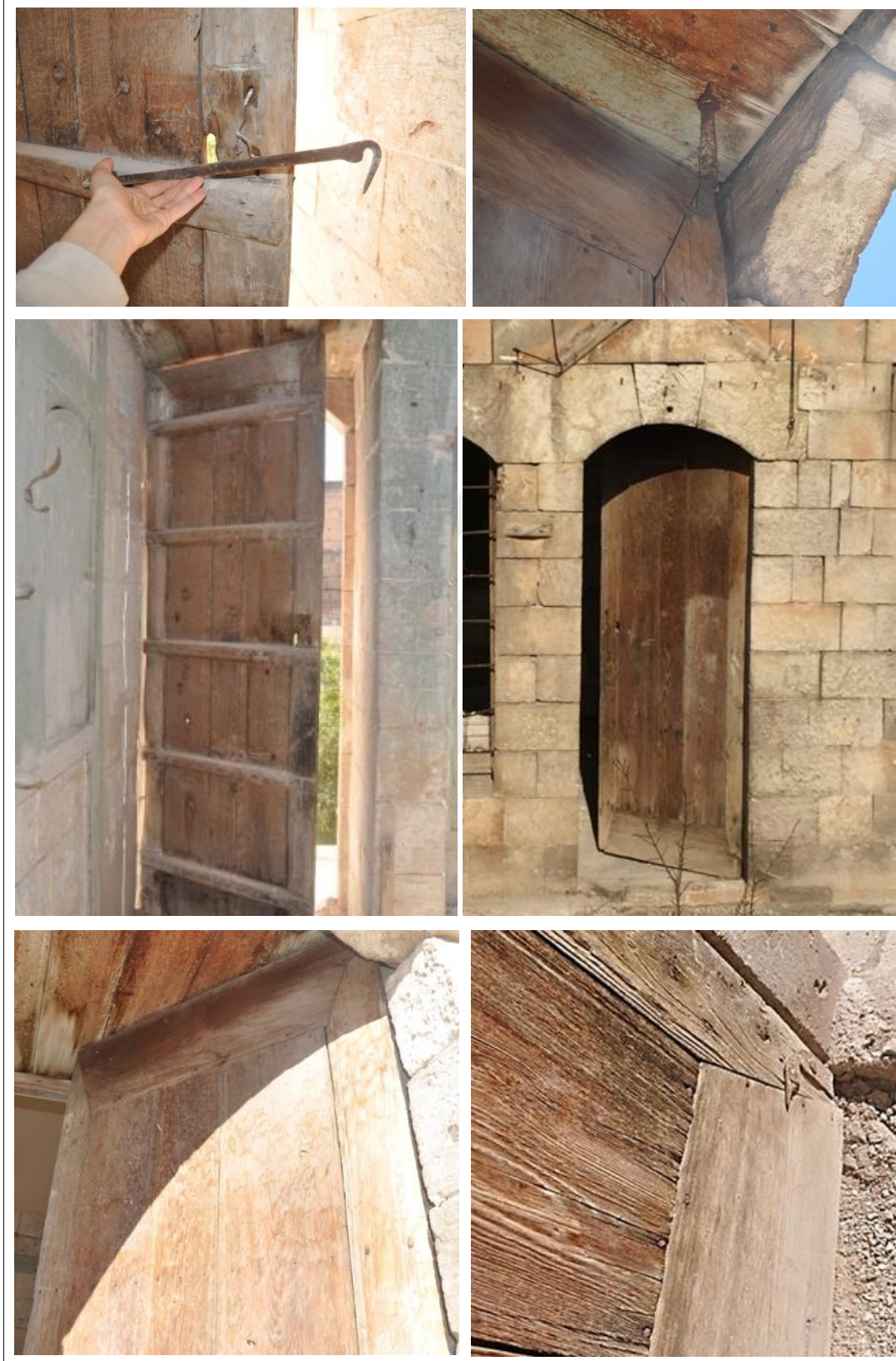
Şekil 5.98. Geleneksel Urfa evindeki bir oda kapısı detayı
