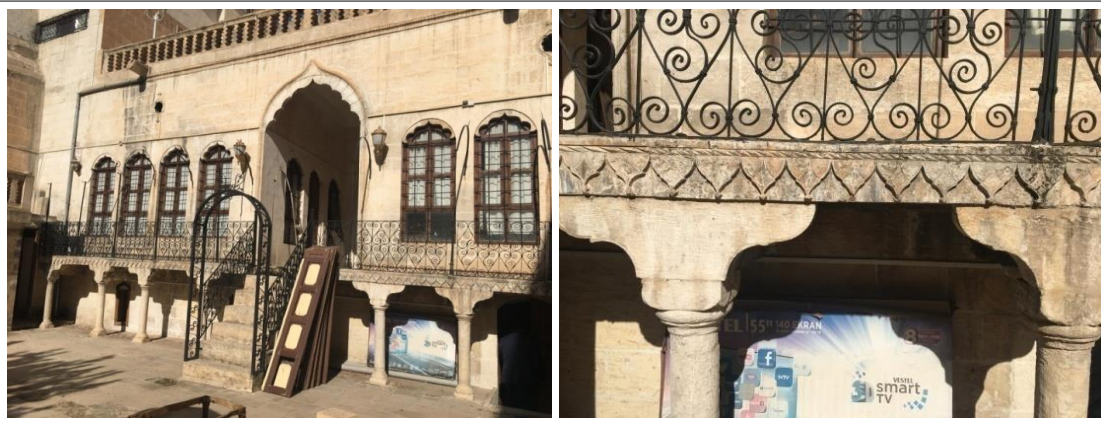
Şekil 5.87. Geleneksel Urfa evinde bir gezenek örneği
