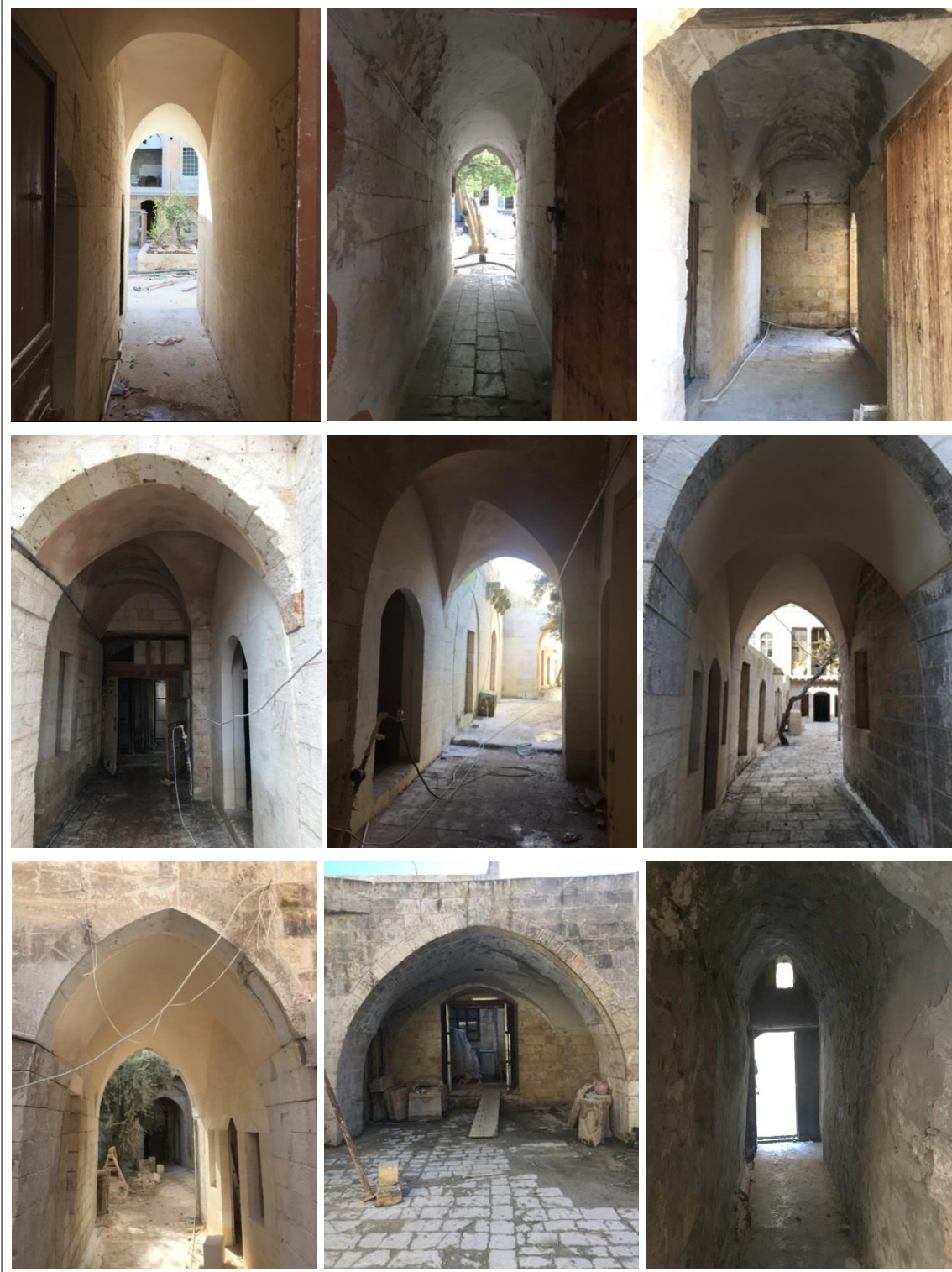
Şekil 5.61. Kapı arasında kullanılan tonozlar
