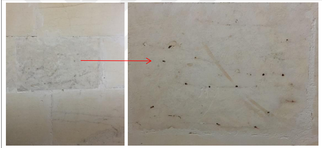
Şekil 5.57. Bazı döşemelerde kullanılan “Benekli taş”
