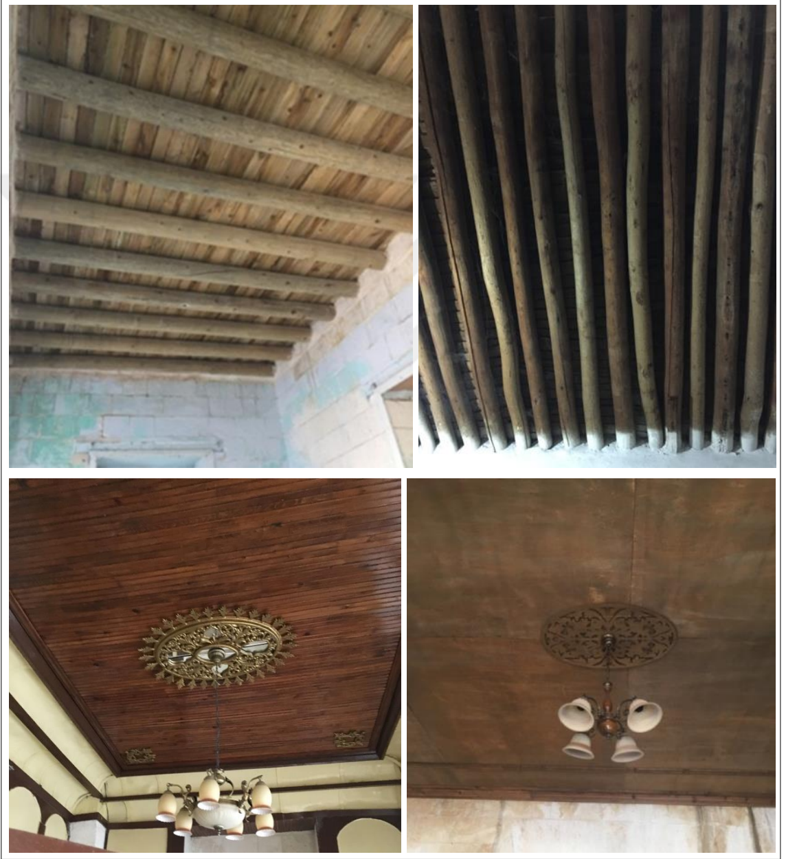
Şekil 4.18. Tavanlarda kullanılan ahşap malzeme ve ahşap kirişler
