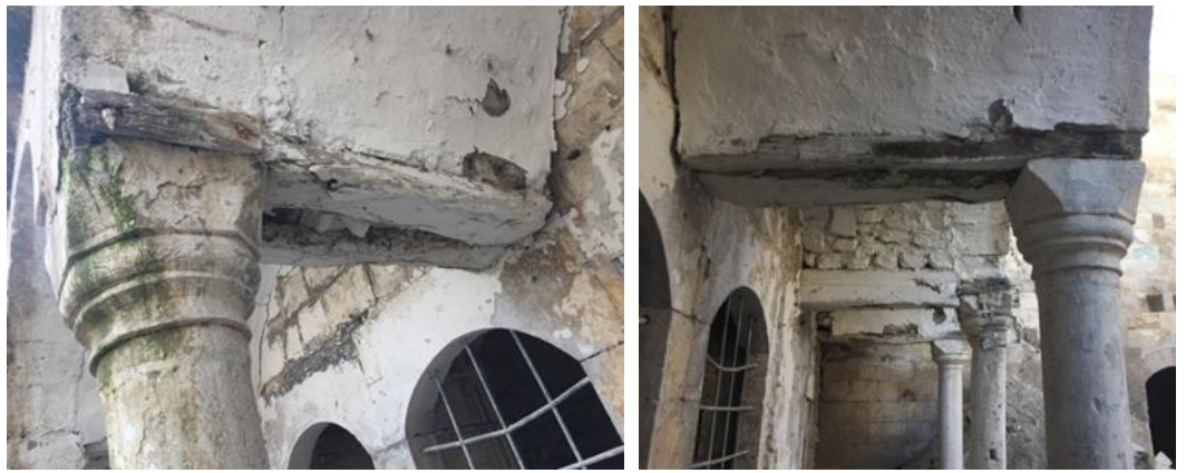
Şekil 4.31. Ahşap malzemenin revakta hatıl olarak kullanılması
