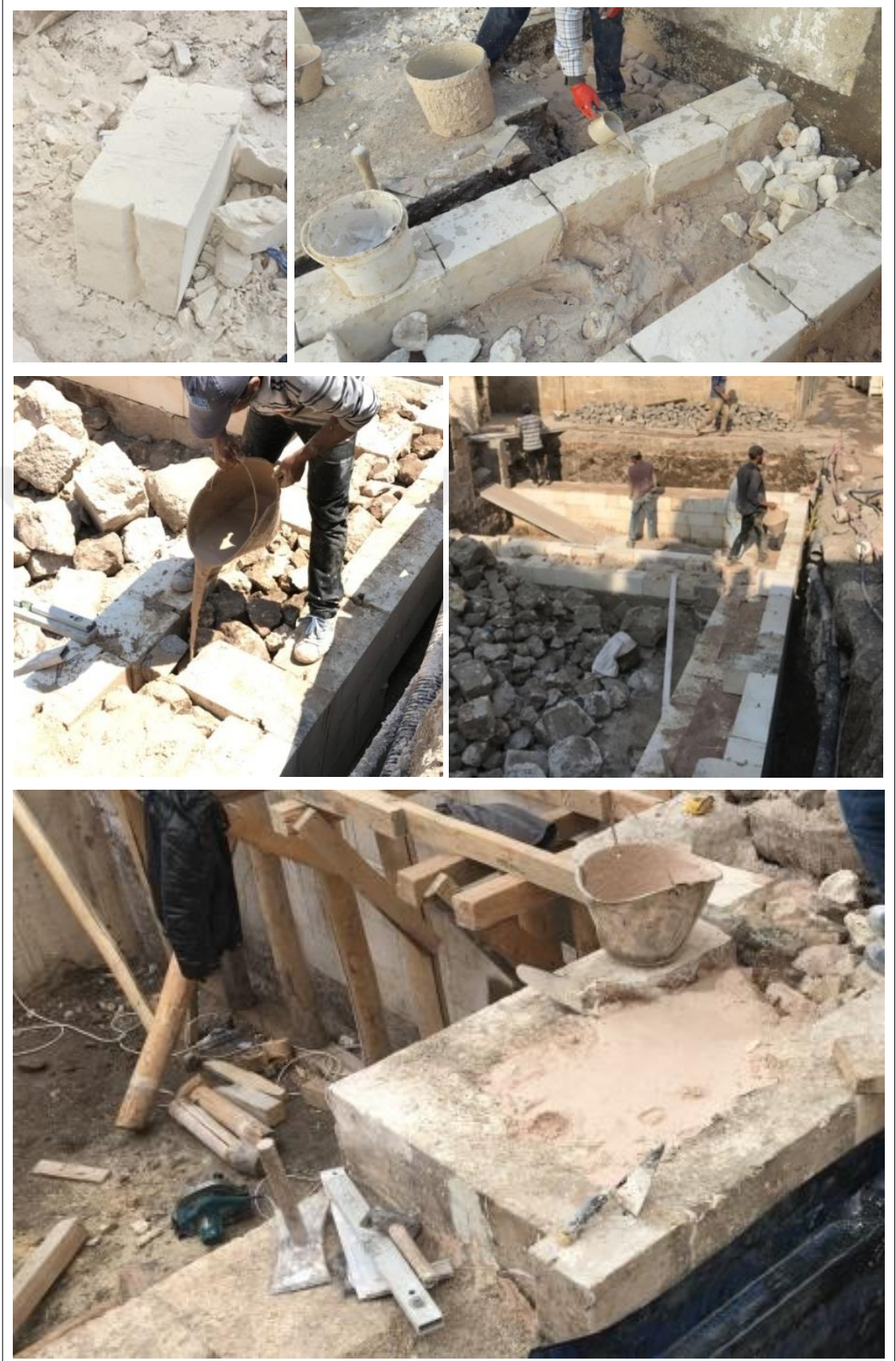
Şekil 5.7. Çift sıra duvar yapım aşamaları
