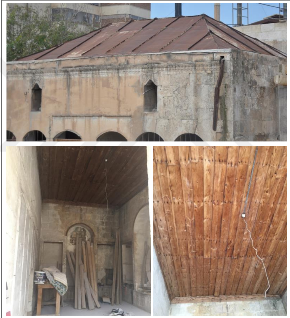
Şekil 5.82. Çinko levha/sac kaplanmış kırma çatı
