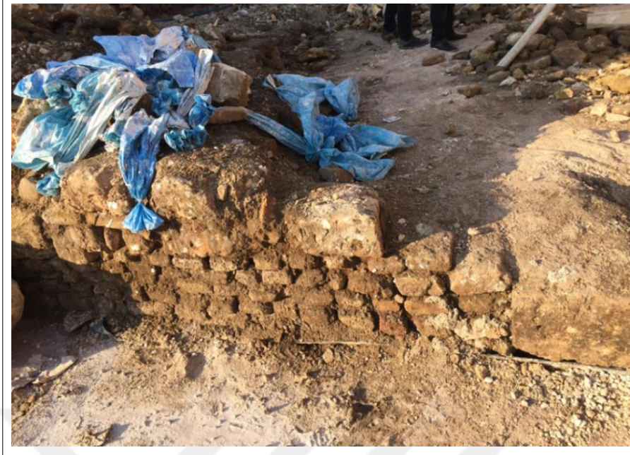
Şekil 5.4. Temel duvarı kalıntısı
