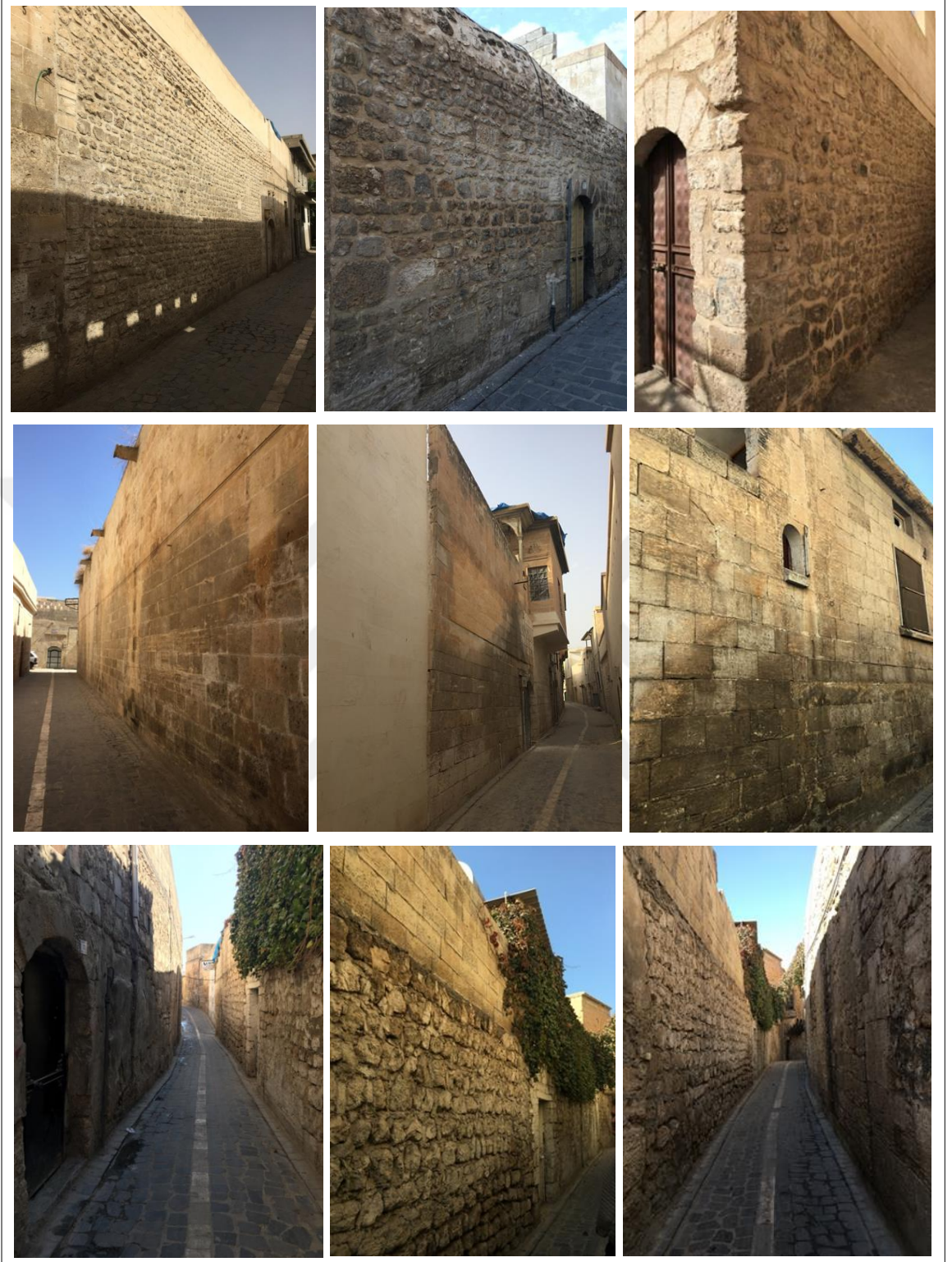
Şekil 5.15. Geleneksel Urfa evlerinde sokak duvarları
