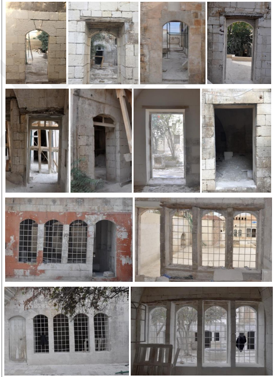
Şekil 5.19. Duvarlardaki ahşap lentolarla geçilen kapı ve pencere açıklıkları
