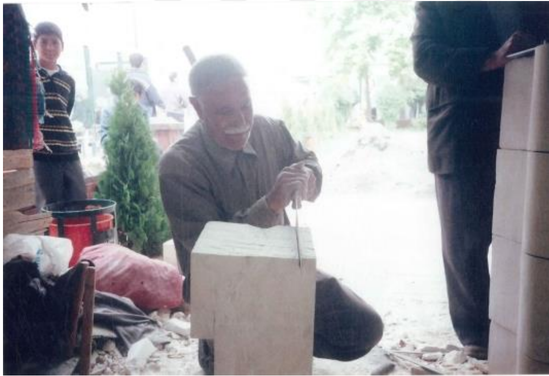
Şekil 4.13. Taş ustası Mustafa Hakkı Küçüköğlu'nun taşta testere ve tarak ile şekil vermesi (Mustafa Hakkı Küçüköğlu kişisel arşivi 1970'ler)
