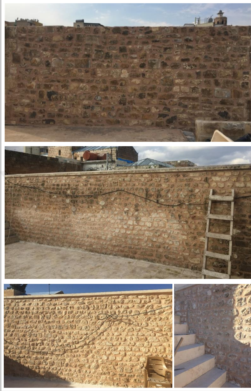
Şekil 5.11. Avluda kullanılan moloz taş duvarlar
