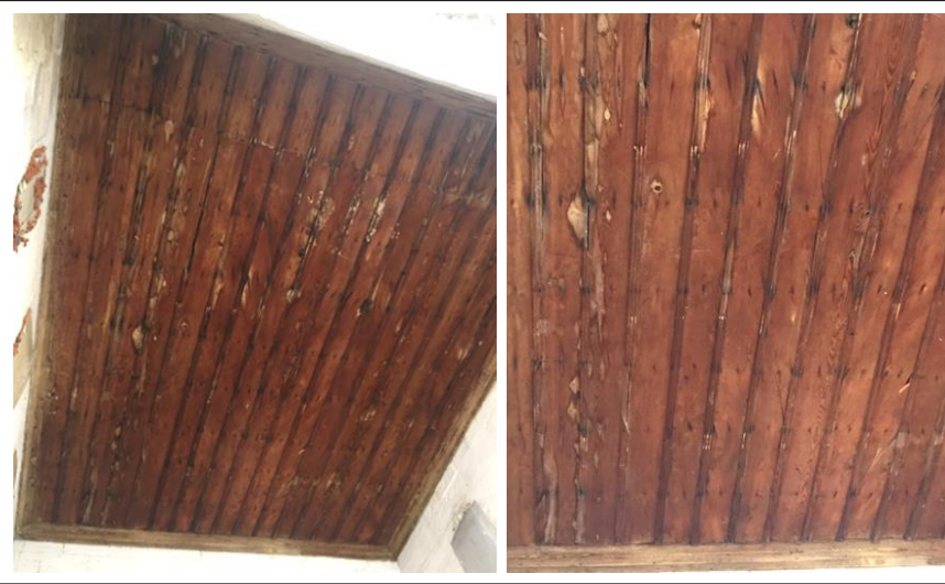
Şekil 5.71. Yalın çıtalarla süslenmiş düz ahşap kaplama tavan
