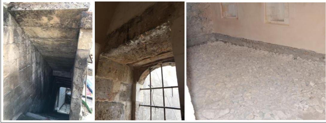
Şekil 4.10. Taşın taşıyıcı ve agrega olarak kullanımı
