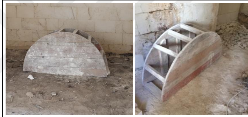
Şekil 5.29. Kemer kalıpları
