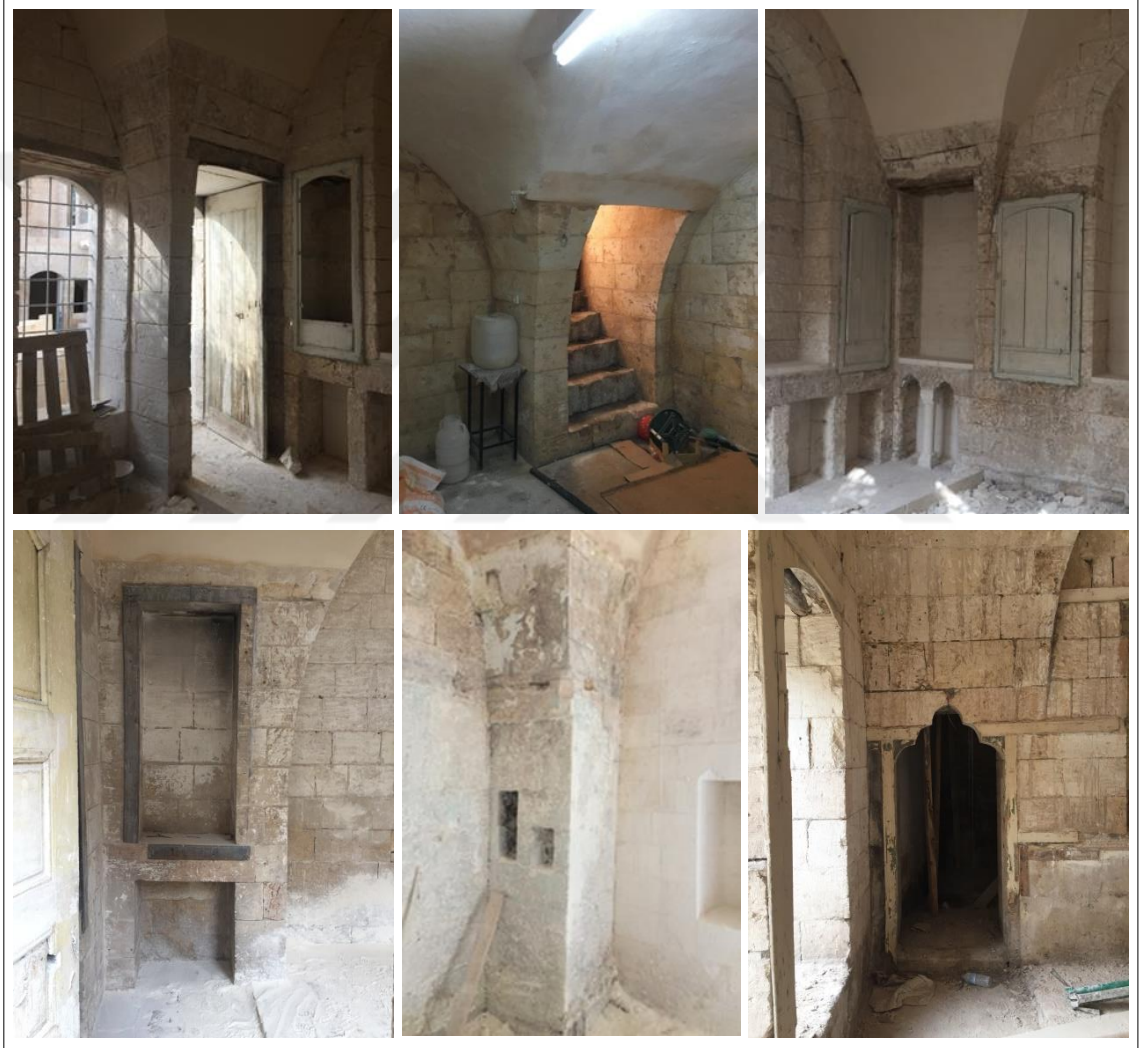
Şekil 5.64. Çapraz tonozlarda tonoz ayağının kullanım şekilleri
