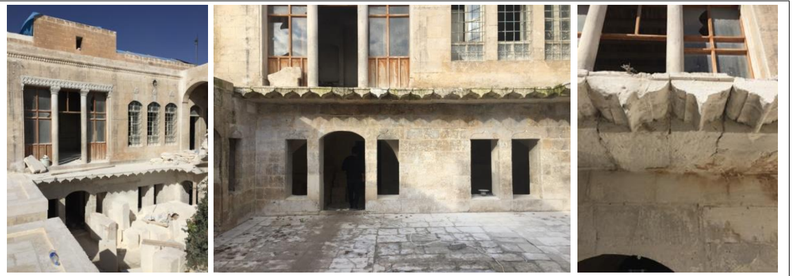
Şekil 5.85. Geleneksel Urfa evinde bir gezenek örneği
