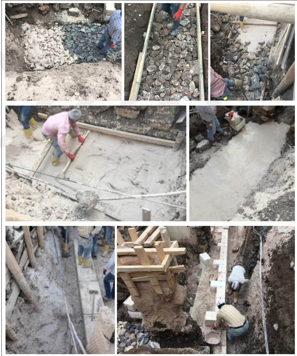
Şekil 5.2. Temel yapım aşamaları (Blokaj sistemi)
