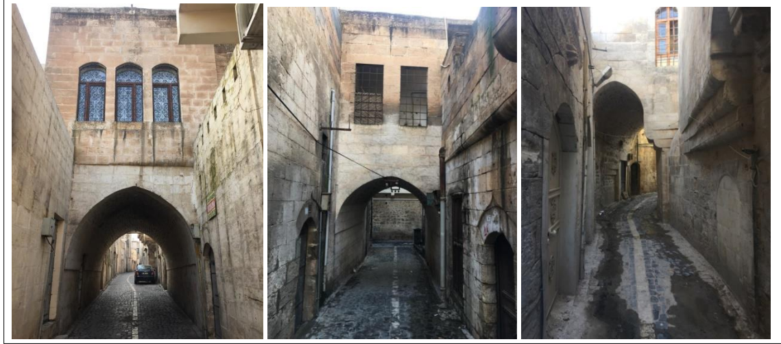
Şekil 5.60. Sokaklarda bulunan kabaltılarda kullanılan tonozlar
