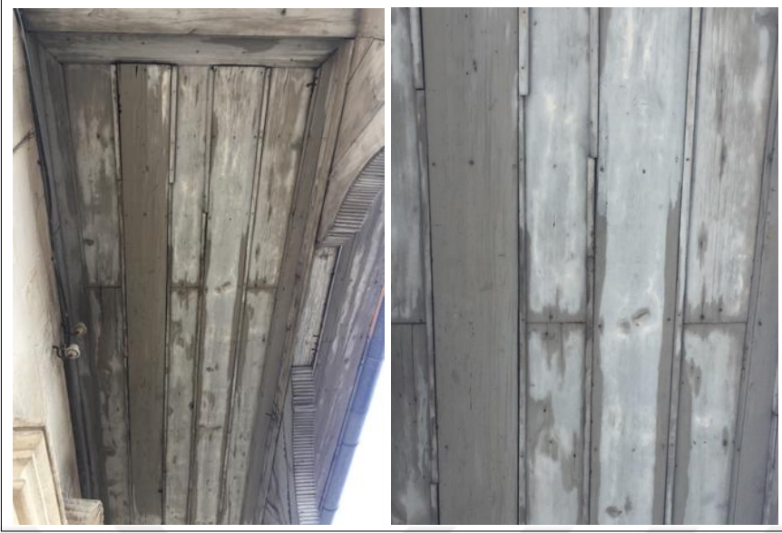
Şekil 5.70. Pasalarla yapılan düz ahşap kaplama tavan
