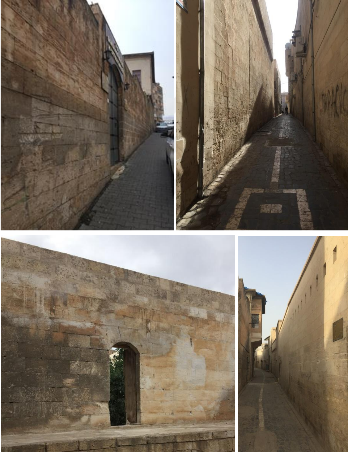
Şekil 5.13. İnce yonu taş duvarlar
