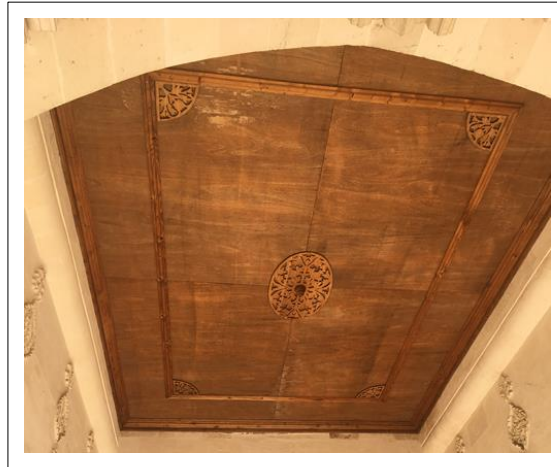
Şekil 5.68. Ahşap kaplama tavanlar
