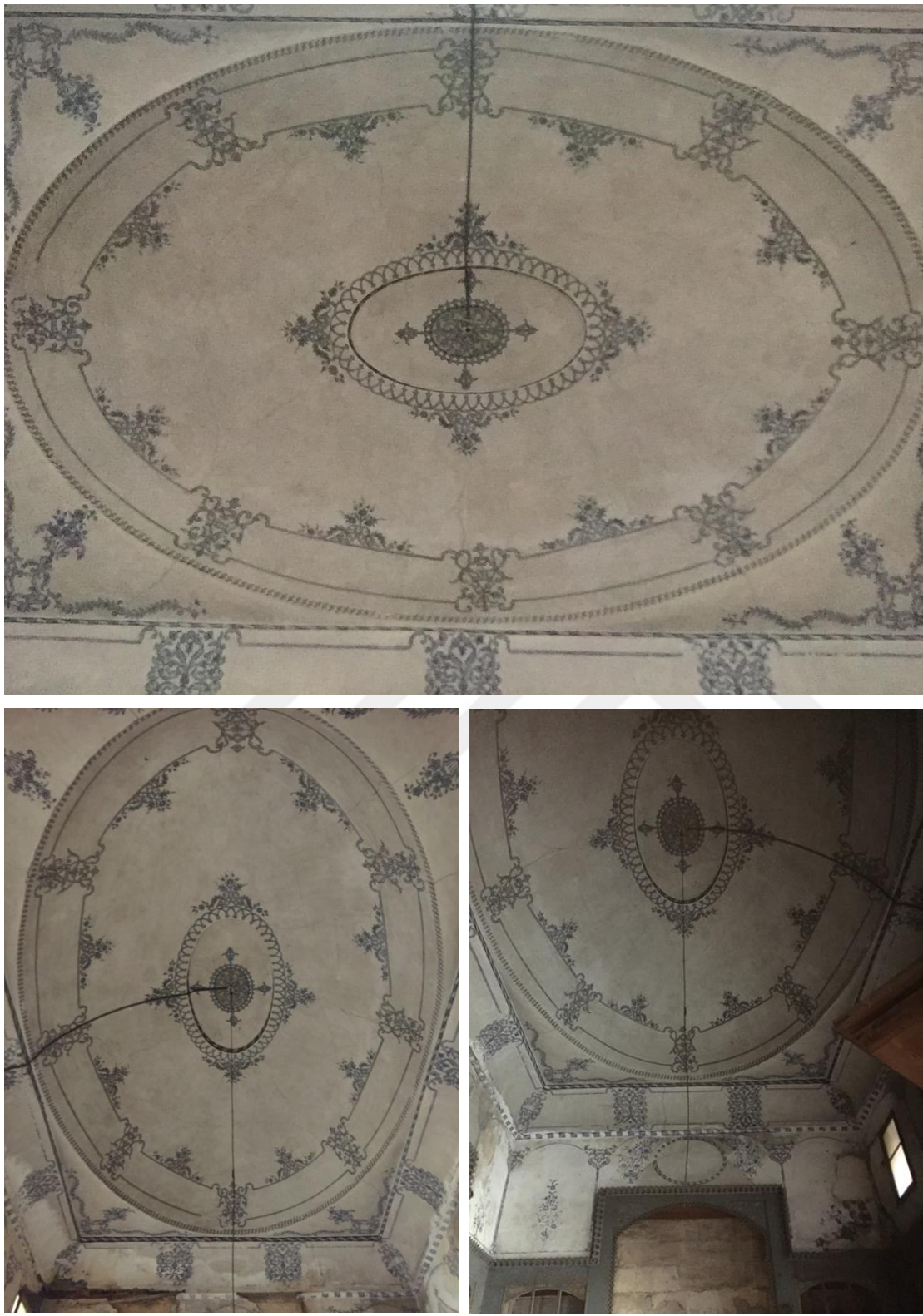
Şekil 5.75. Bağdadi tekniğinde yapılan tekne tavan
