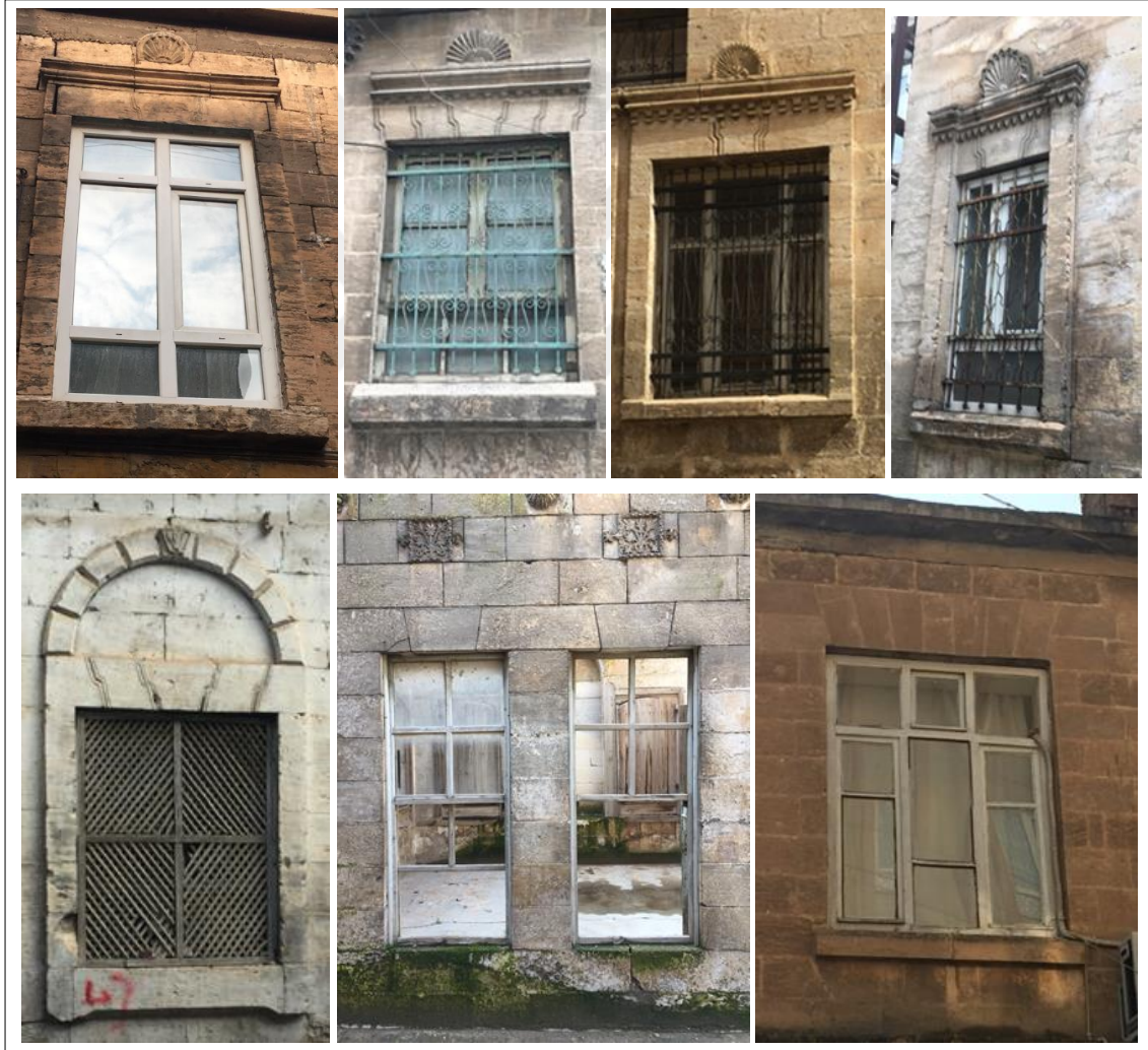
Şekil 5.25. Düz kemerli pencereler
