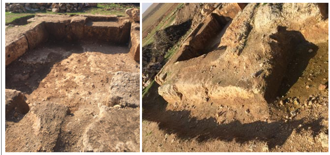
Şekil 5.1. Toprak kazıldıktan sonra zeminde ortaya çıkan kaya yapısı
