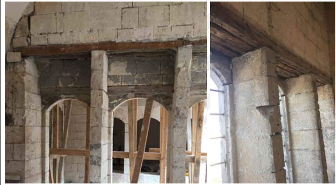
Şekil 4.27. Ahşap malzemenin pencere üzerinde hatıl olarak kullanılması
