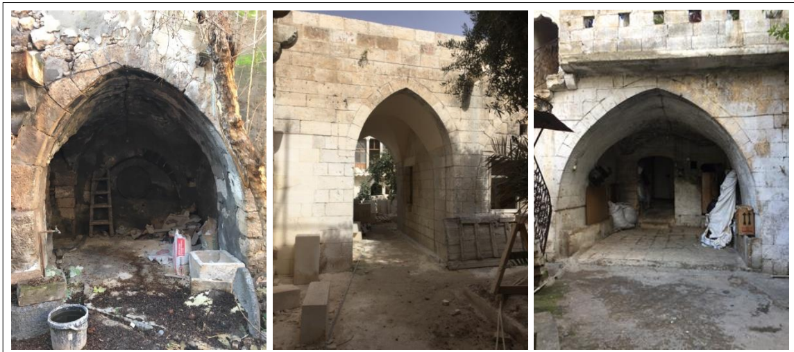
Şekil 5.46. Kapı arasında kullanılan sivri kemerler
