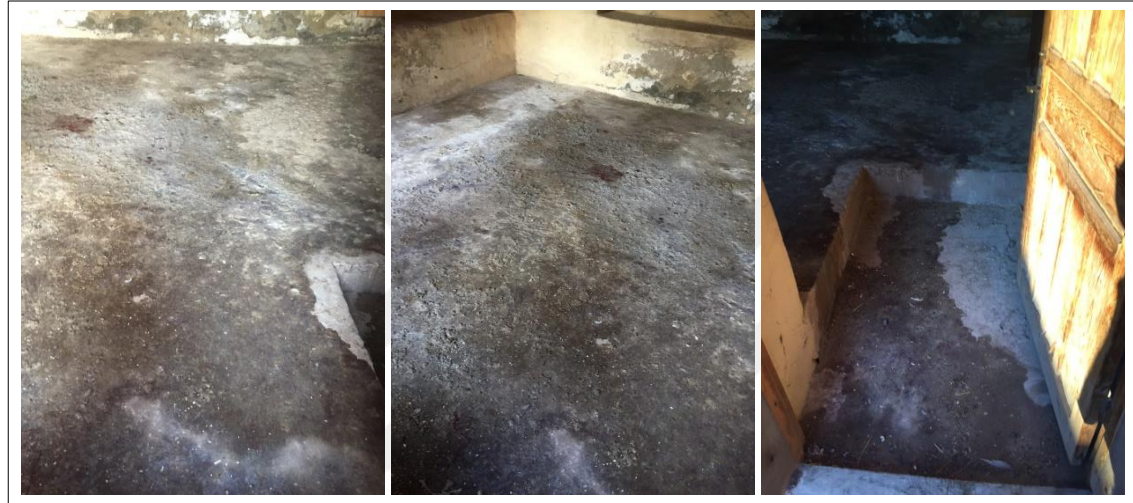
Şekil 5.56. Şap malzemesi ile yapılan oda döşemesi
