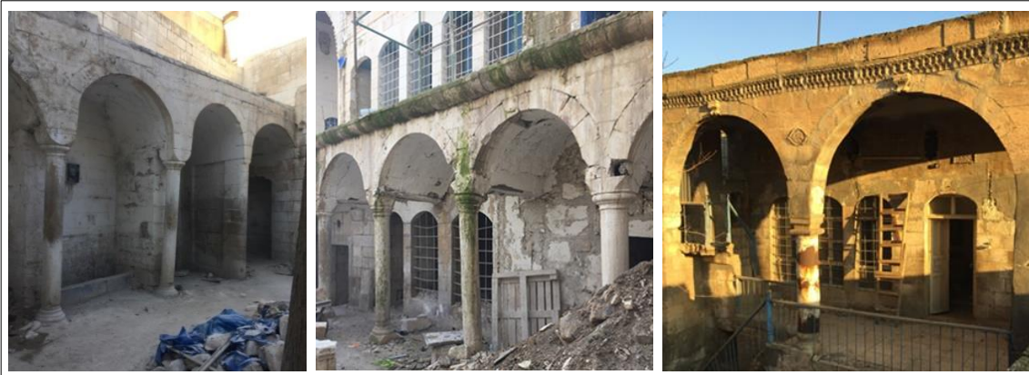
Şekil 5.48. Revaklarda kullanılan kemerler
