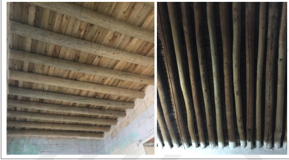
Şekil 5.67. Ahşap kirişli tavanlar
