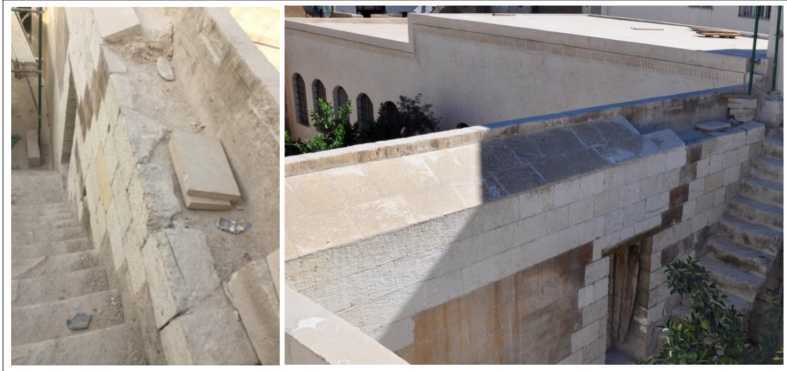
Şekil 5.6. Eski çift sıra bir duvarın üstten görünüşü
