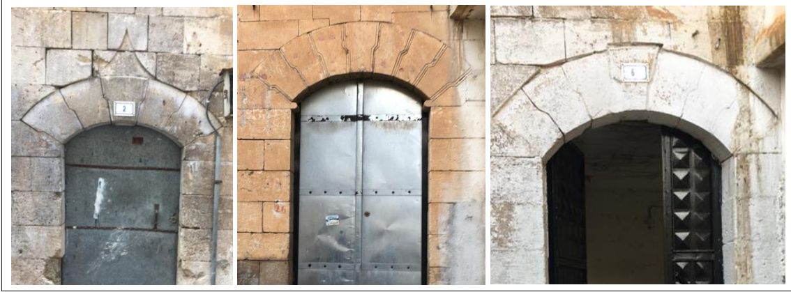
Şekil 5.44. Avlu kapılarında kullanılan “Zengilli kemerler”
