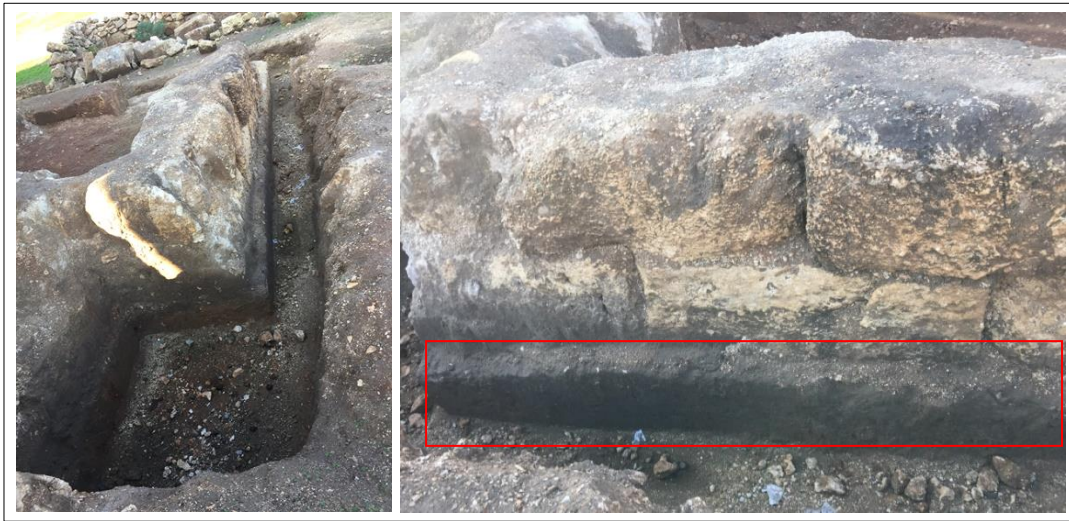
Şekil 5.3. Temelde kullanılan büyük boyutlu taşlar
