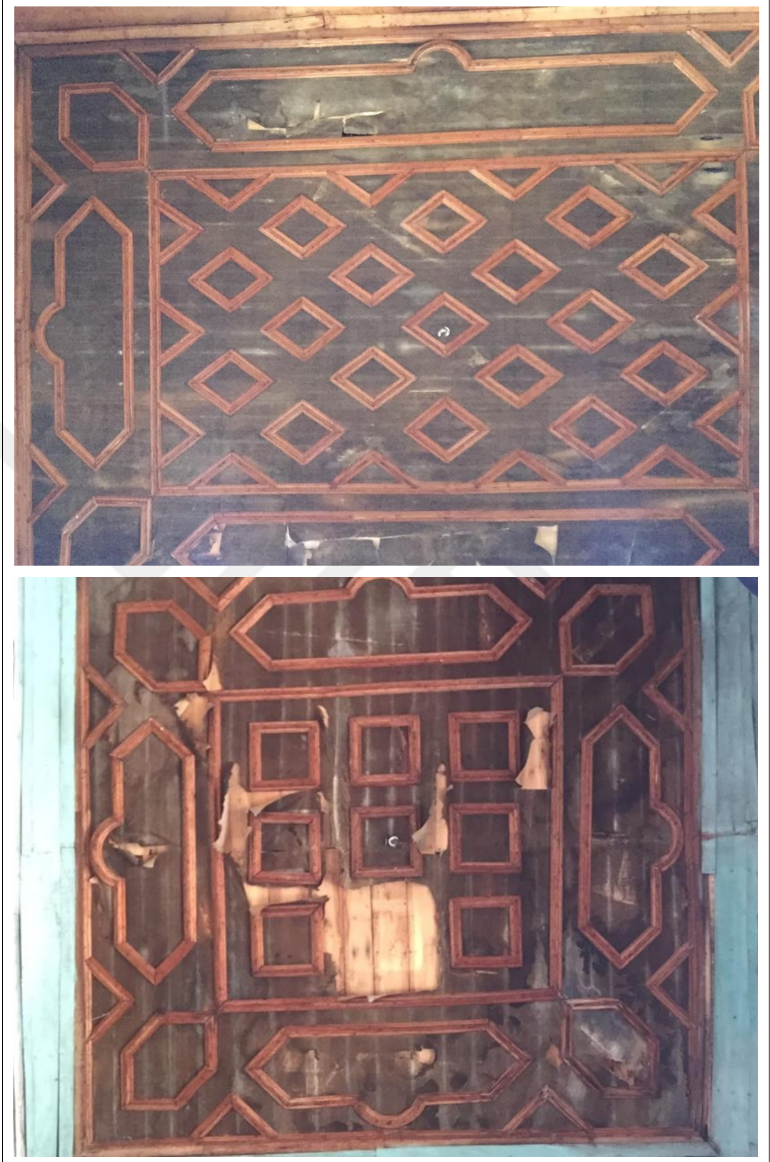
Şekil 5.72. Düz ahşap kaplama tavanların üzerinin kumaş gerilerek kaplandığı, üzerine çıtalarla çeşitli geometrik şekillerde süslemelerin yapıldığı tavanlar
