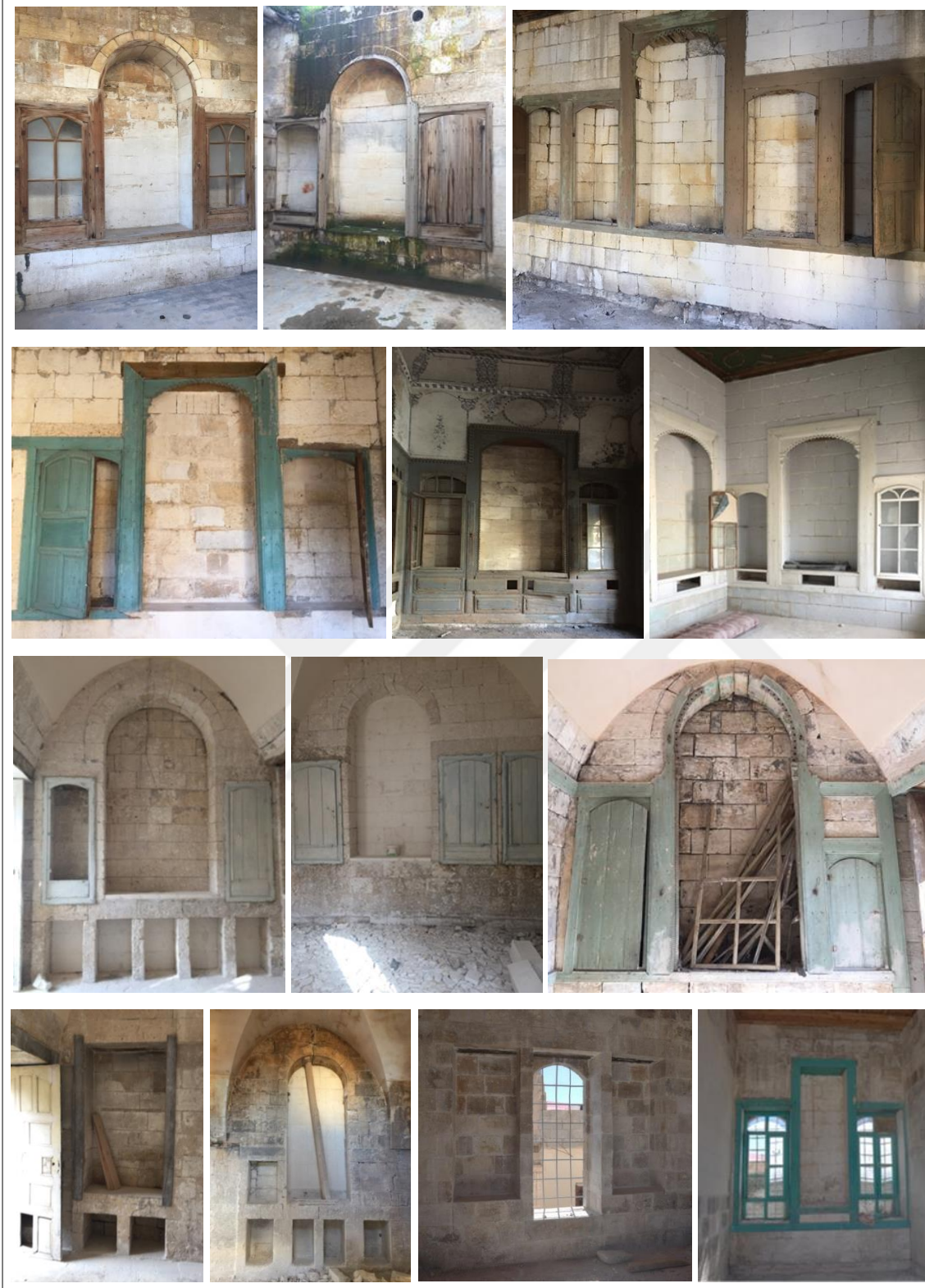
Şekil 5.17. Duvarlarda eşya koymak için yapılan camhaneler
