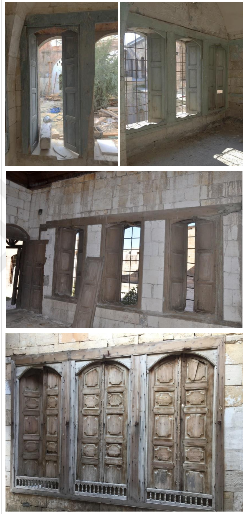
Şekil 4.20. Ahşap pencere kepenkleri
