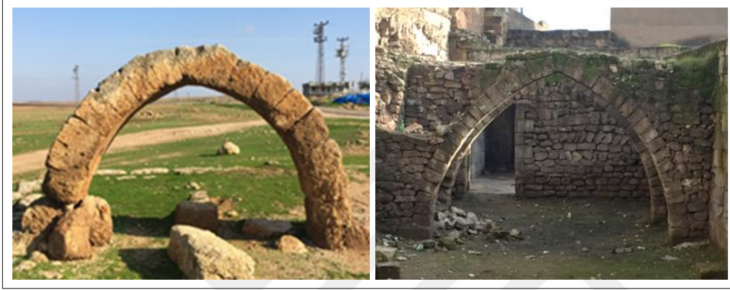
Şekil 5.26. Geleneksel yapım tekniklerinde kemer örnekleri
