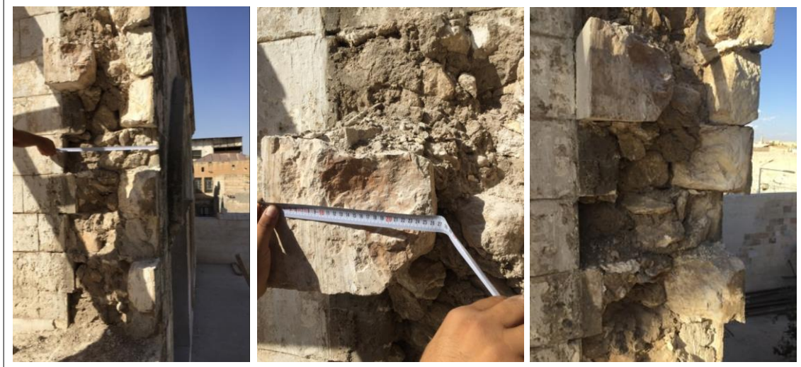
Şekil 5.8. Geleneksel Urfa evinde yapılan çift sıra bir duvar örneği
