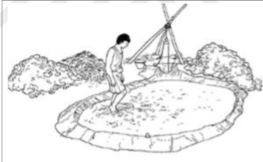
Şekil 4.48. Çamur harç için çamur ve saman karışımının ayak ile karıştırılıp hazırlanması (Adam 1980)
