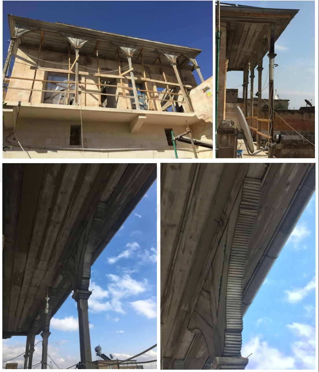
Şekil 4.25. Gezeneğin üzerini örten çatı uzantısı ve ahşap sütunlar (Ahşap süslemeli saçak kullanımı)
