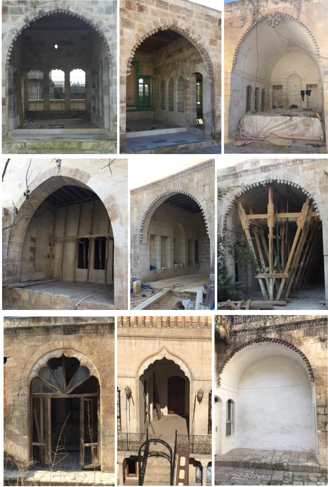
Şekil 5.40. Eyvanlarda kullanılan kemerler
