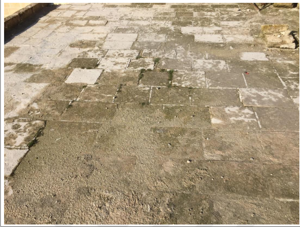
Şekil 5.78. Taş dam döşemesi
