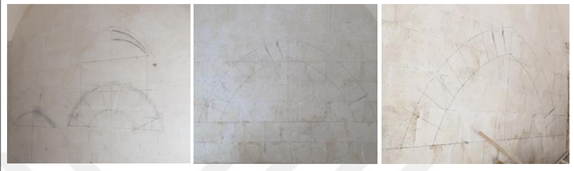
Şekil 5.28. Kemer kalıp çizimi (kemer şablonu)
