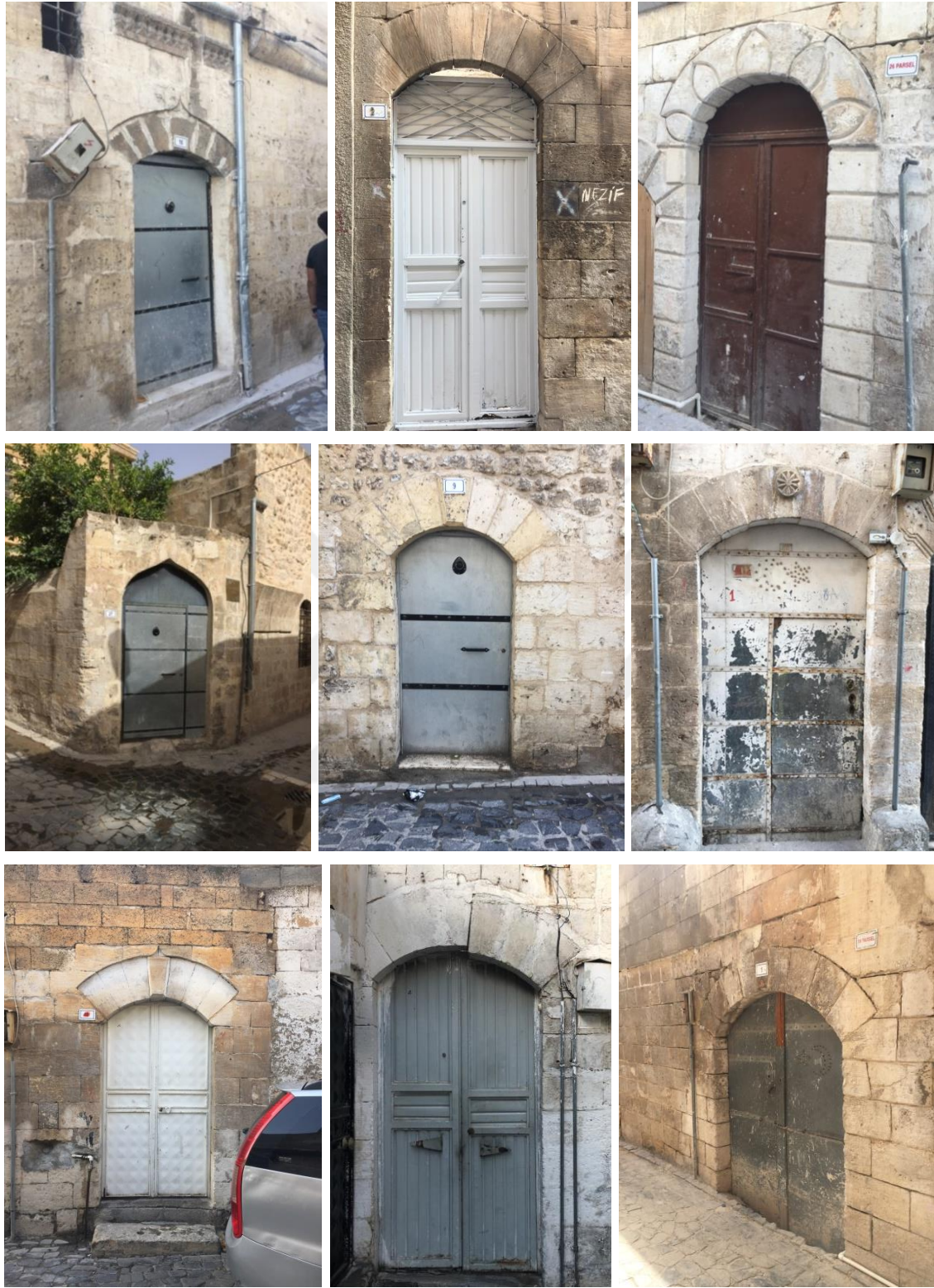
Şekil 5.43. Avlu kapılarında kullanılan kemerler
