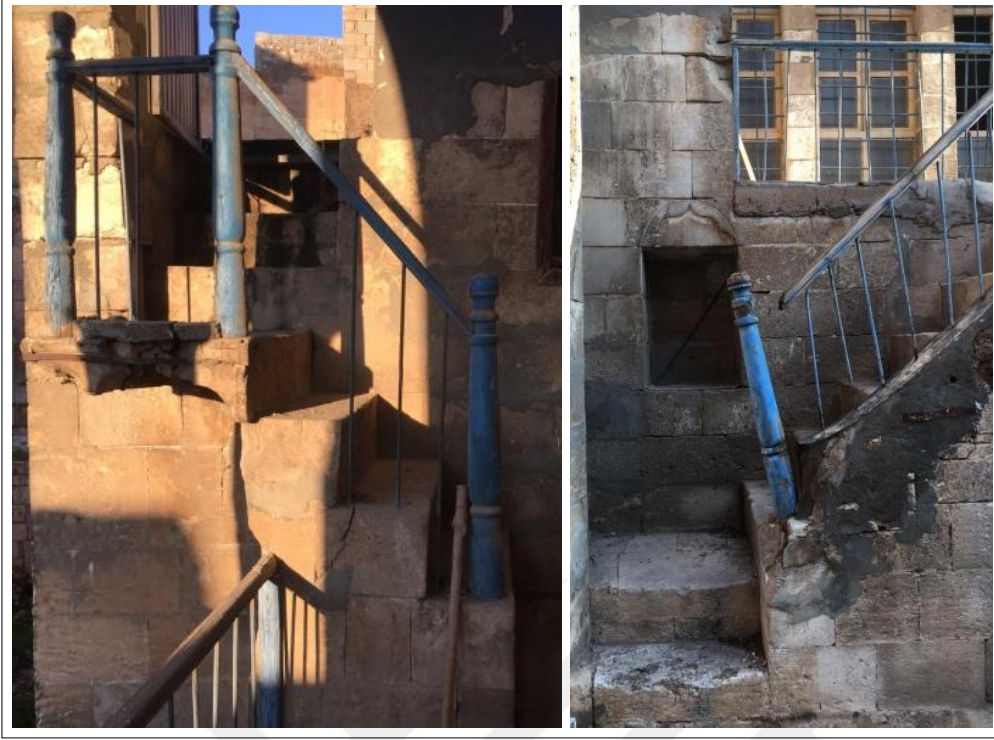
Şekil 4.23. Merdiven kenarlarında kullanılan ahşap korkuluklar
