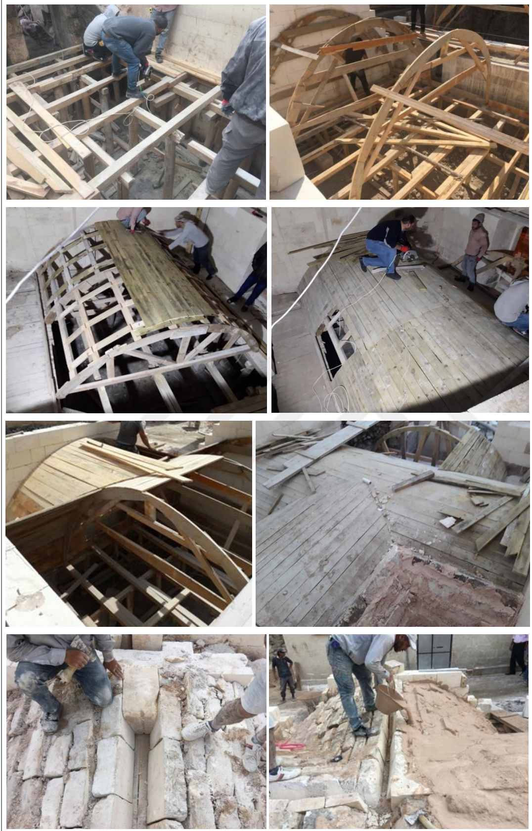
Şekil 5.62. Tonoz yapım aşamaları
