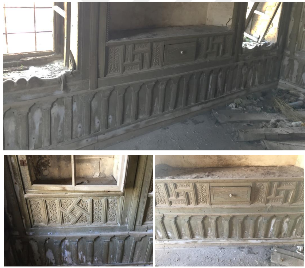
Şekil 4.24. Başoda duvarında kullanılan ahşap duvar kaplaması
