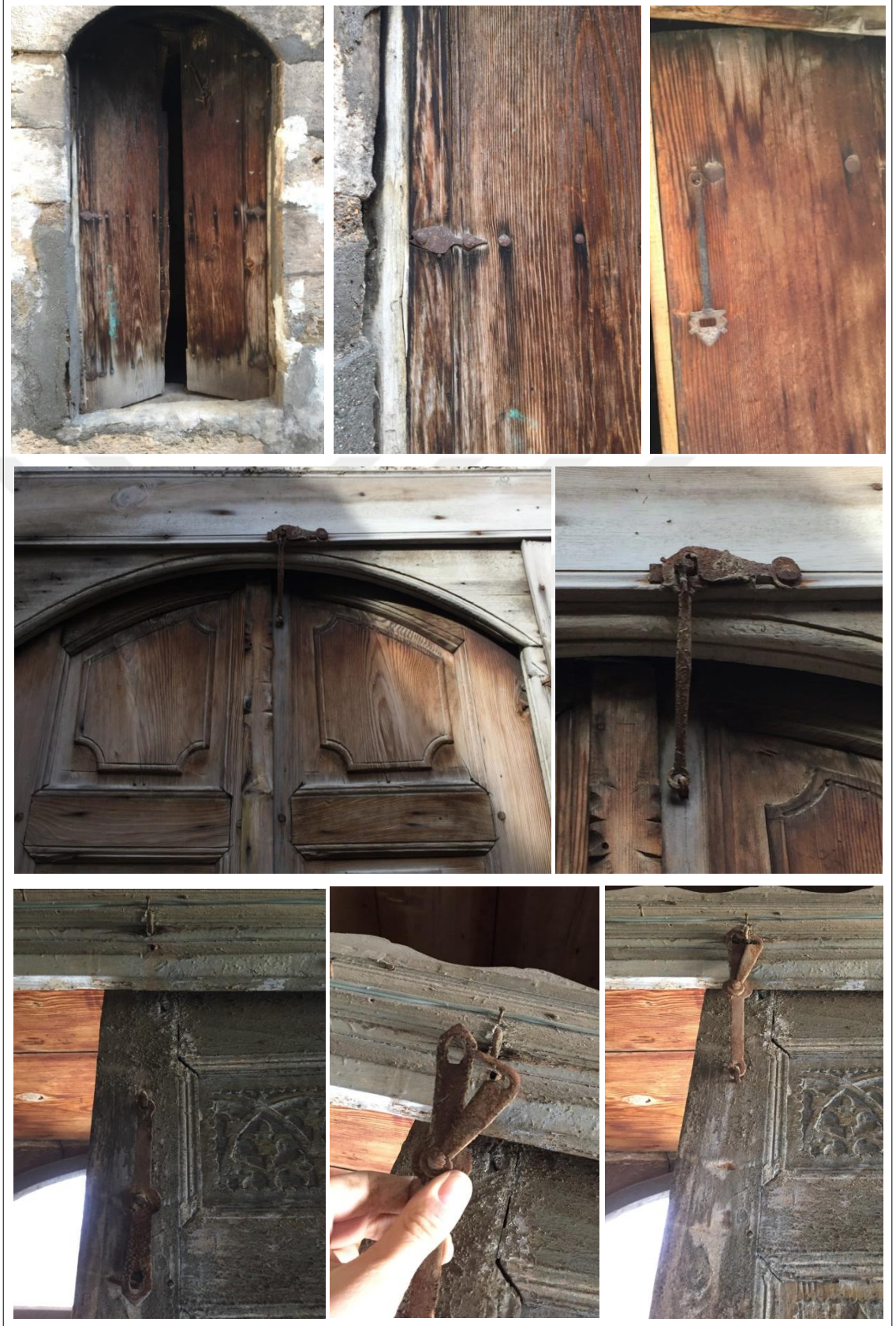
Şekil 4.42. Metalin pencere kepenklerinde kullanılması
