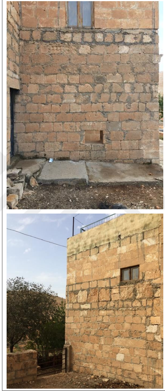
Şekil 5.12. Kaba yonu taş duvarlar
