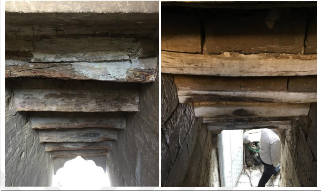
Şekil 4.29. Ahşap malzemenin merdiven üzerinde hatıl olarak kullanılması
