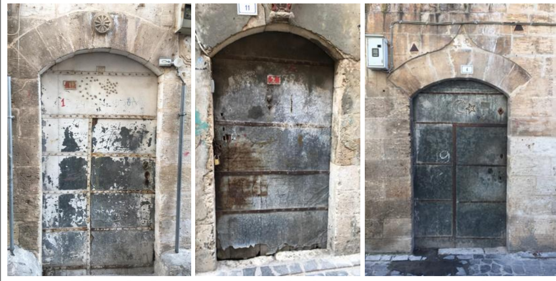
Şekil 4.46. Sac kaplanmış avlu kapıları
