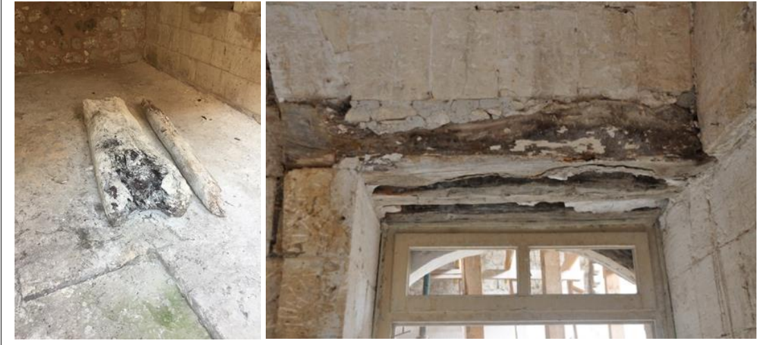
Şekil 4.26. Ahşap malzemenin kapı üzerinde hatıl olarak kullanılması
