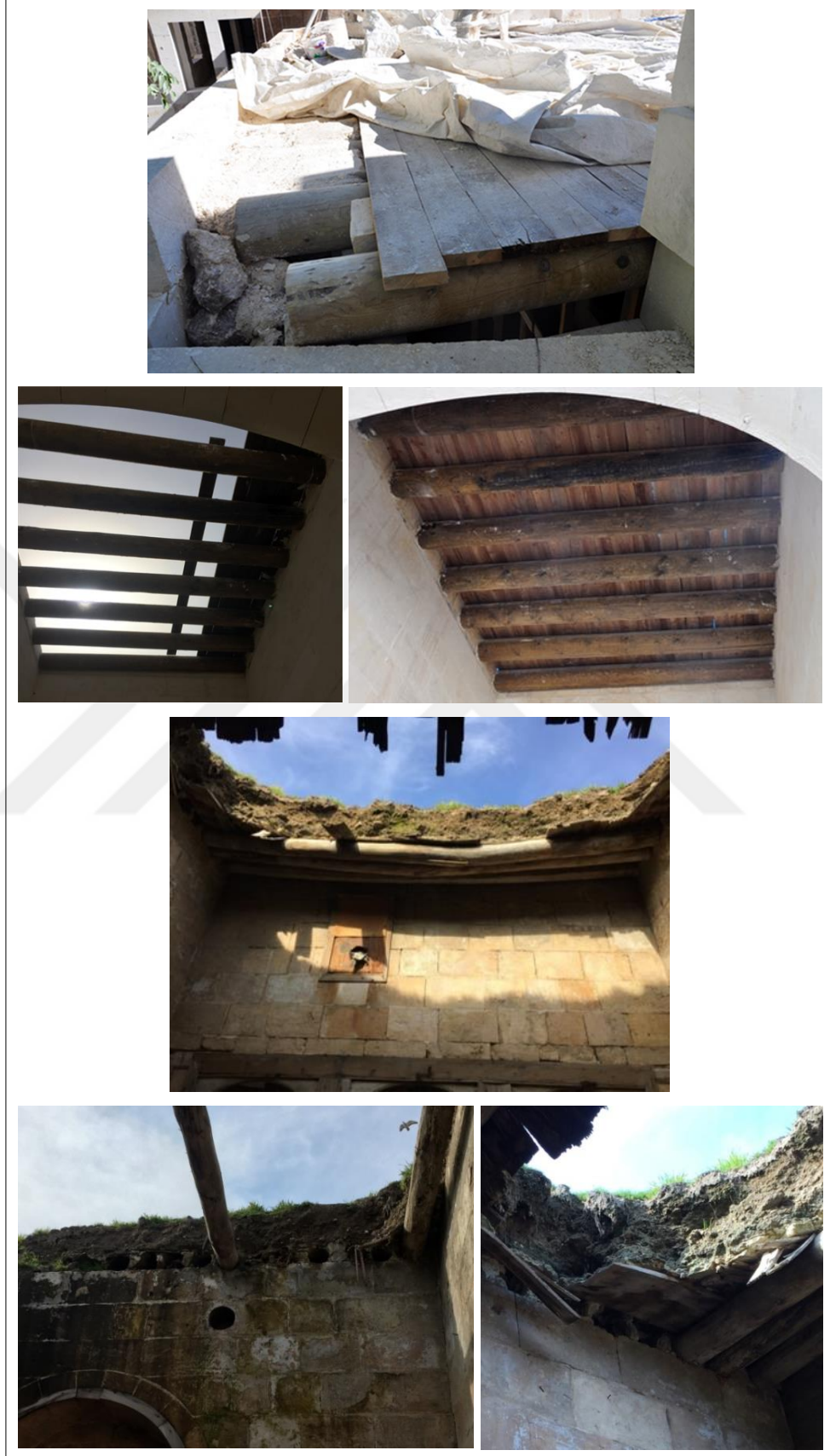
Şekil 5.81. Toprak damların altında kullanılan ahşap kirişli tavanlar
