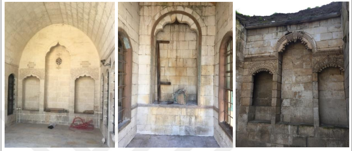
Şekil 5.49. Nişlerde kullanılan kemerler
