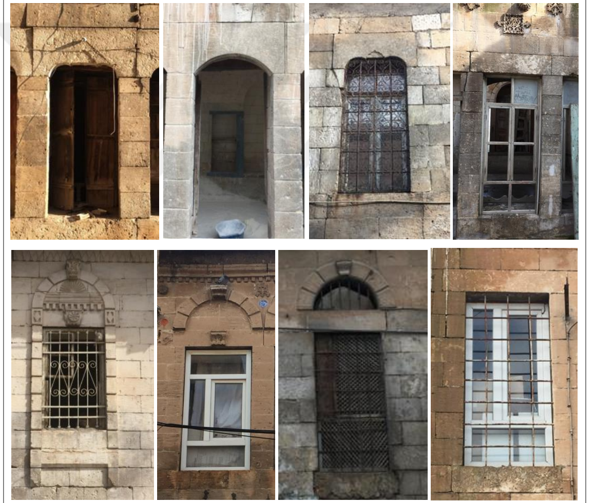
Şekil 5.23. Tek taş lentolu pencereler
