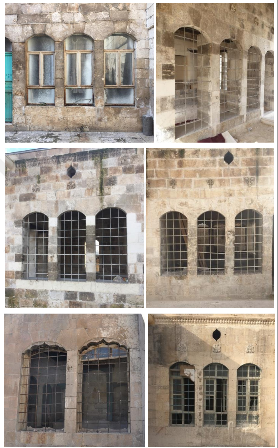
Şekil 5.41. Pencereelerde kullanılan kemerler
