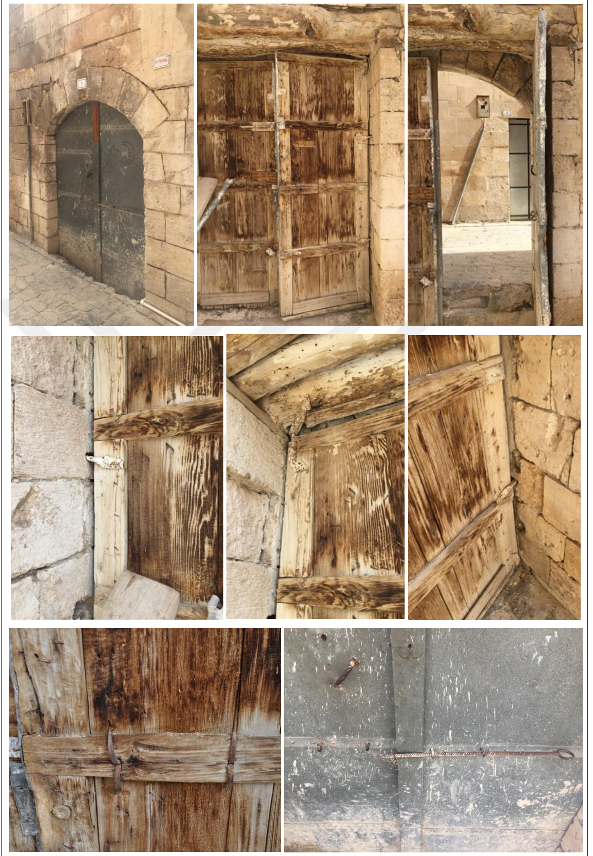
Şekil 5.97. Geleneksel Urfa evindeki bir avlu kapısı detayı
