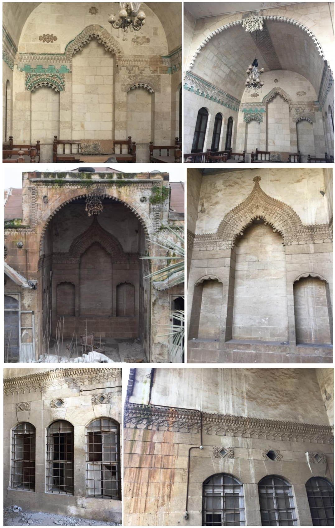
Şekil 5.113. Eyvanda üzengi hizasında duvarları çepeçevre dolaşan mukarnaslı korniş süslemesi (eyvanın içindeki nişlerin üzerini ve eyvanın kenarlarını çepeçevre dolaşan korniş)
