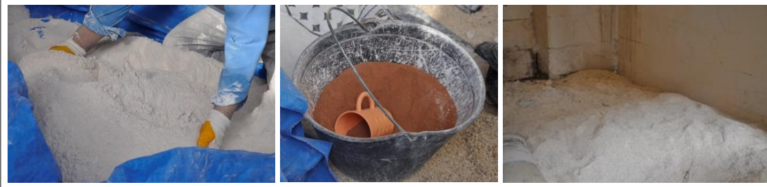
Şekil 6.10. Derz yapımında kullanılan hidrolik kireç, kiremit tozu ve kum
