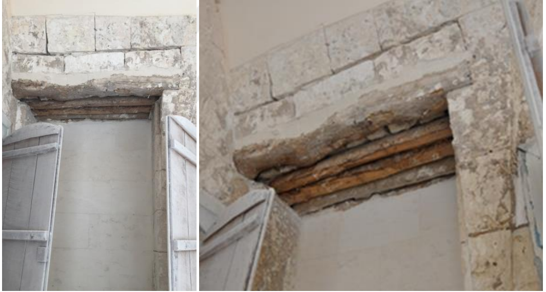
Şekil 4.30. Ahşap malzemenin nişlerde hatıl olarak kullanılması
