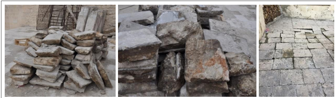
Şekil 5.50. Eski bir avlu döşemesi ve döşemeden sökülmüş taşlar
