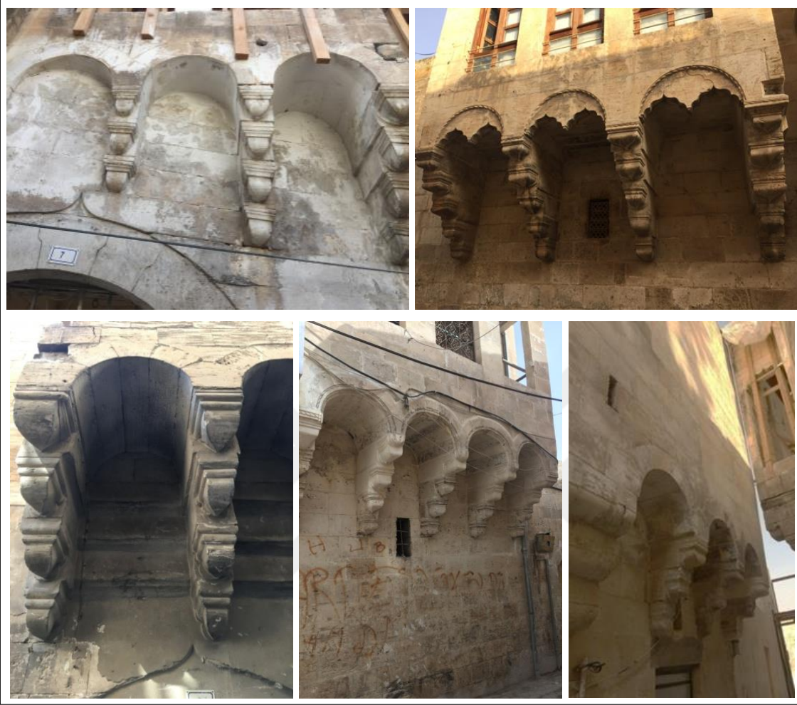
Şekil 5.47. Konsollarda kullanılan kemerler
