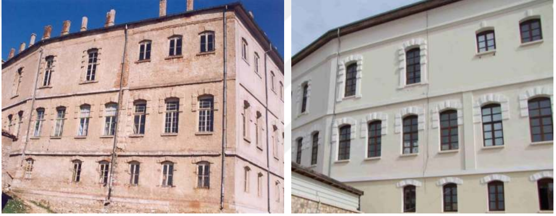
Şekil 4.112 Çatıdaki bacaların değişimi
