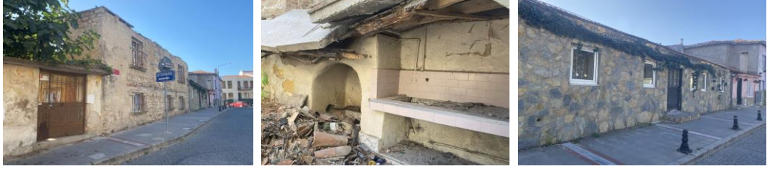
Şekil 4.165 Özgünlüğünü kaybetmiş geleneksel yapı örnekleri
