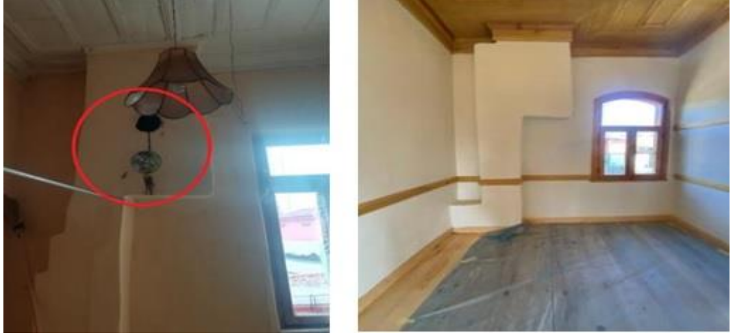
Şekil 4.10 Yapıya sonradan eklenen bacaların mevcut durumu
