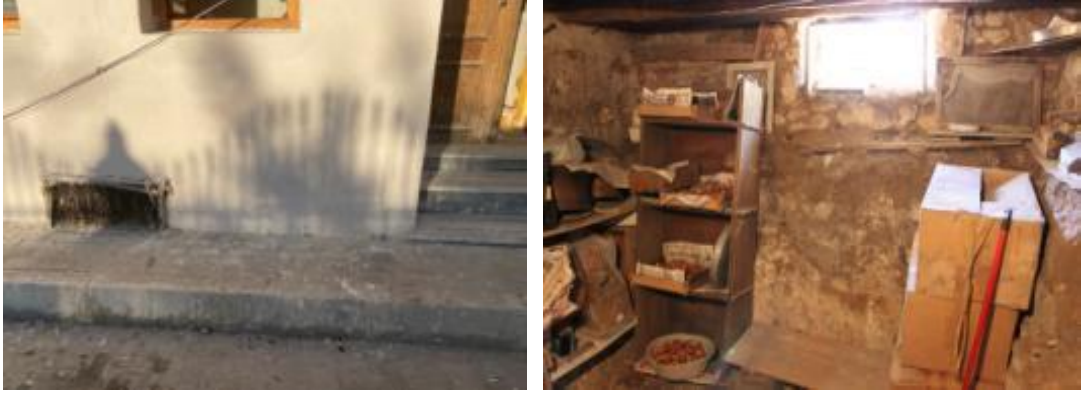
Şekil 4.17 Bodrum katın sokağa bakan penceresi
