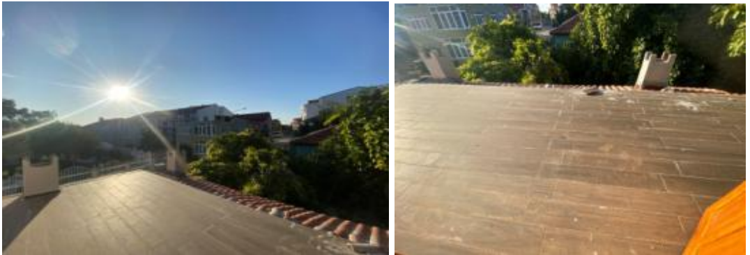
Şekil 4.19 Terasın modern malzemelerle yenilenmiş hali
