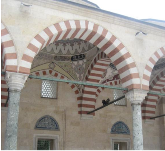
Resim 4.13. Edirne Üç Şerefeli Camii gergi düzenlemesi, 2011 [44]
