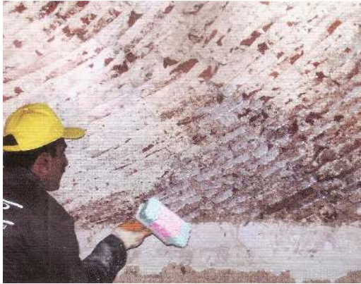
Resim 4.20. İstanbul Hazine-i Evrak binası yapısal çatlakların karbon fiber ile onarılması [10]
