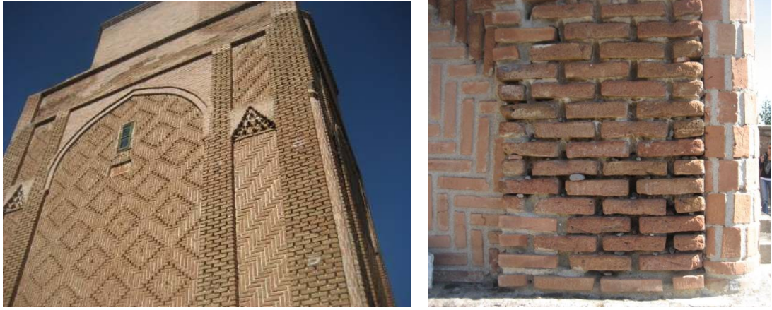
Resim 2.11. Kayseri Melikgazi Türbesi derz boşalması örnekleri, 2011 [44]
