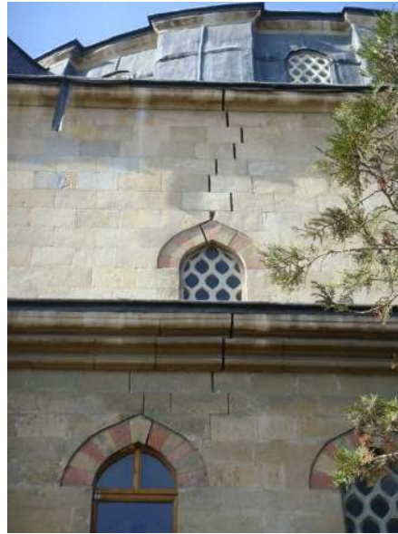
Resim 2.1. C.A.P.C. oturmadan kaynaklı çatlağın içeriden ve dışarıdan görünüşü, 2008 [5]
