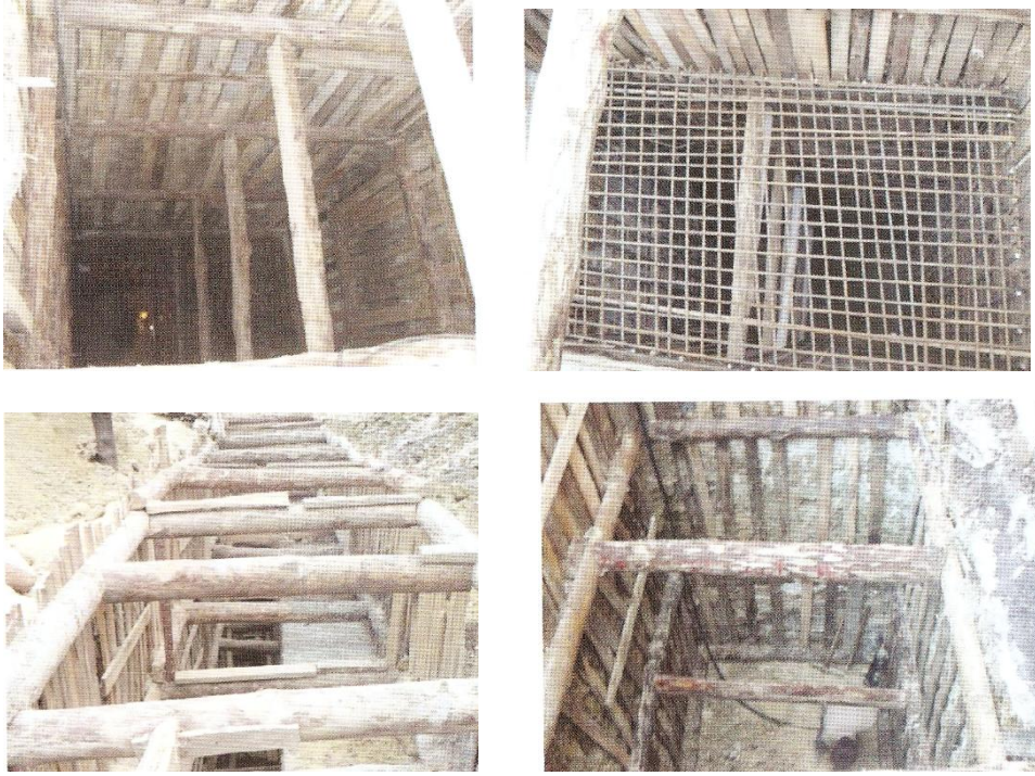
Resim 4.43. Edirnekapı Mihrimah Sultan Camii kuyu temel uygulaması [33]
