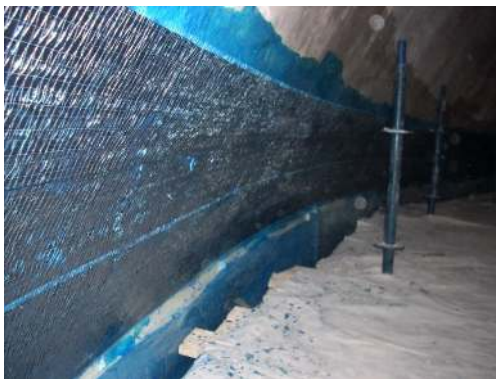
Resim 4.21. İstanbul Yavuz Sultan Selim Camii karbon fiber uygulaması, 2008 [9]
