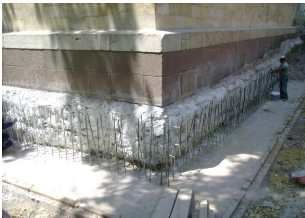
Resim 4.57. Temelde horosan sıva ve likit membran uygulaması, 2010 [5]
