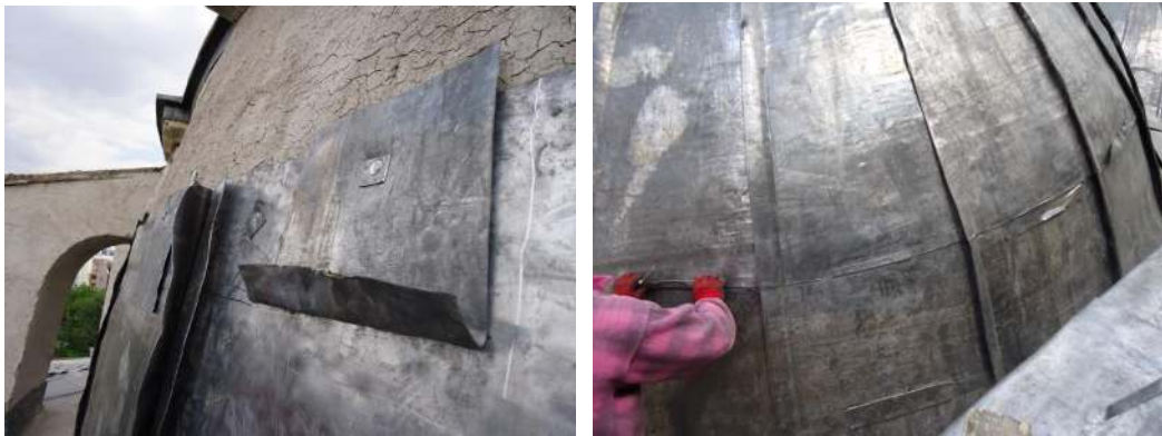
Resim 4.23. Kurşun örtü yapılması, 2011 [5]
