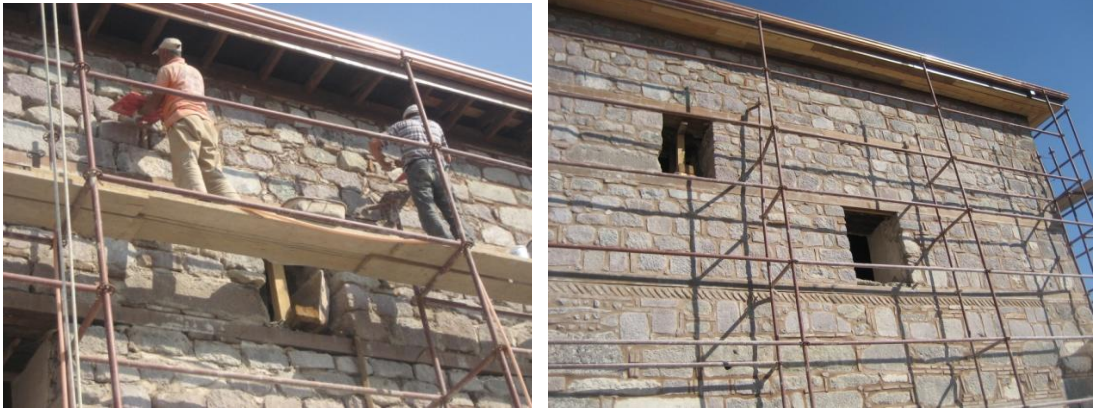
Resim 4.3.b. Ankara Altındağ Arslanhane Camii derz yapılırken, 2011 [5]
