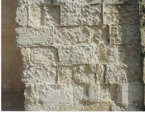
Resim 2.27. Duvar yüzeylerinde bozulma ve ufalanmalar [23]
