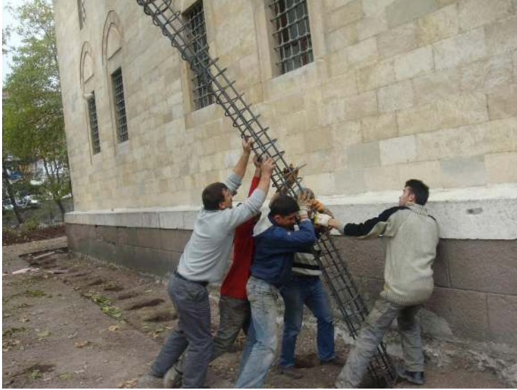
Resim 4.50. Mini kazık donatısının yerleştirilişi, 2009 [5]
