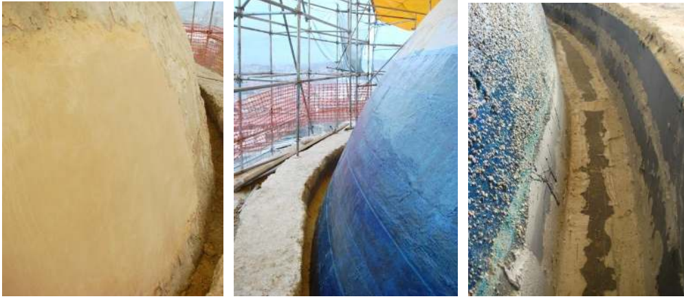
Resim 4.24. Mustafa Paşa Camii kubbede karbon lif uygulaması, 2007 [55]
