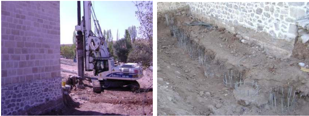
Resim 4.46. Kırıkkale Yeşilyazı Camii fore kazık uygulamaları, 2007 [5]
