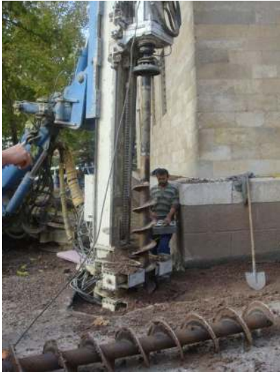
Resim 4.48. Kazı yapılan makine, 2009 [5]
