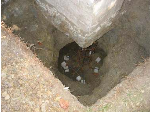
Resim 4.41. Geleneksel yöntemle çukur açılması [68]
