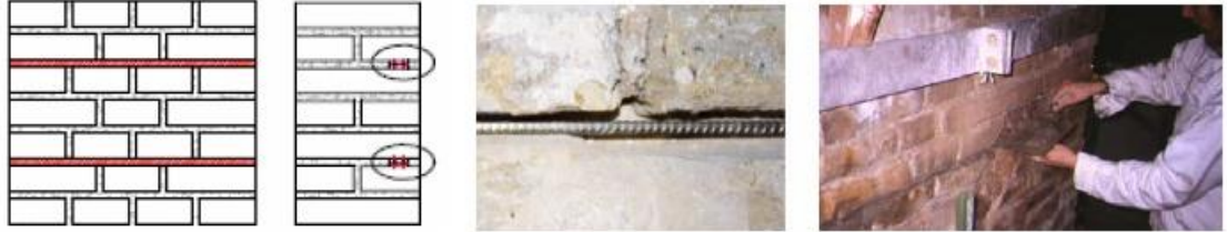
Şekil 4.2. Donatılı derzleme [36]
