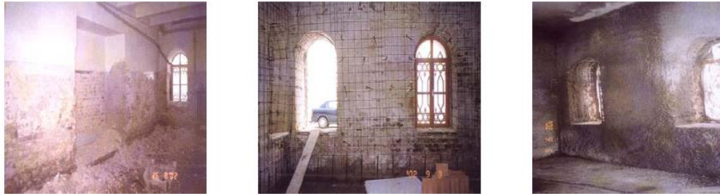
Resim 4.25. İstanbul, Kabataş Erkek Lisesi duvarlara çelik hasır ve ankrajların yerleştirilmesi ve püskürtme betonunun tamamlanması [39]
