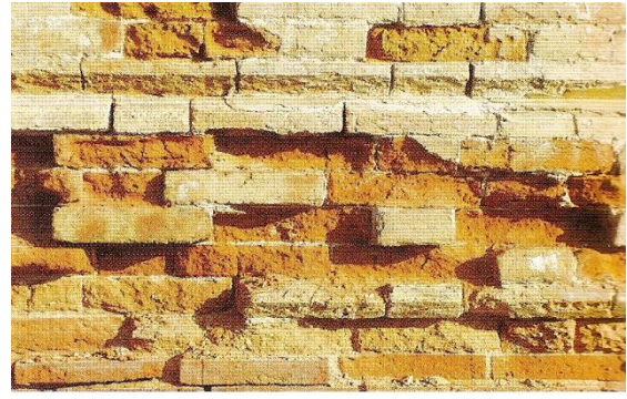
Resim 2.27. Duvar yüzeylerinde bozulma ve ufalanmalar [23]
