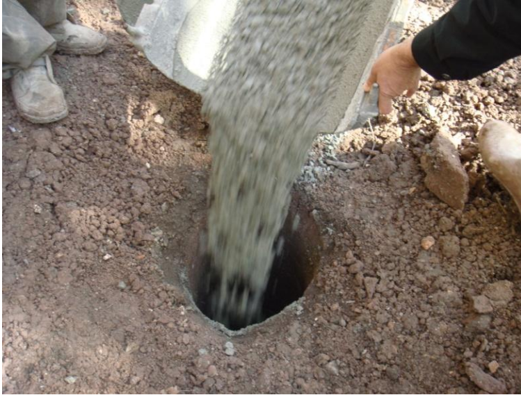
Resim 4.51. Mini kazık beton imalatı, 2009 [5]
