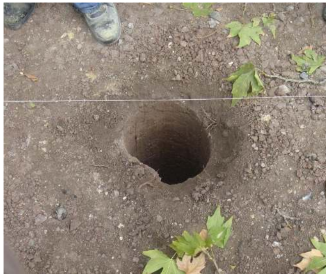
Resim 4.49. Delme işlemi yapılan kazık yeri, 2009 [5]
