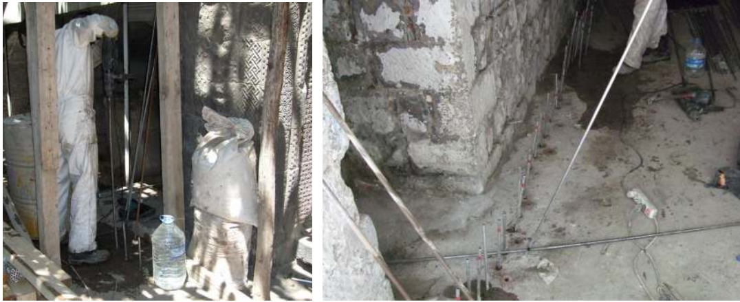
Resim 4.44. Diyarbakır Melik Ahmet Camii kimyasal enjeksiyon işlemi, 2008 [25]
