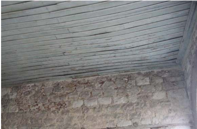
Resim 2.17. Edirne Atik Ali Paşa Camii ahşap tavanının sehim yapması, 2011 [44]
