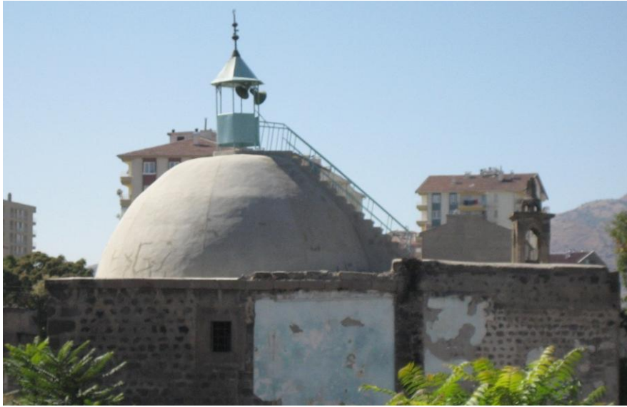
Resim 4.30. Kayseri Gubaroğlu Mescidi beton atılmış kubbe, 2011 [44]
