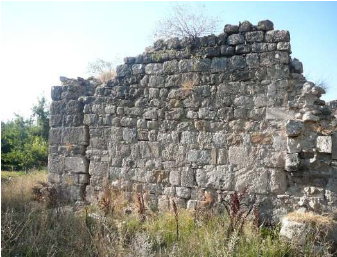
Resim 2.16. Isparta Ertokuş Han duvarlarında ayrılma, 2007 [6]
