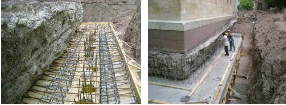
Resim 4.54. Başlık kirişi kalıp ve donatı ve beton imalatı, 2010 [5]
