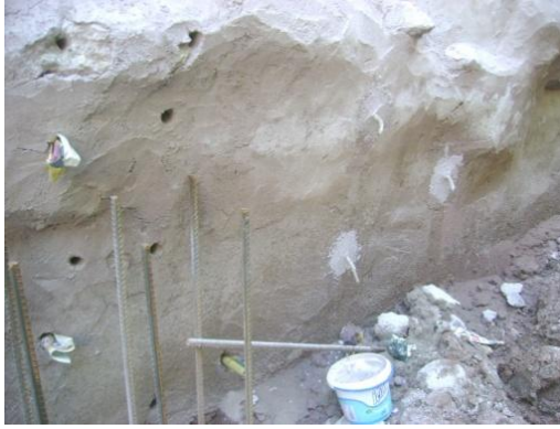
Resim 4.55. Açılan enjeksiyon delikleri ve hortumlar ve enjeksiyonun basıldığı makine, 2010 [5]
