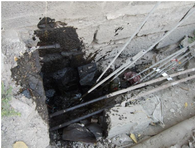
Resim 4.45. Diyarbakır Melik Ahmet Camii kimyasal enjeksiyon işlemi, 2008 [25]
