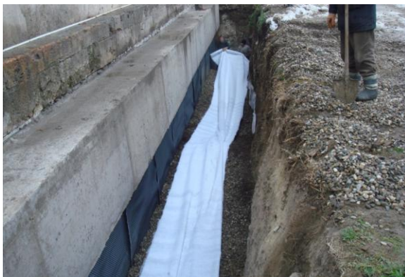
Resim 4.40. Üsküp Mustafa Paşa Camii drenaj çalışması, 2007 [55]
