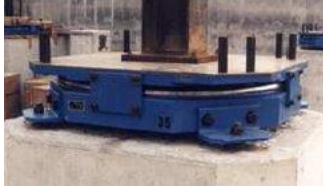
Resim 4.36. Sürtünme esaslı sismik izolatörler [62]
