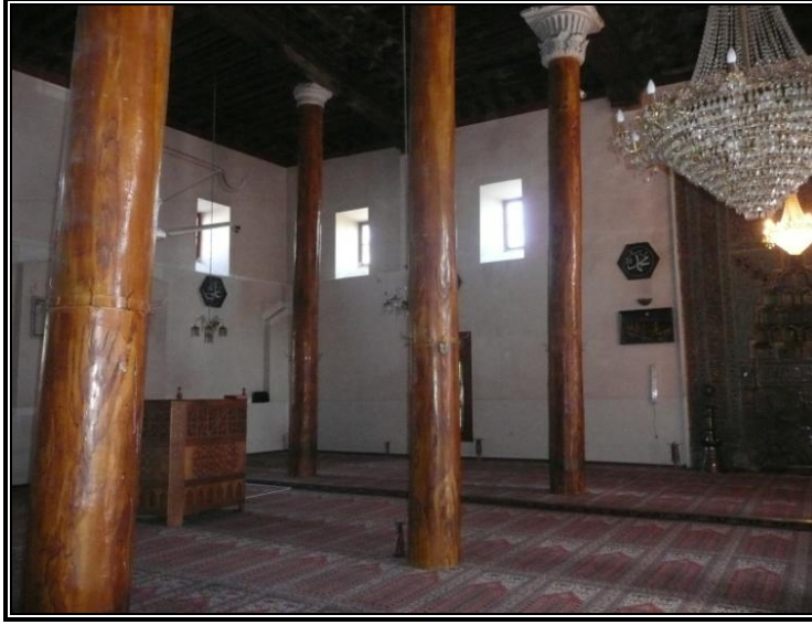
Resim 2.18. Ankara Arslanhane Camii, şakülünden sapan ahşap sütunlar, 2008 [5]
