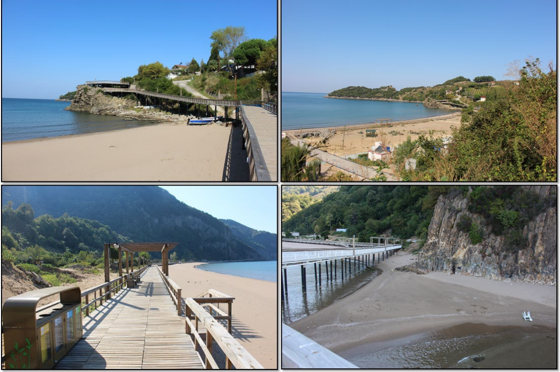
Foto 3.17: Güzelcehisar Plajı ortasından geçirilmiş demir kazıklar üzerine oturtulan ahşap platform.
