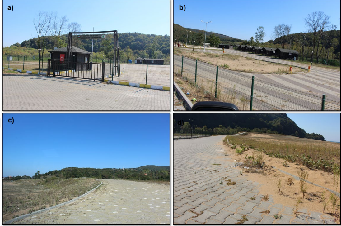
Foto 3.13: Mugada Kumulları üzerine inşa edilmiş kamp karavan alanı (a, b), kumul tepelerinin düzlenerek üzerinden geçirilen yol (c), kumul alanı üzerindeki yapılaşma sonrası kumulun hareketi (d).
