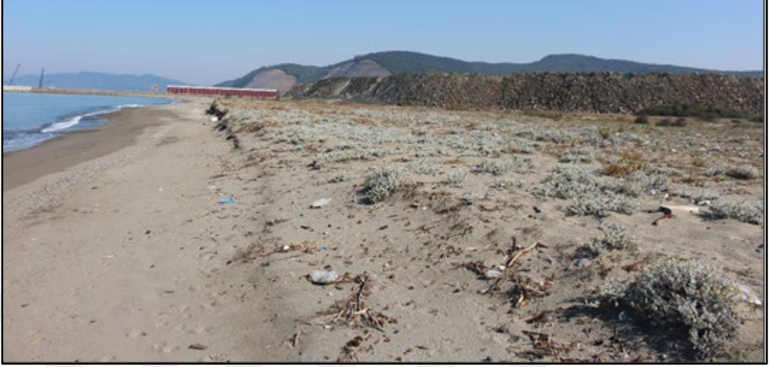
Foto 3.9: Filyos Limanı şantiye alanında kumullar üzerinde serilmiş dolgu alanı ve dolgu için kazılan yamaçlar.
