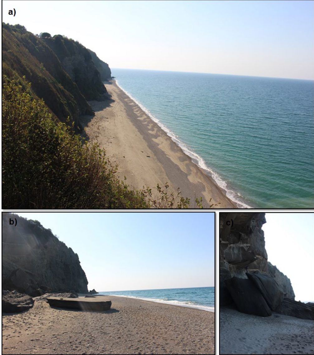
Foto 1.8: Filyos Plajı'nın batısında uzanan uzanan falezler (a) ve falezlerden düşmüş dalgalar tarafından törpülenmiş bazalt birimler (b,c).
