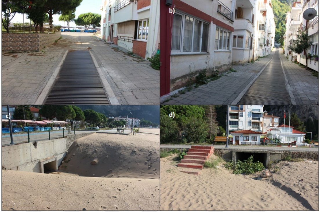
Foto 3.21: Yolun gerisinde birikebilecek suyun deşarjı için yapılan demir menfezler (a,b), yamaç boyu gelen suyu deşarjı için inşa edilen üstü kapalı beton menfez (c,d).
