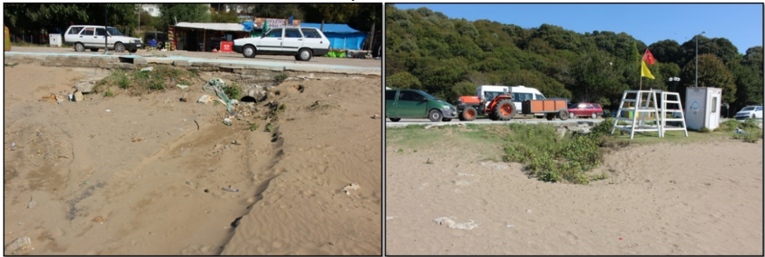
Foto 3.14: Mugada Plajı'nda küçük menfezlerin kum ve bitkiler tarafından önünün kapatılması.
