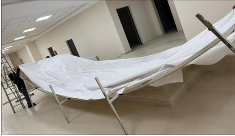
Şekil 19. Vinil kaplama malzemesinin perde üzerindeki eğimli yüzeye montajı
