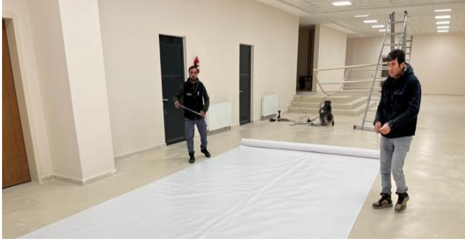
Şekil 18. Perde kaplamasında kullanılacak vinil malzemenin kesim işlemi
