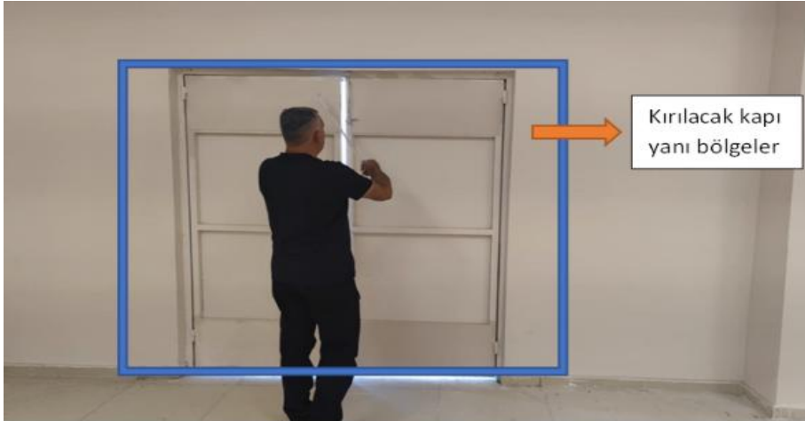
Şekil 7. Giriş kapısının genişletilmesine yönelik yapılan ölçüm işlemi
