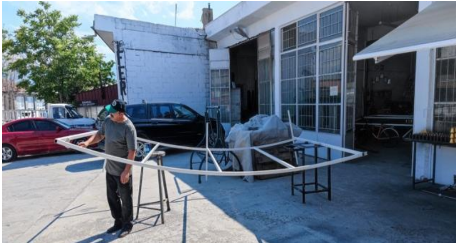
Şekil 14. Projeeksiyon perdesi dikey profillerin montajı
