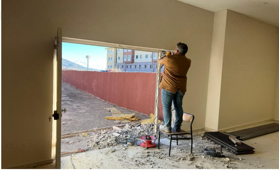
Şekil 9. Laboratuvar giriş kapısının kutu profil ile çerçevenme işlemi
