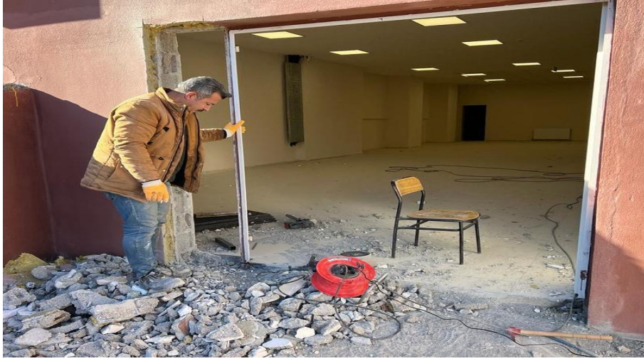
Şekil 8. Laboratuvar giriş kapısının genişletilme işlemi
