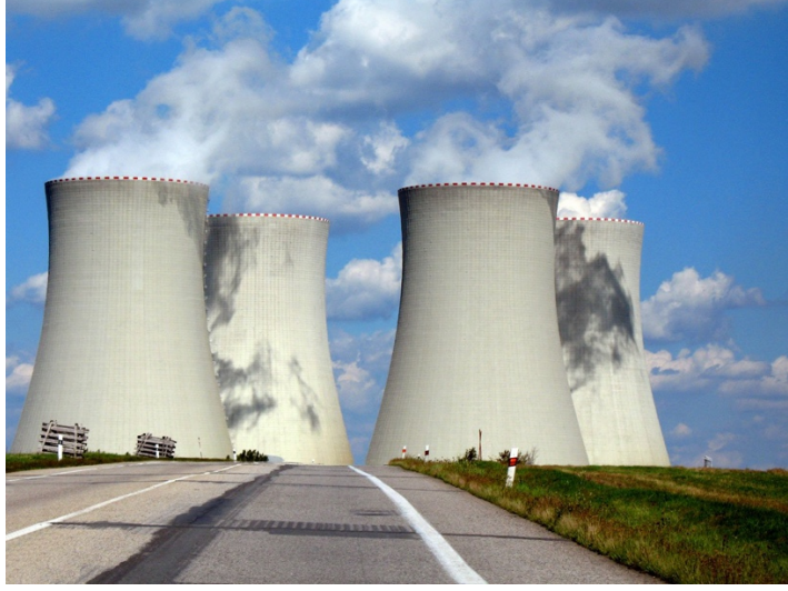
Şekil 1.2. Nükleer soğutma kuleleri
