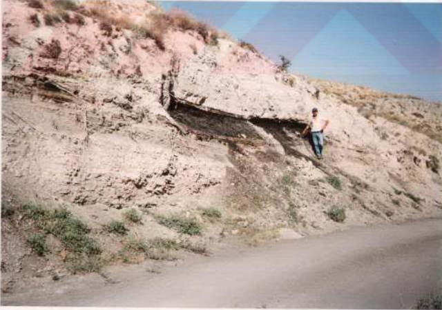
Şekil 3.54. Siğ göl fasiyesi. Silttaşı - çamurtaşı ardalanması ve kömür damarından oluşmuştur. Küçükkamışlı dere üyesi. Ağılın dere kesiti 0 - 8. metreler arası. Yeniçubuk kasabası 2.5 km. KB'sı, kömür ocaklarına giden yol yarması. Bakış KD'ya
