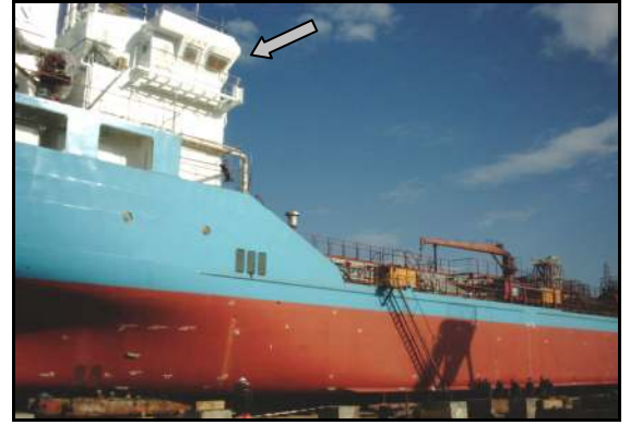
Şekil 6.53 Üst binanın boyanması.
