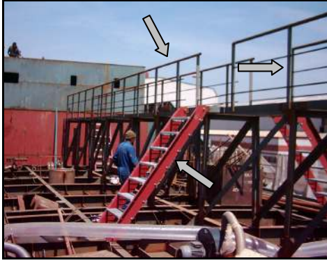
Şekil 6.56 Merdivenler ve yürüme yolları.
