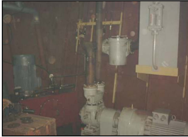
Şekil 4.15 Kıç ırgat güç hidroliği sistemi.
