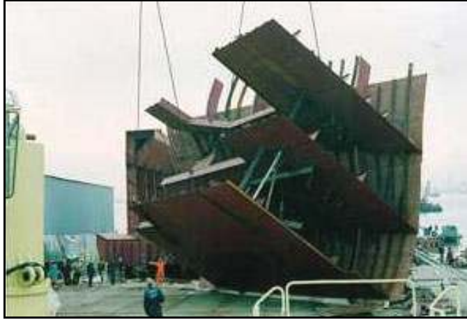
Şekil 6.38 Bloğun kaldırılması ve çevirilmesi operasyonu. [12]
