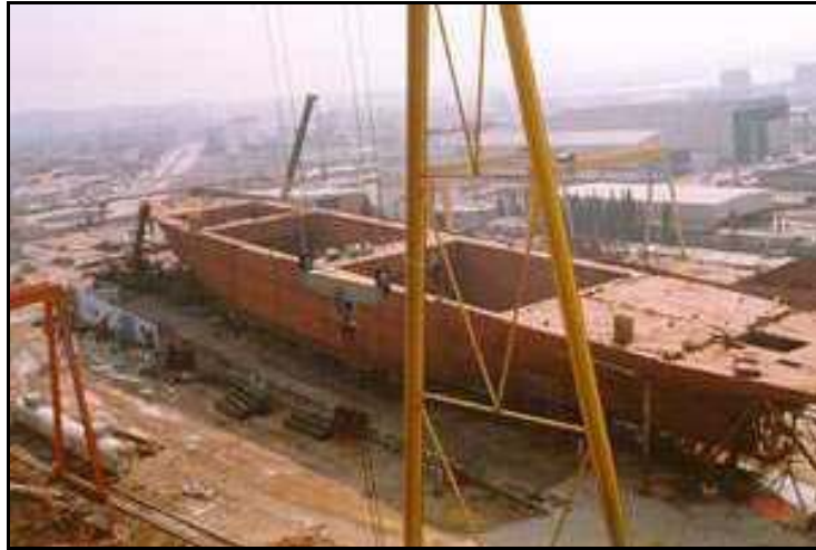
Şekil 6.47 Kızakta montajı devam eden bir dökme yük gemisinin çelik teknesi. [12]
