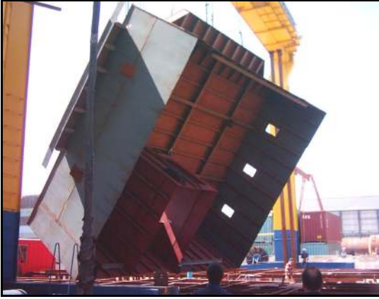
Şekil 4.5 Bloğun montaj için kaldırılması.
