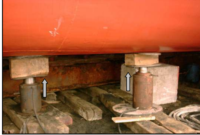
Şekil 7.13 Krikolar ile kaldırma işlemi.
