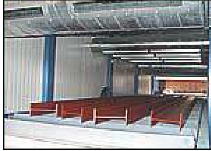
Şekil 6.23 Shop-primer boyama işlemi. (Şen, 2004)
