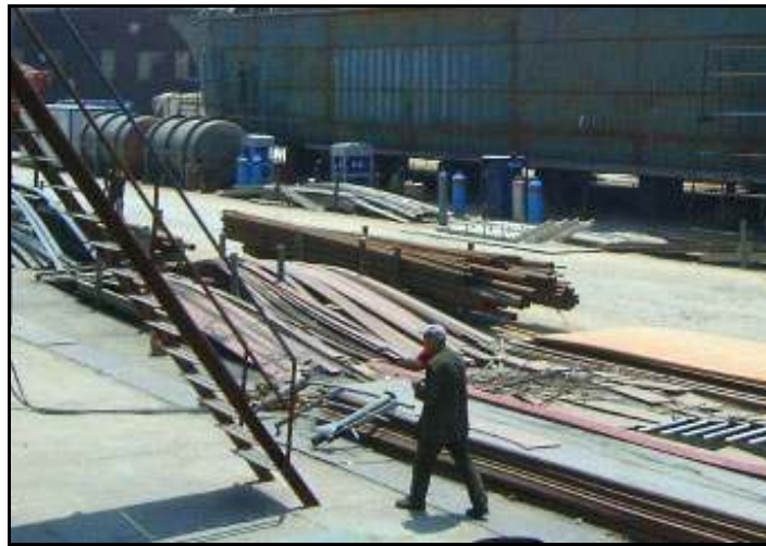
Şekil 6.7 Siyah boruların açık sahadaki istif sepetlerinde stoklanması.
