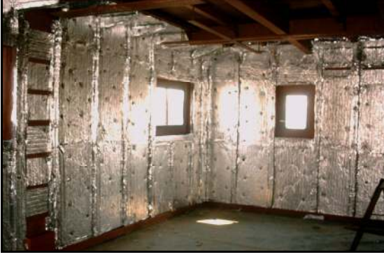
Şekil 4.29 Üst bina yangın izolasyonu.
