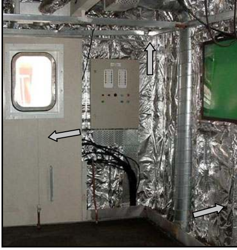
Şekil 6.65 İç mekanların izole edilmesi. [15]
