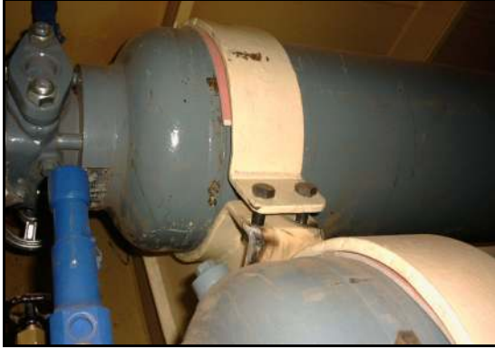
Şekil 4.13 Basınçlı hava tüpleri.
