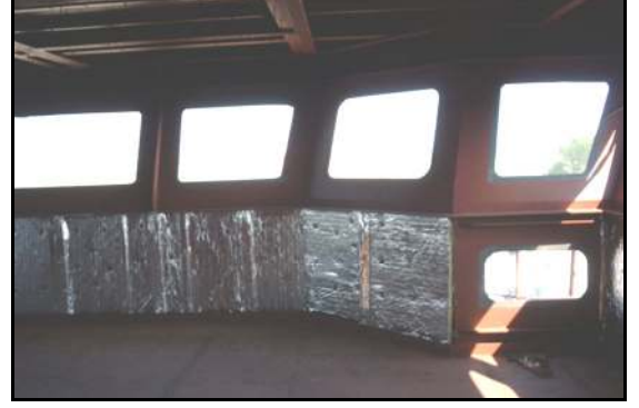
Şekil 4.30 Köprü üstü yangın izolasyonu.
