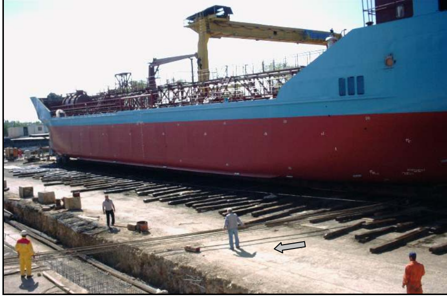
Şekil 7.15 Uygun doğrultu için yana doğru kaydırma operasyonu.
