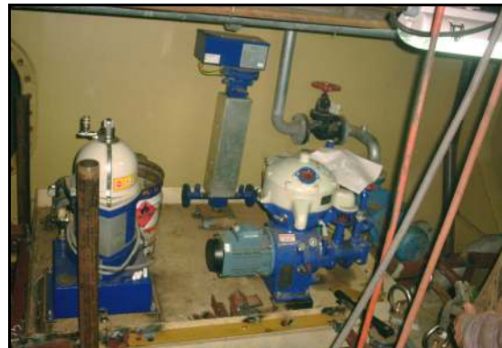
Şekil 4.12 Yakıt ve yağlama seperatörleri.
