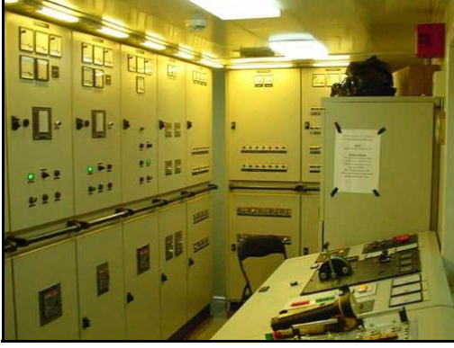
Şekil 4.24 Makina dairesi ana kontrol panosu. [15] Şekil 4.25 Jeneratör kontrol panosu.
