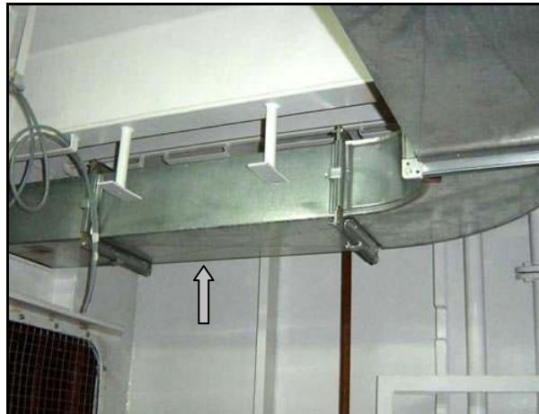
Şekil 6.68 Yaşam mahali ve makina dairesi havalandırma kanalları. [15]
