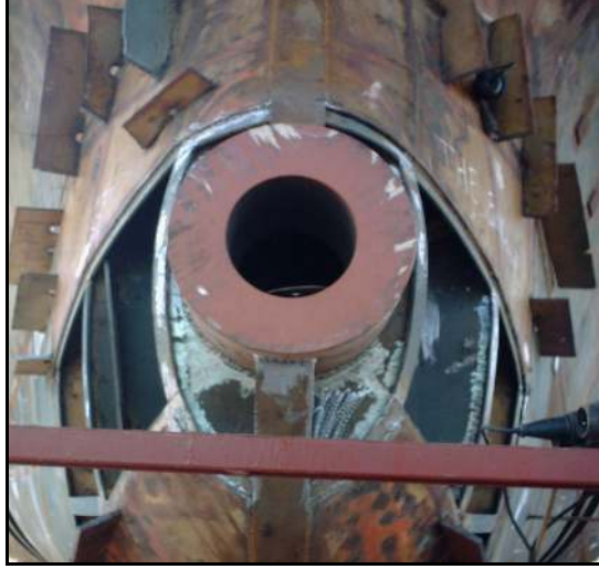
Şekil 4.17 Şaft bosaı montajı.
