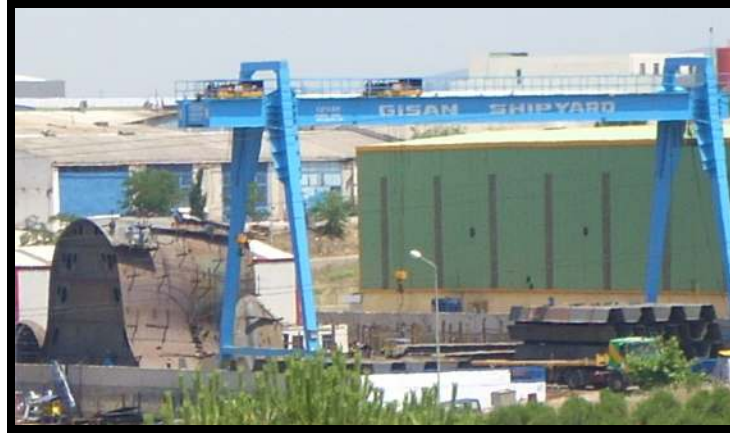
Resim–5.12 T.ö.s.t.b.’de yer alan bir tersaneye ait tesislerde geminin baş bölümüne ait blok kısmı (kaynak: yazar )
