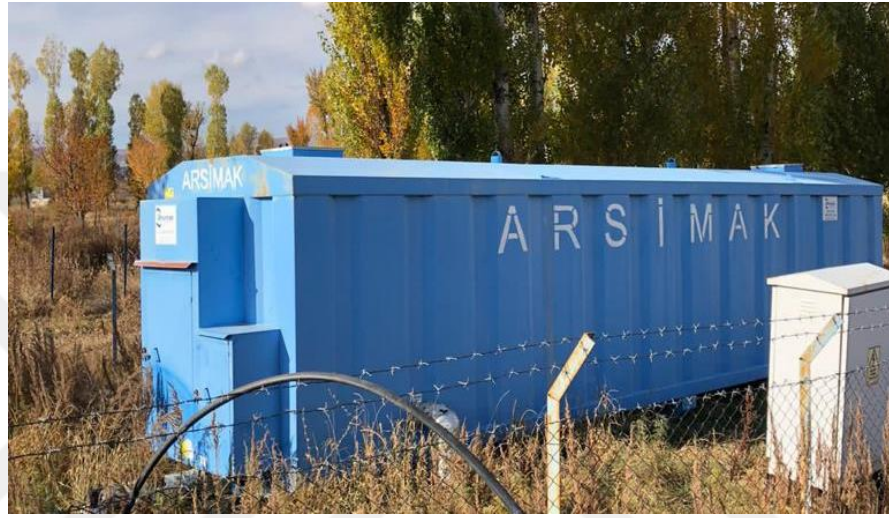
Şekil 3.7. 100 m 3 kapasiteli Arsimak marka paket arıtma sistemi
