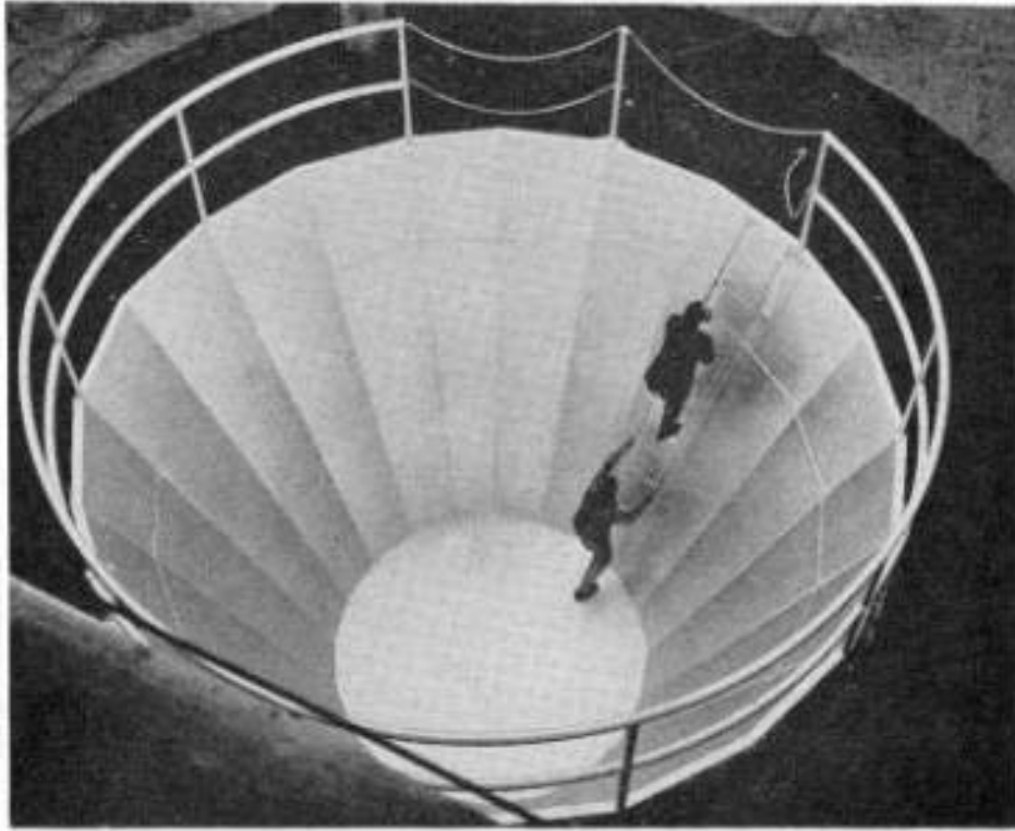
Resim 4.2. Büyük patlayıcı yardımı ile form verme tankı [1].
