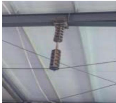
Şekil 1.2 Ard germe halatı ve takoz detayı (Yu-qing, 2021)
