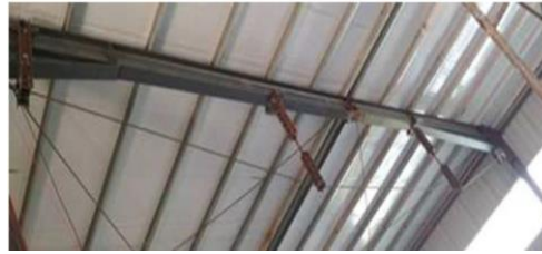
Şekil 1.1 Ard germe halatı ve takozlarla çelik makas tasarımı (Yu-qing, 2021)
