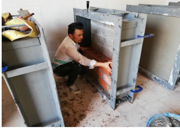
Şekil 3.19. Deney elemanlarının yapım aşamasında tuğla duvar örülmesi
