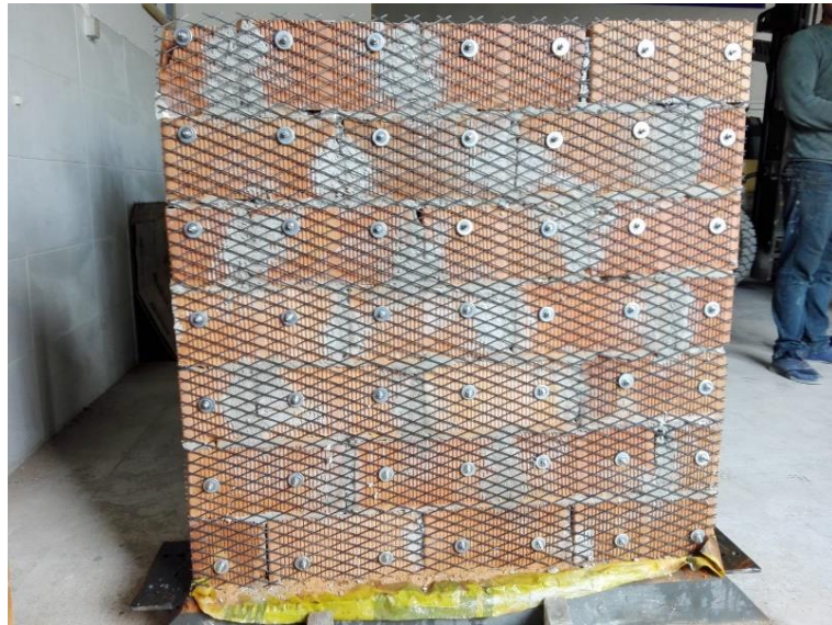
Şekil 3.22. Deney elemanlarının yapım aşamasında ankraj yapılması
