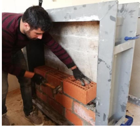
Şekil 4.18. Deney elemanlarının yapım aşamasında tuğla duvar örülmesi
