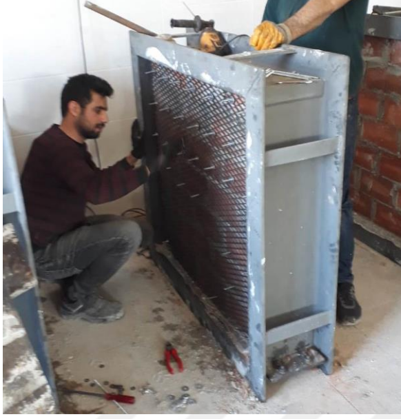
Şekil 4.21. Deney elemanlarının yapım aşamasında ankraj yapılması
