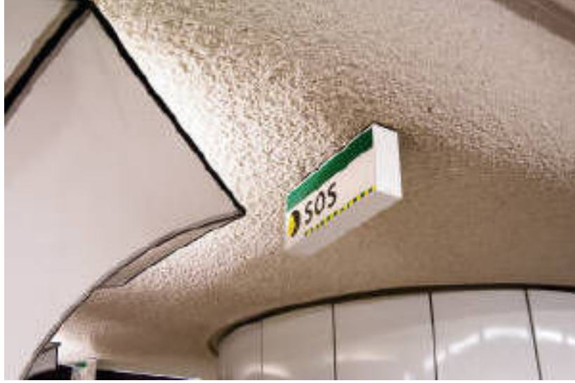
Şekil 2.18. Vermikülit Esaslı Tavan Sıvası Uygulaması [62].
