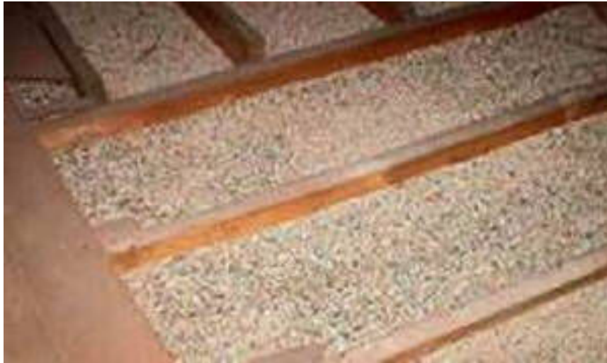
Şekil 2.19. Genleştirilmiş Vermikülitin Isı Yalıtımı İçin Tavan Arasına Serilmesi [62].
