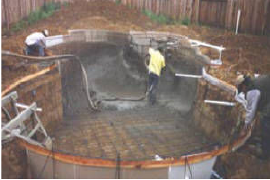
Şekil 2.21. Havuz Tabanında Püskürtme Genleştirilmiş Vermikülit Uygulaması [62].
