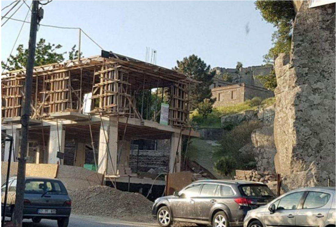
La construction qui a causé les mouvements de « Assos'uma Dokunma ! » 166
