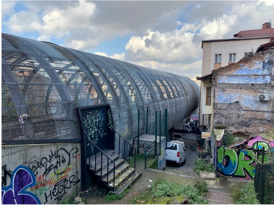
Le tunnel de métro dont une partie se trouve à Küçükpazar 184
