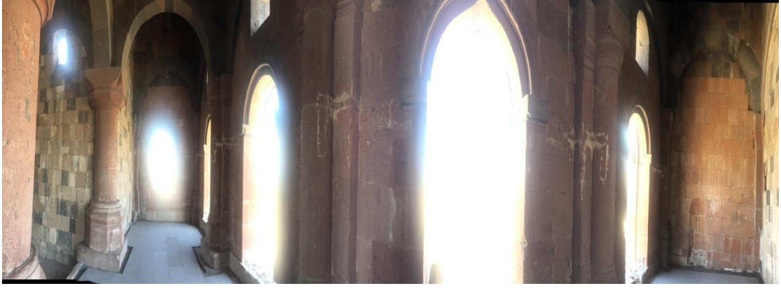
Şekil 26. Manuehr Camii'nin iç kısmının panoramik görüntüsü.
