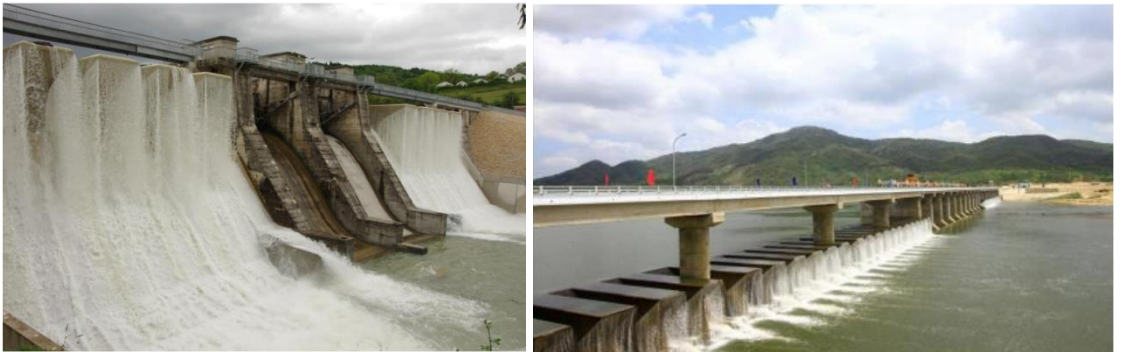
řekil 3.13 Charmines Barajı (Fransa) ve Van Phong Barajı (Vietnam)
