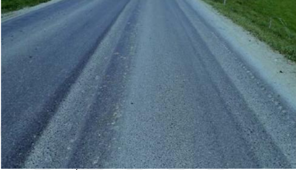
Şekil 2.15. Tekerlek İzi (Mazlum, 2014)
