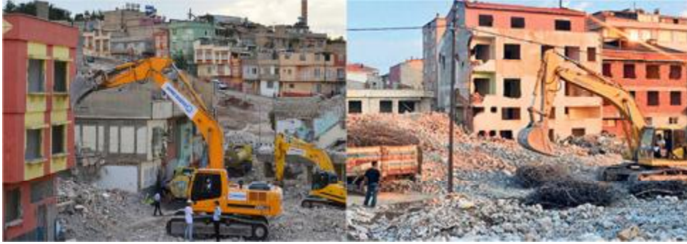
Şekil 1.3. Basından Kentsel Dönüşüm Kapsamında Yıkım Görüntüleri ( www.milliyet.com.tr )
