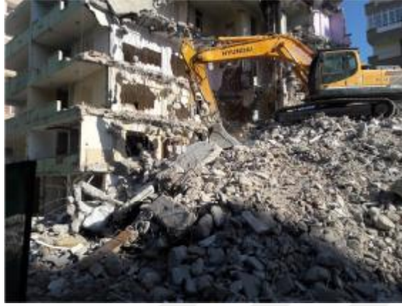
Şekil 1.4. Adana'dan Kentsel Dönüşüm Kapsamında Bir Yıkım Görüntüsü
