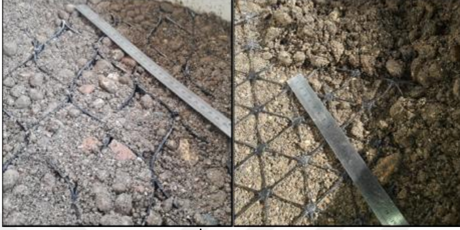
Şekil 3.40. Donatının Yerleştirilme İşlemi (Geocell ve Geogrid)
