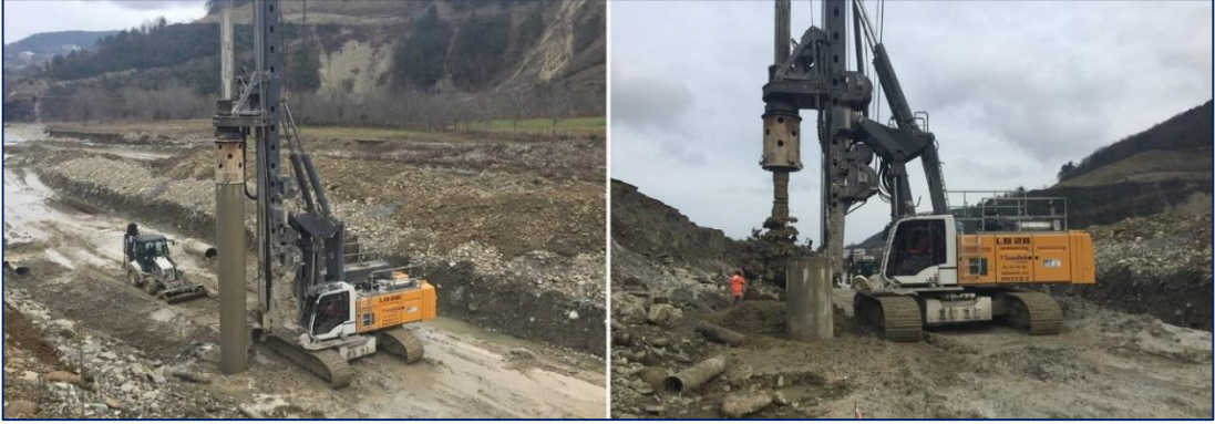
Şekil 3.10.Fore Kazık uygulaması ( https://www.temeltek.com.tr/en/dikmen-project-bored-pile-works/ )
