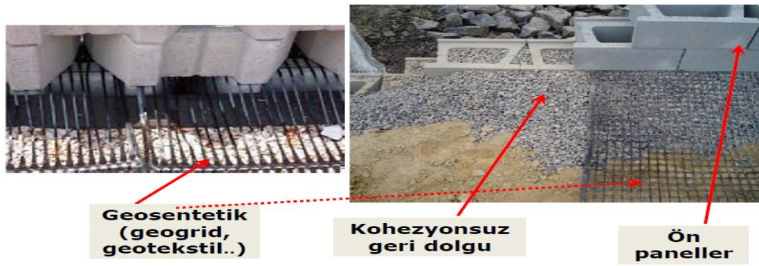
Şekil 2.9. Geosentetiklerle zemin güçlendirmesi
