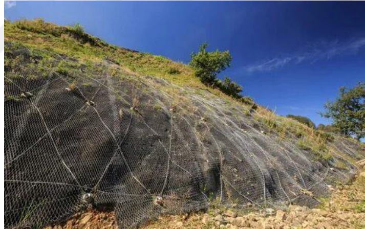
Şekil 2.3. Su değişiminden kaynaklı heyelana karşı geonet kullanımı
