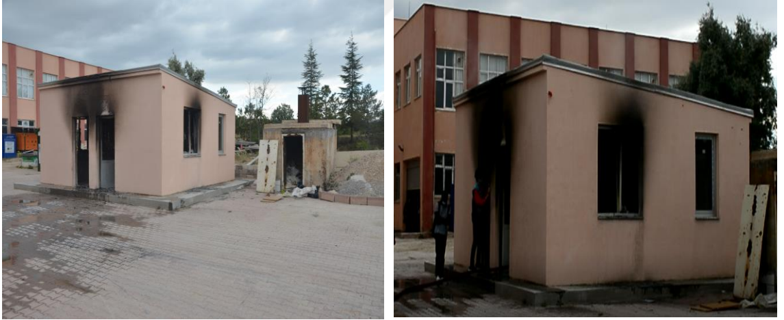
Şekil 3.21. Yatak odası yangın sonrası dış cephe görseli
