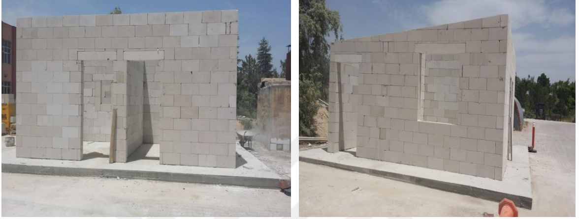
Şekil 3.5. Kaba inşaat aşamasından dış cephe görselleri
