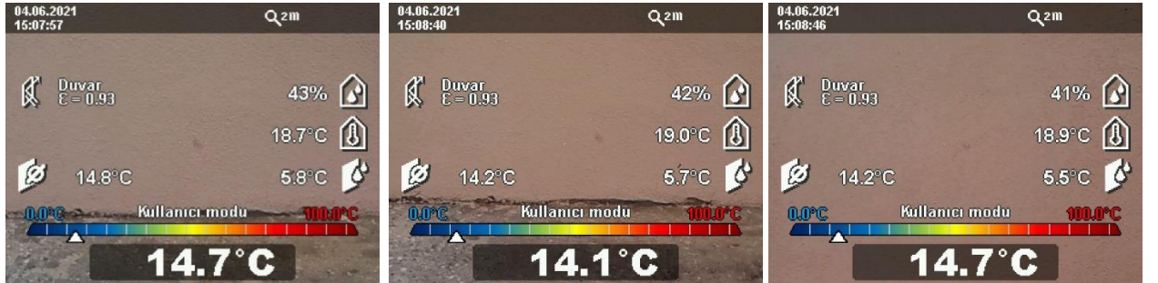
Şekil 4.7. Oturma odası yangın sonrası dış duvar yüzey sıcaklık ölçümleri
