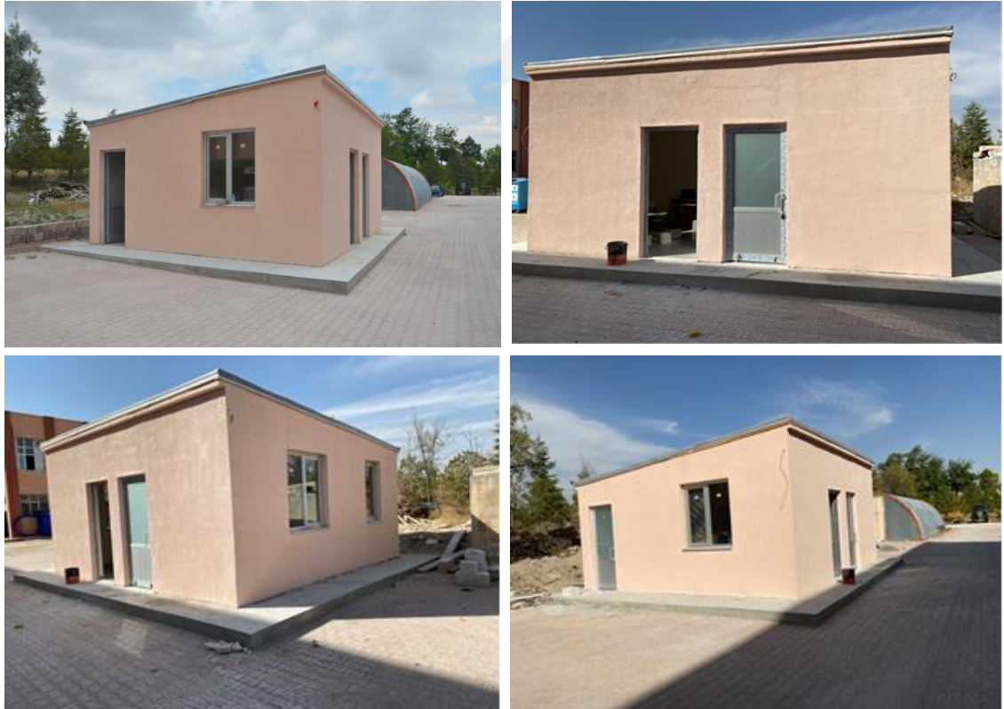
Şekil 3.8. Yangın deney binası tamamlanmış dış cephe görselleri
