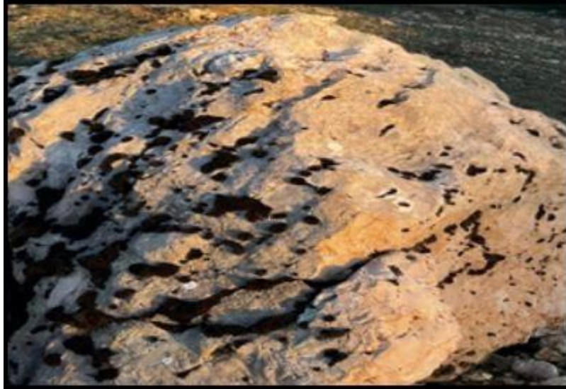
Şekil 4.55. Soğukçam Formasyonuna ait kireçtaşlarında gözlenen çatlak takımları
