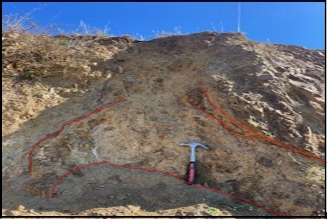
Şekil 4.49. Ilıcadere Volkanitlerine ait Bıçakçılar-Gaziler mevkiinde gözlenen çatlaklı yapılar.
