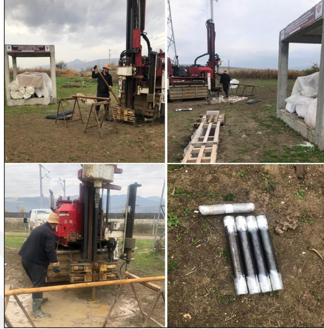
Şekil 4.4. Zemin etüdü kapsamında yapılan sondaj çalışması ve UD örnekleri.
