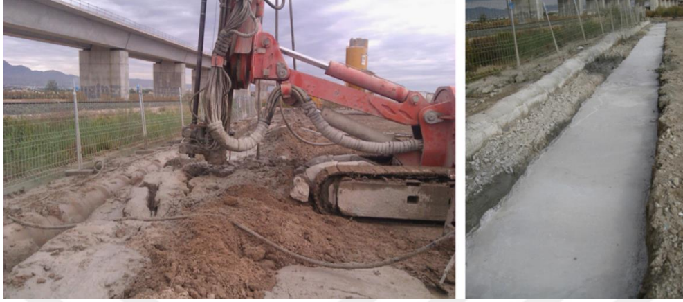
Şekil 1.3. Jet grout kolonlarının yapımı ve rijit dalga bariyeri uygulaması (Coulier ve ark, 2014).
