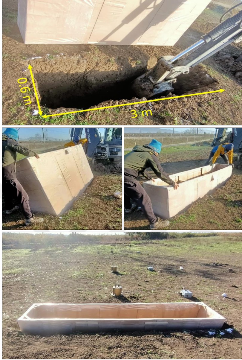
Şekil 4.15. Kutu bariyer prototipinin hendeğe yerleştirilmesi.
