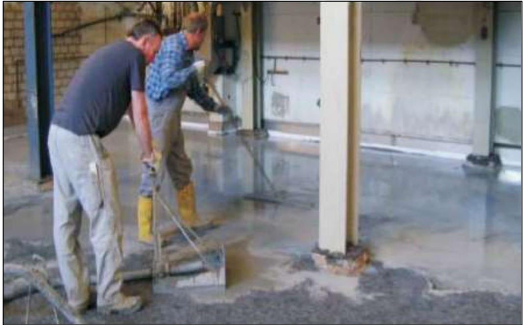
Şekil 2.2 SIFCON'da bulamaç enjekte işleminin uygulanması (Canbay, 2014)
