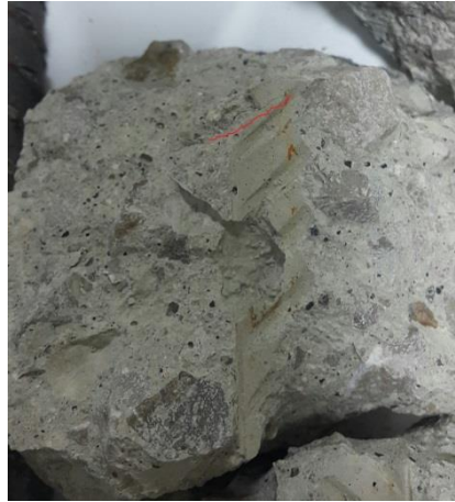
Şekil 4.59 Yüzeye çıkmayan çatlaklar
