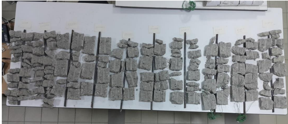
Şekil 3.22 Aderans numunelerin iç çatlaklarının görünümü
