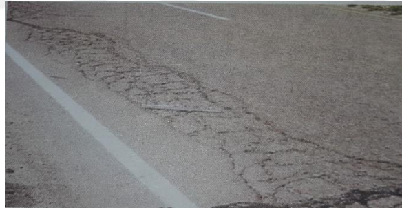
Şekil 2.13. Yorulma Çatlağı [1]
