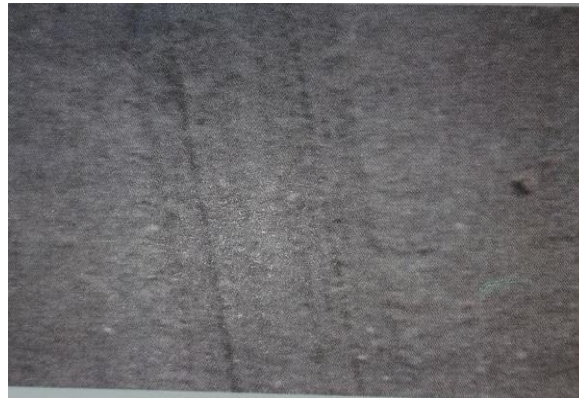
Şekil 2.16. Asfaltta Kuma [1]
