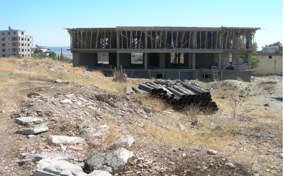
Ek 44. Resim 29 K-10'daki Mozaikli Kesitin Bulunduğu İnşaat
