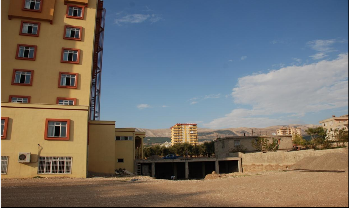
Ek 46. Resim 31 Şeyh Adil Mah. 4316 Ada 11 Parselde Yer Alan Yurt Binası
