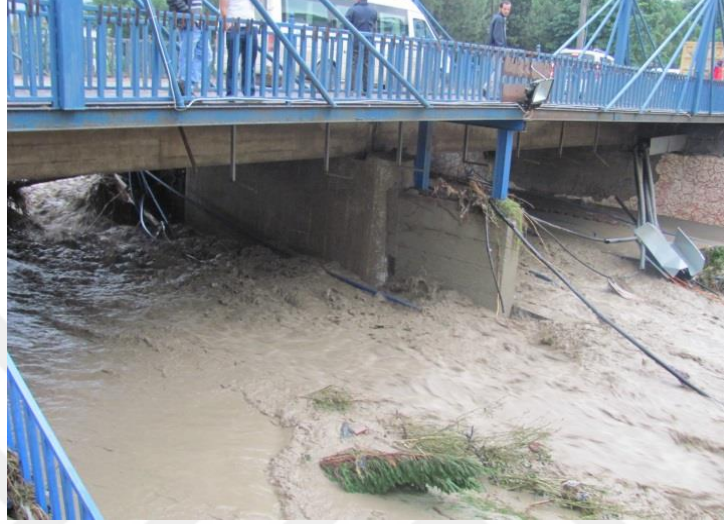
Şekil 5.7. Taşkın sonucu oyulan köprü ayakları [31].
