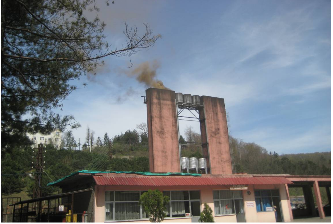
İşletmenin tüm önlemlere rağmen çevreye vermiş olduğu zararların gözlemlenmesi.
