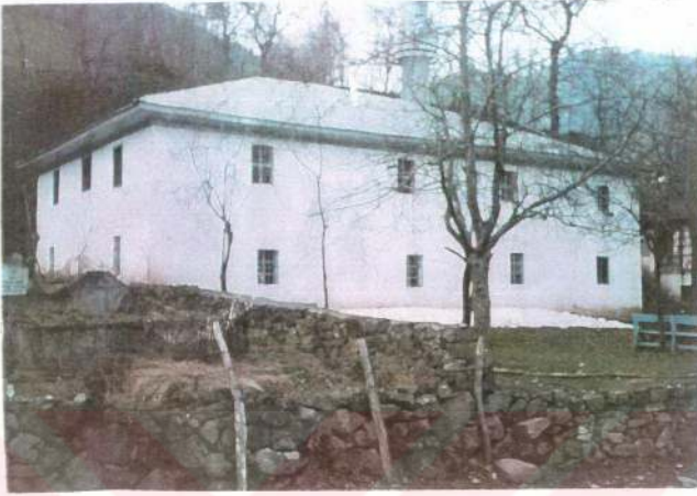
Fotoğraf 34: Akkaya Köyü Camii
