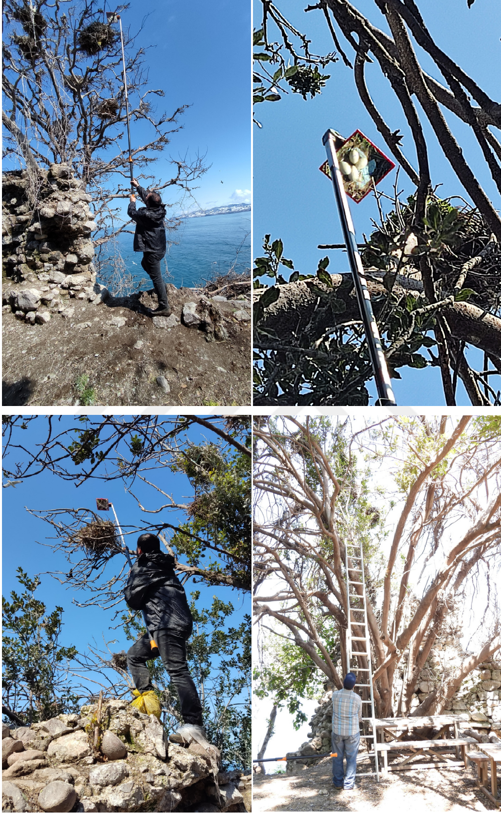
Şekil 11. Ada içerisinde merdiven ve malzeme kullanımı
