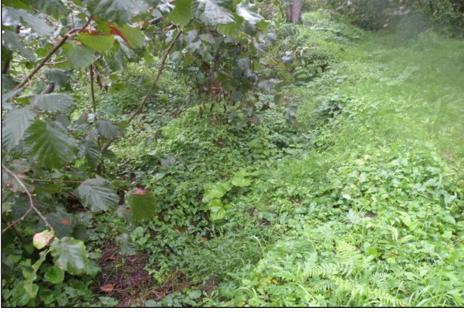
Şekil 60. Heyelanlı alanda oluşmuş gerilme çatlağı
