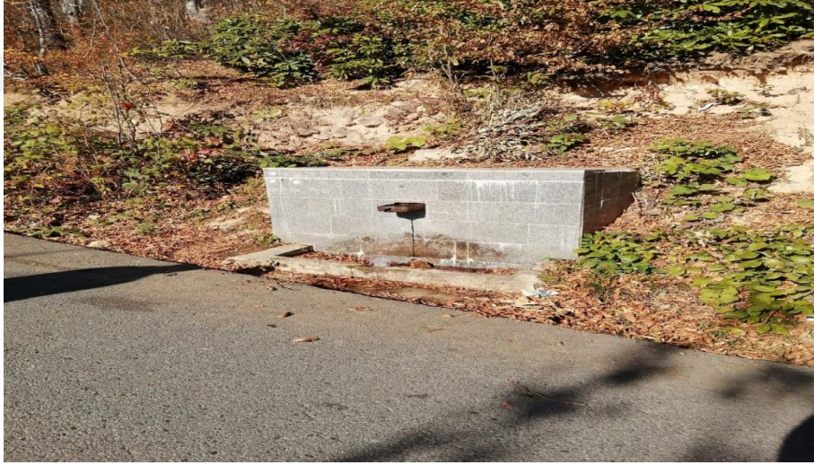
Şekil 3.19. Genel Görünüm İstasyon 18
