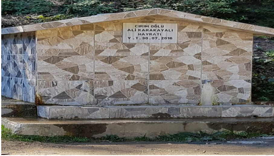
Şekil 3.4. Genel Görünüm İstasyon 3
