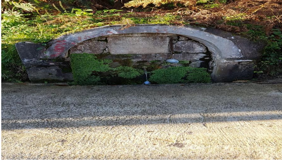
Şekil 3.11. Genel Görünüm İstasyon 10
