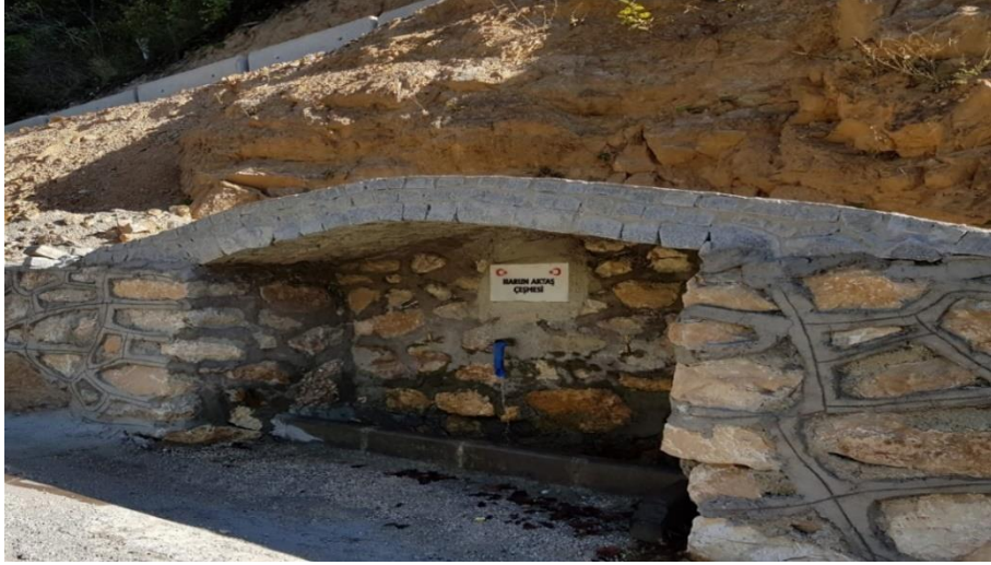
Şekil 3.2. Genel Görünüm İstasyon 1
