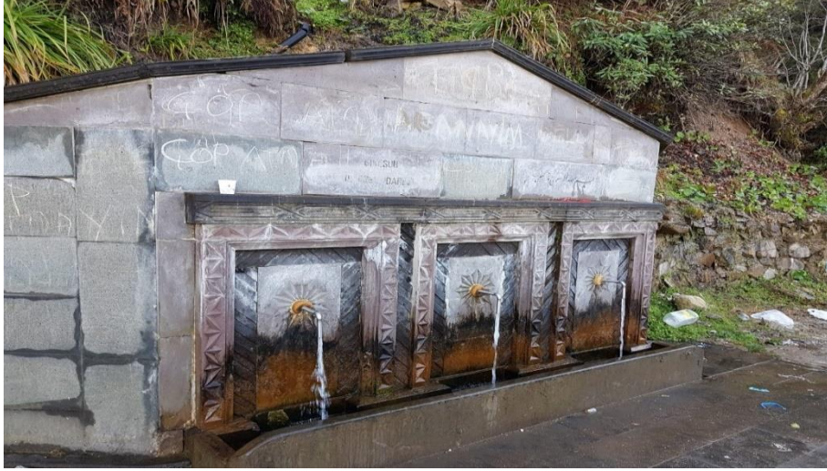
Şekil 3.12. Genel Görünüm İstasyon 11
