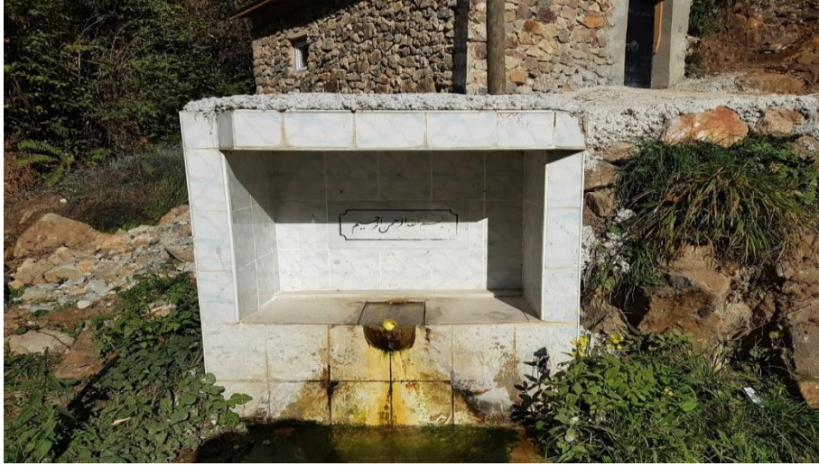
Şekil 3.20. Genel Görünüm İstasyon 19
