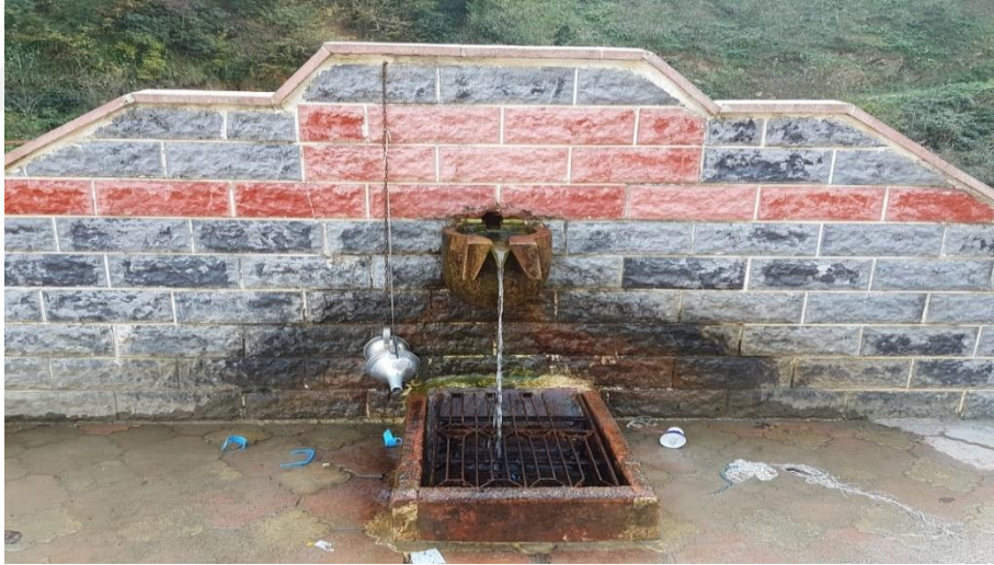
Şekil 3.21. Genel Görünüm İstasyon 20
