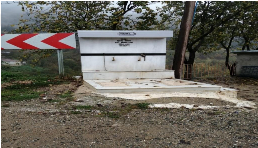
Şekil 3.7. Genel Görünüm İstasyon 6
