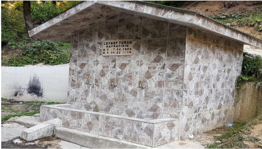
Şekil 3.5. Genel Görünüm İstasyon 4
