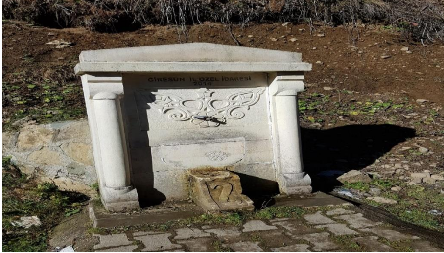
Şekil 3.14. Genel Görünüm İstasyon 13
