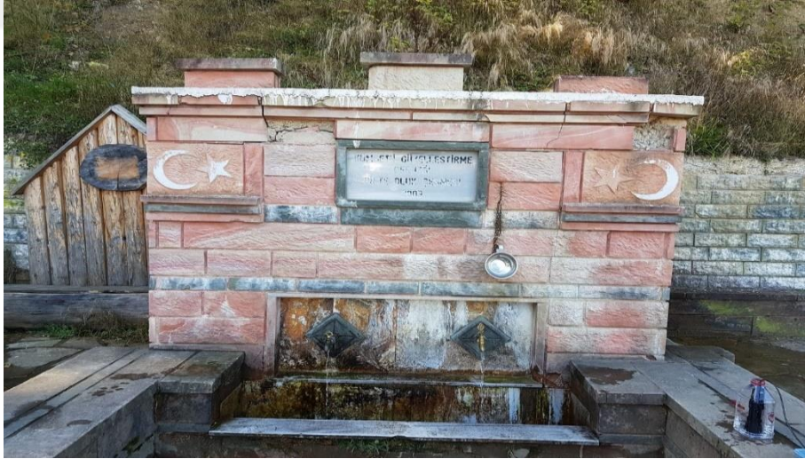
Şekil 3.3. Genel Görünüm İstasyon 2
