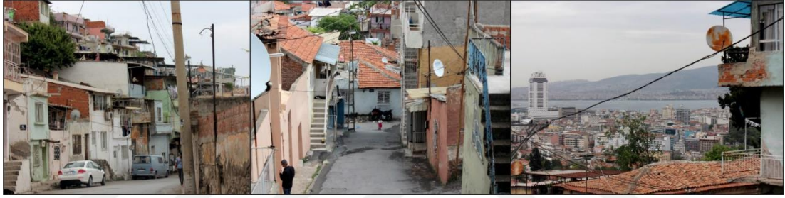
Şekil 5.20 Akarcalı Mahallesi'nden görünüm (Kişisel arşiv, 2017)
