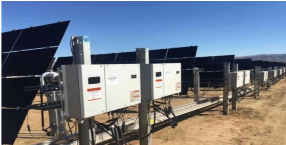
Şekil 1.23 Güneş santrali dizi tipi solar çevirici
