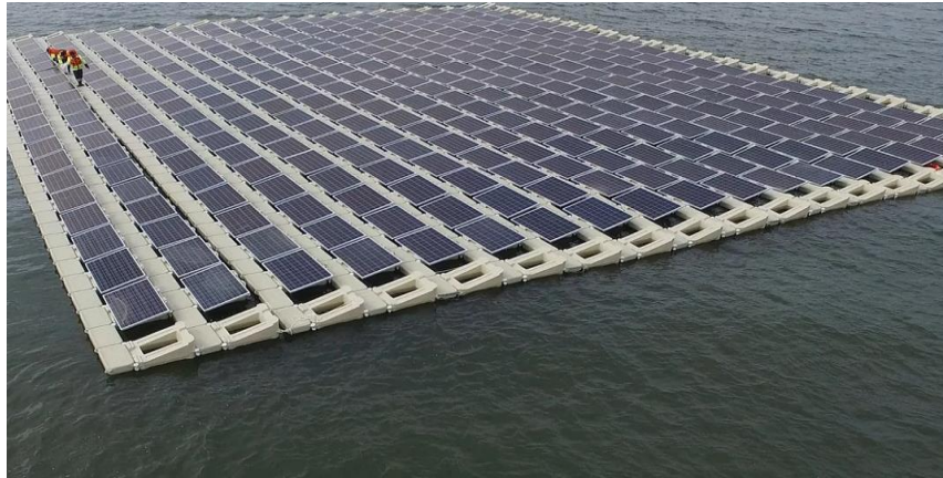
Şekil 1.26 Yüzer güneş enerji santrali Büyükçekmece gölü [52]
