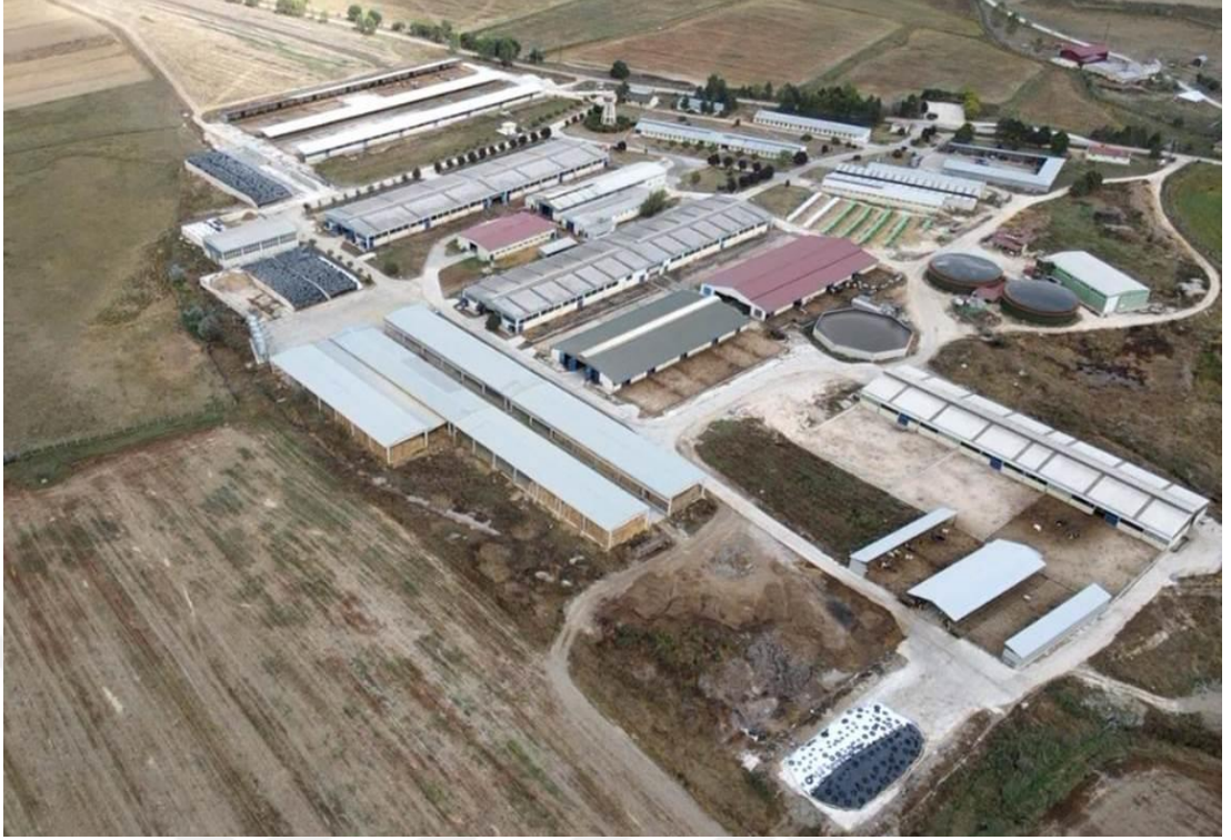
Şekil 3.1 İşletmenin güney yönünden kuşbakışı görünümü
