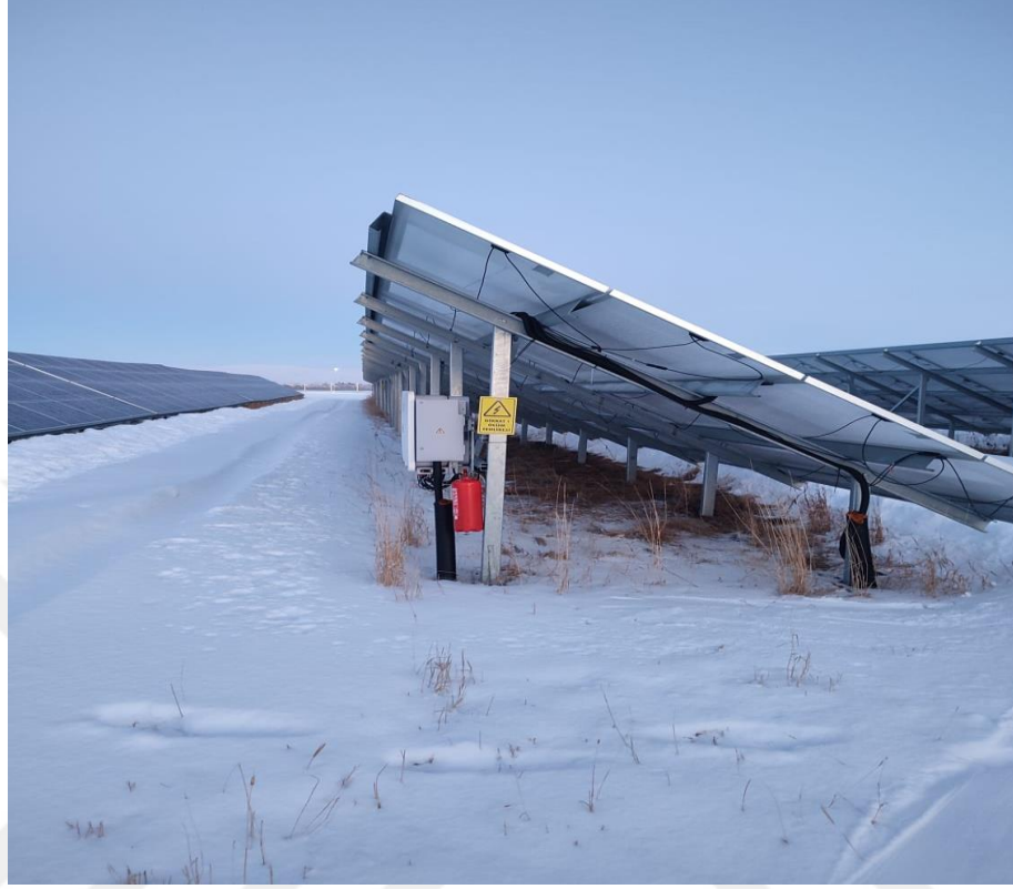
Şekil 2.8. Zemin tipi panel taşıyıcı sistem
